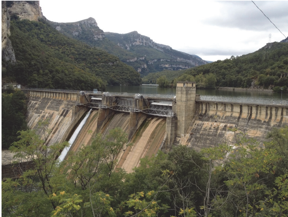
Figura 7. Vista de la presa del embalse
