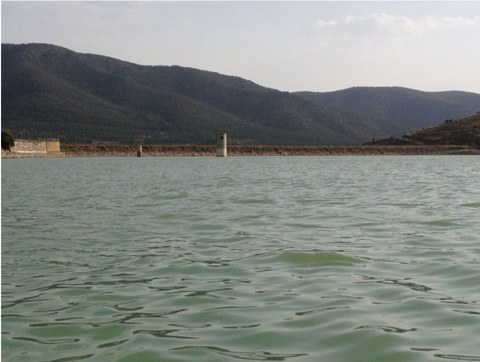
Figura 7. Vista de la presa del embalse.
