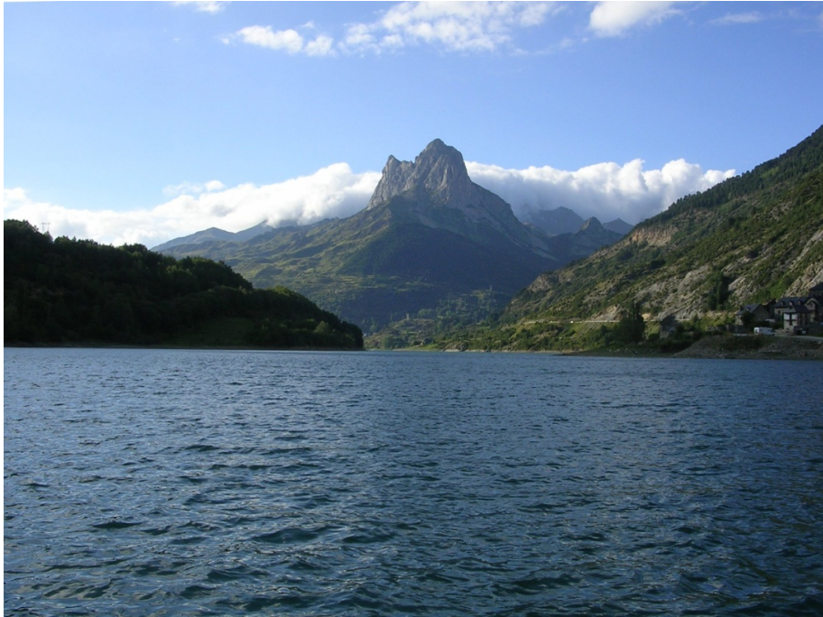
Figura 9. Vista de la cola del embalse
