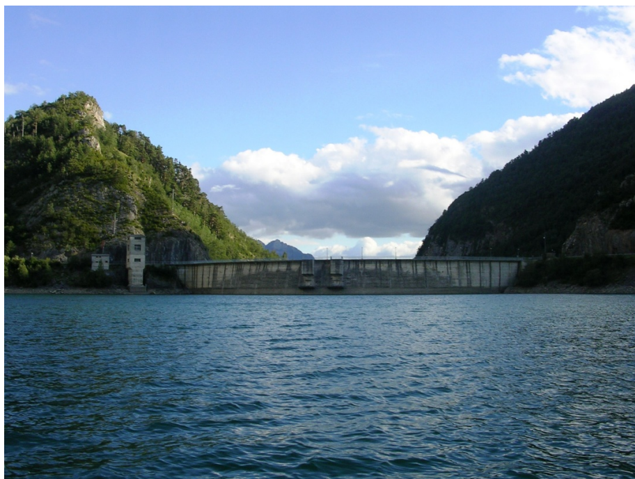
Figura 7. Vista de la presa del embalse
