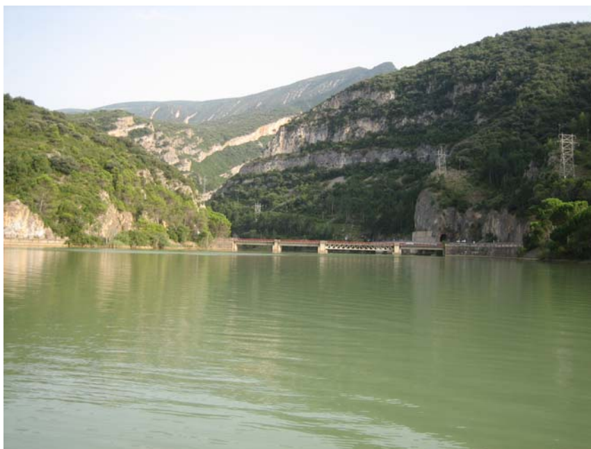
Foto 1: Vista general del embalse hacia el puente
