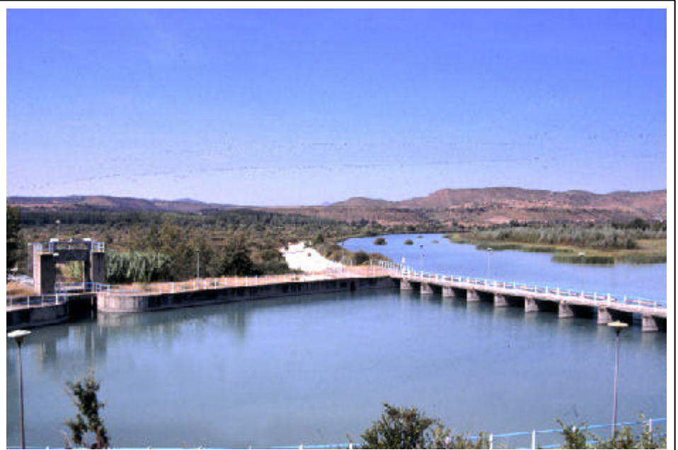
Foto 1.- Azud del salto de Arias I. Ocupa todo el cauce del Cinca. La toma, en la izquierda del azud, detrae casi todo el caudal que transporta en Cinca. La entrada al canal está regulada por compuertas. Hay mucha vegetación en las orillas y en el agua.
