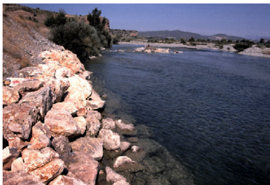
Foto 3.- Escollera en el margen derecho aguas arriba de la toma de la piscifactoría. El río dispone de un caudal mayor pero la vena de agua ocupa sólo una pequeña parte del cauce. Los sauces de porte arbustivo dominan en las orillas de este tramo.
