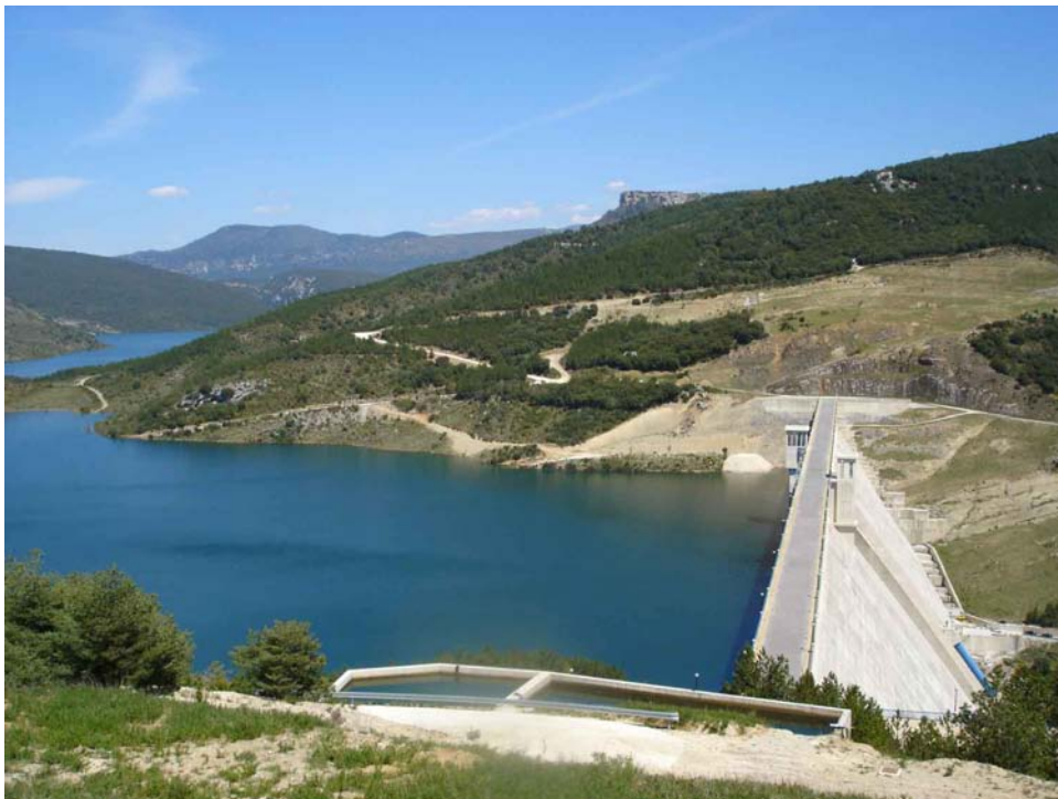
Figura 1: Aspecto del embalse de Itoiz, zona de presa.
