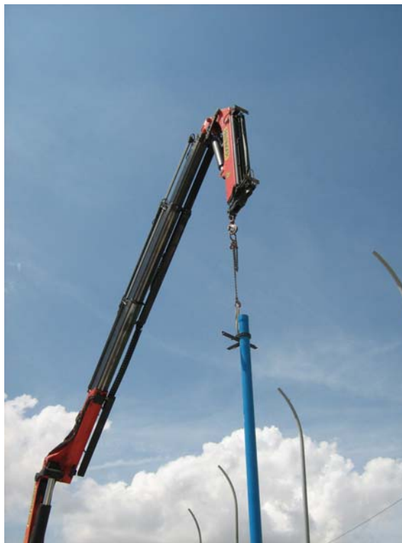
Elevando un tramo de tubería
