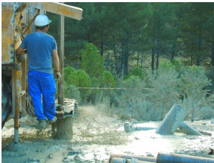
Reperforación con el martillo de 280 mm
