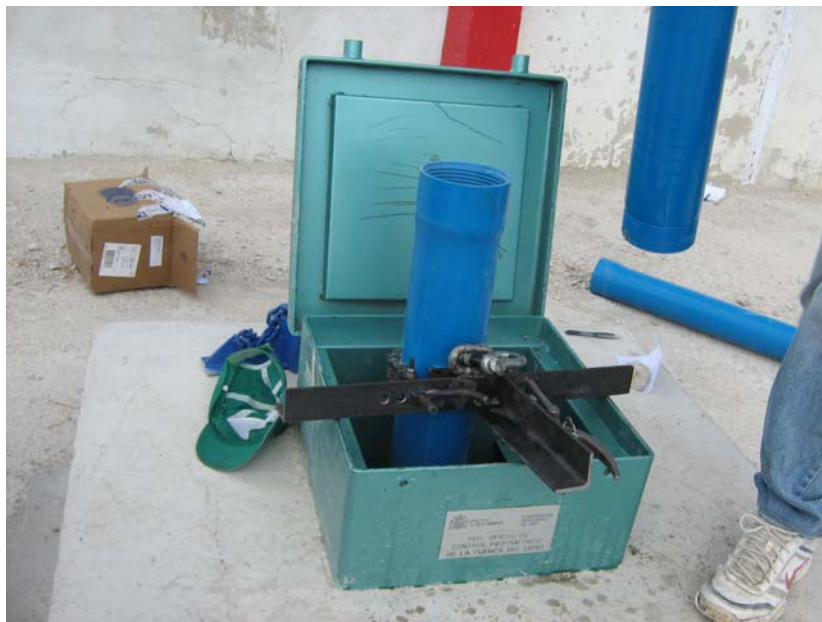
Sujeción de la tubería antes de enroscar un nuevo tramo
