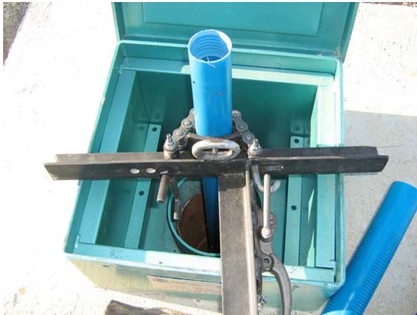
Sujeción de la tubería de 60 mm de diámetro durante la entubación
