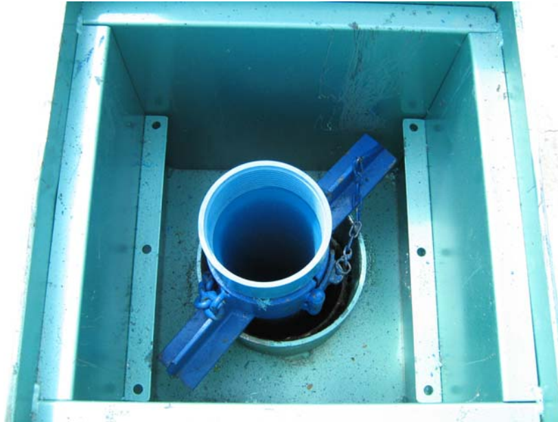
Sujección final de la tubería
