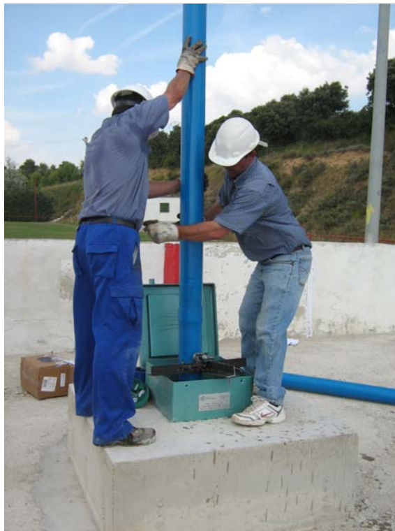
Enroscando dos tramos de tubería
