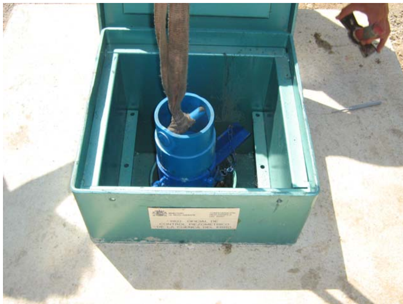
Cinta y pieza utilizadas para elevar e introducir la tubería
