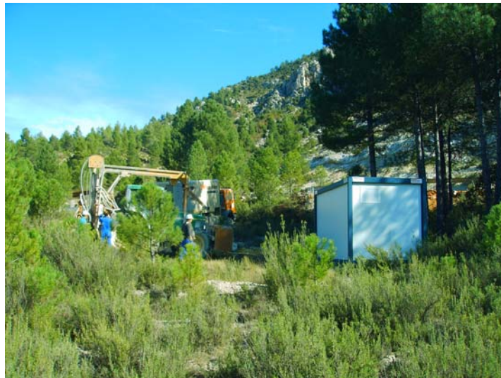
Emplazamiento del equipo de perforación
