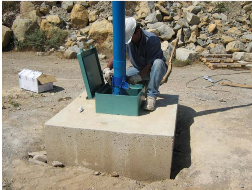
Colocando la sujeción a la tubería de 125 mm de diámetro
