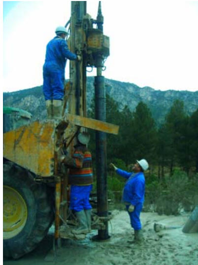
Entubación de la tubería de 230 mm
