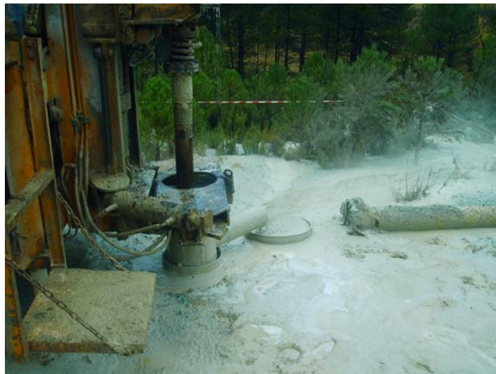
Maniobras de perforación
