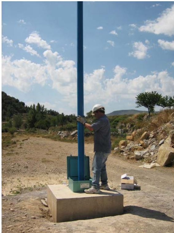
Enroscando dos tramos de tubería
