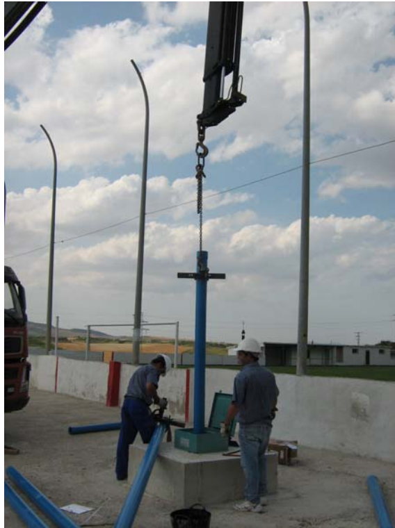
Introduciendo la tubería
