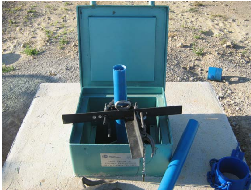
Sujección de la tubería de 60 mm de diámetro durante la entubación
