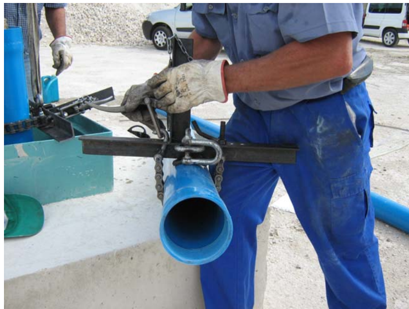
Elemento que servirá de unión con el cablestante del camión "pluma" para elevar la tubería
