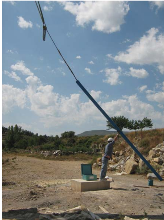
Elevando un tramo de tubería de 125 mm
