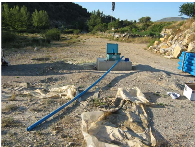
Tramo de 5 metros de tubería ciega de 60 mm preparada para ser introducida
