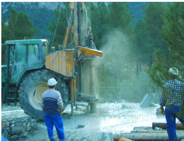
Limpieza tras el atranque de los 171 m
