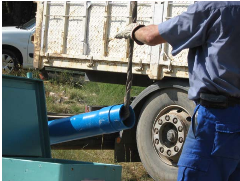
Elevando un tramo de tubería
