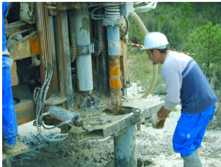
Colocación de la trialeta
