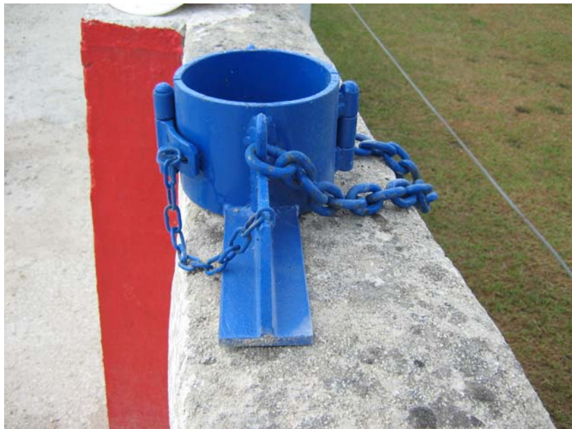
Pieza definitiva que sujetará la tubería. Vista lateral
