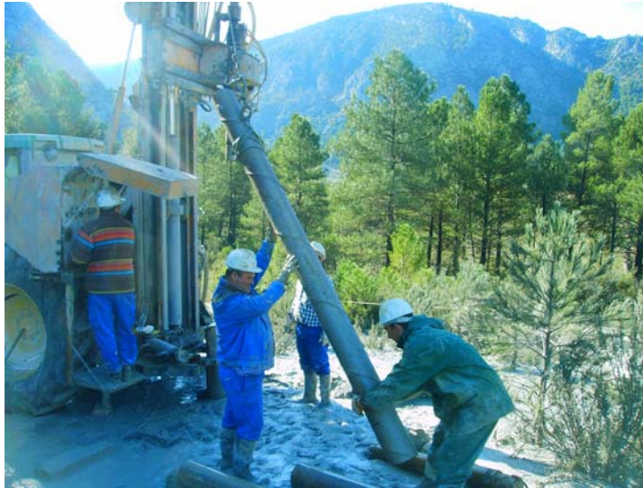
Colocación de la tubería de 180 mm
