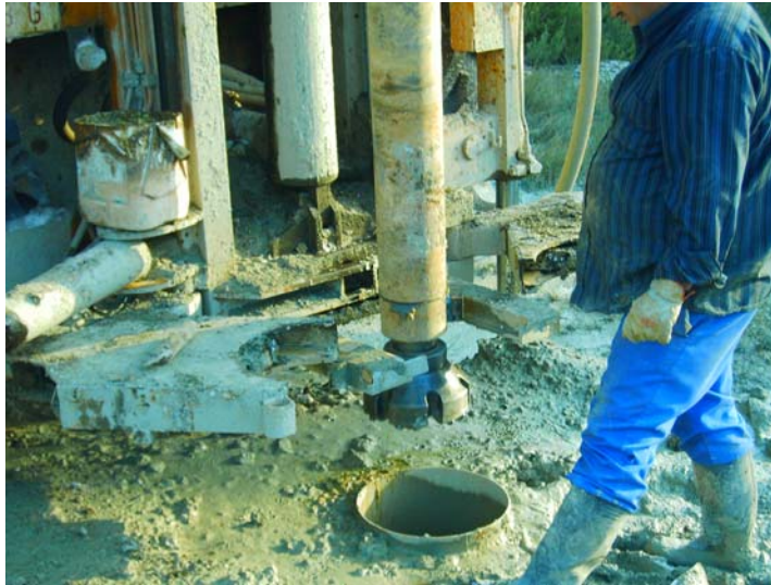
Colocación del martillo de 280 mm
