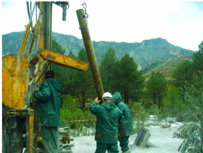
Entubación de la tubería de 180 mm
