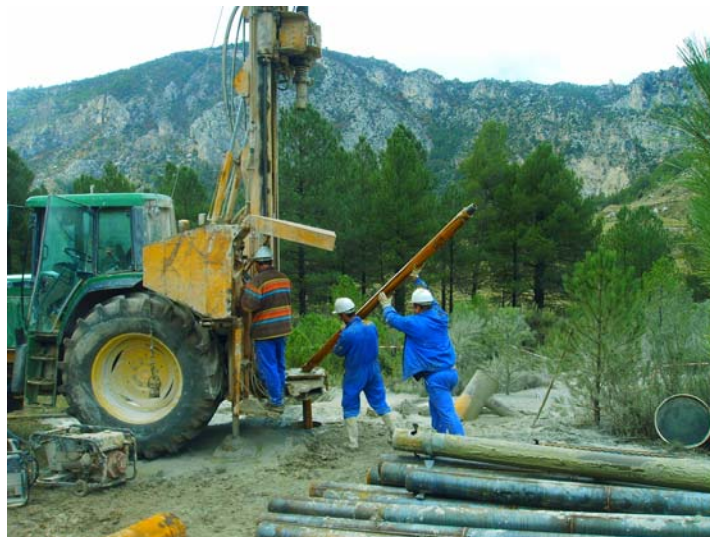
Introducción de la maniobra con el martillo de 165 mm
