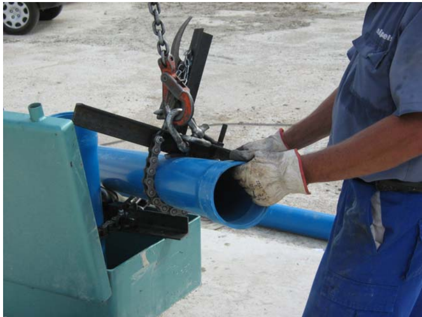
Cablestante unido a la tubería antes de ser elevada
