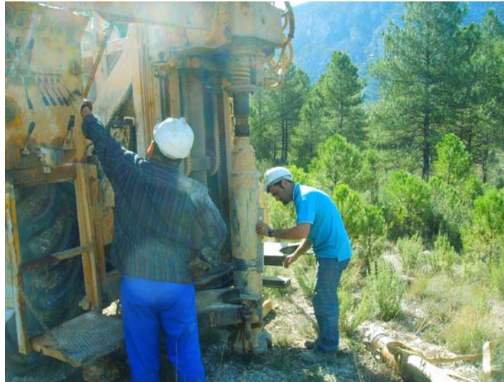
Nivelación de la maquina perforadora
