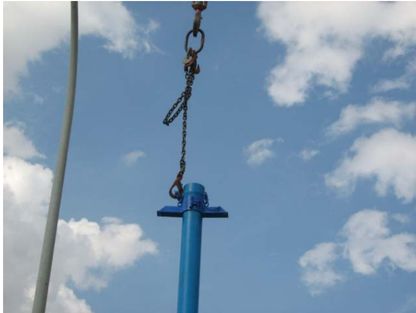
Elevando el último tramo de tubería con la abrazadera ya instalada
