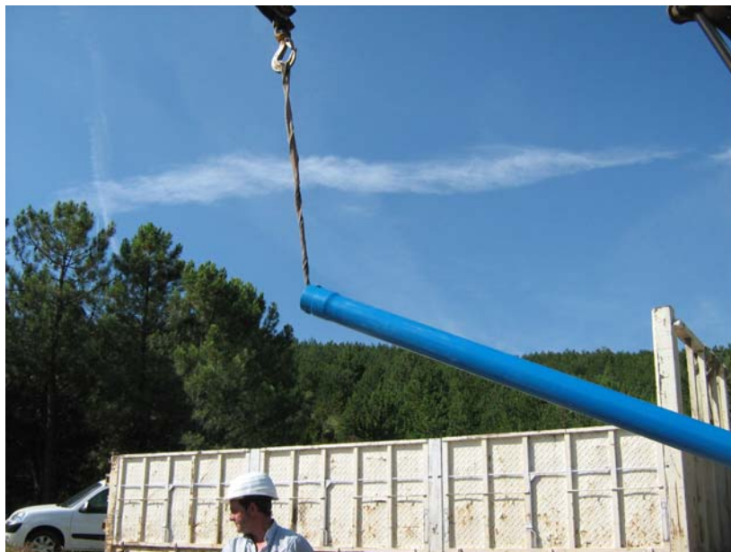
Elevando un tramo de tubería
