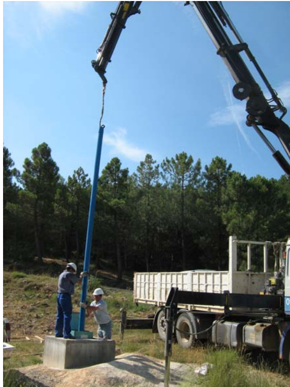
Enroscando un tramo de tubería
