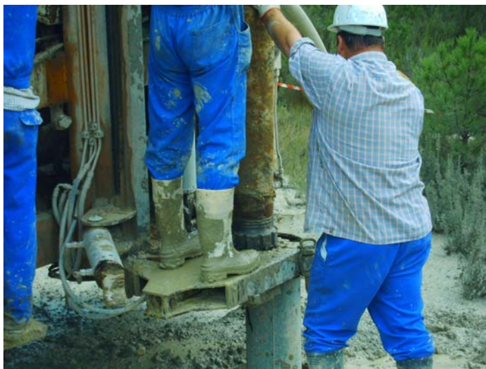
Colocación del martillo de 220 mm
