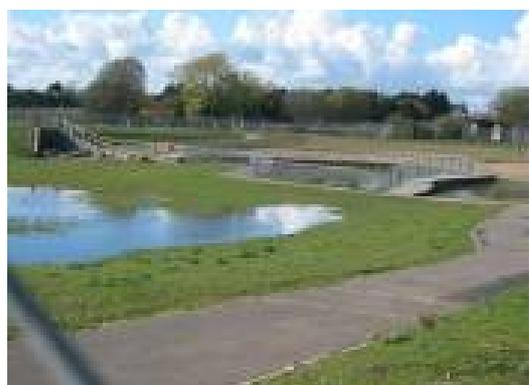
*Depósito de infiltración*
