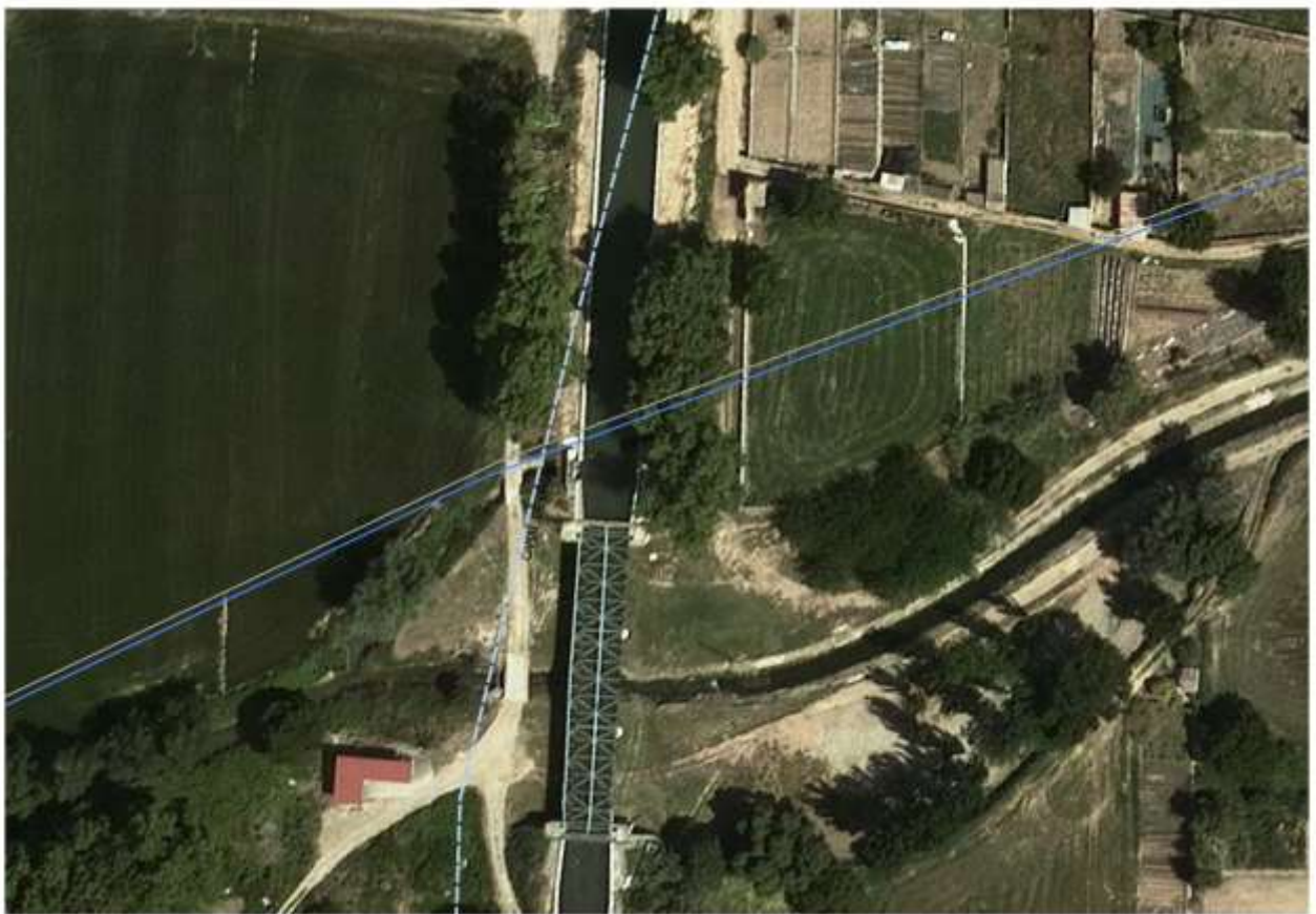
Figura 180. Punto de aliviadero del Canal de Urgell en el río Sió en Agramunt.
