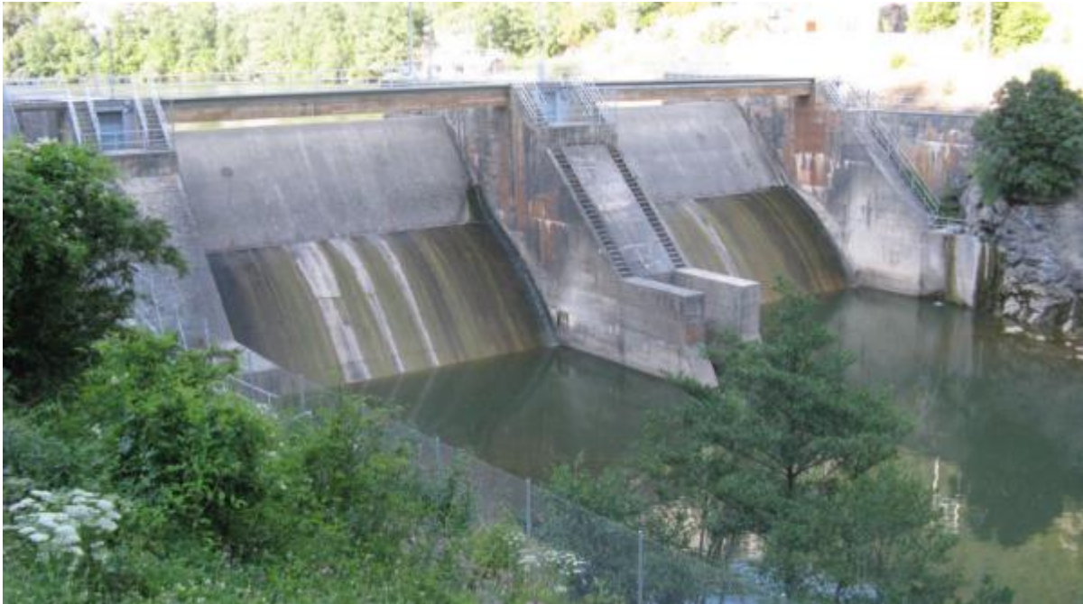
Figura 6. Vista de la presa de Cereceda.
