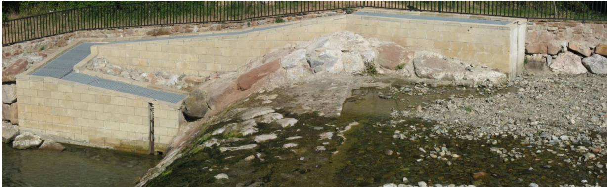
Figura 55. Escala de peces en el azud de Ezcaray, río Oja, durante el periodo estival donde apenas circula caudal por el río.
