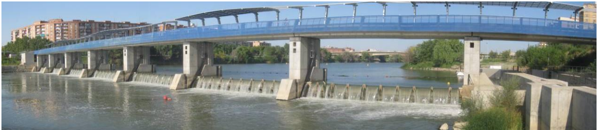
Figura 86. Vista panorámica del azud de Zaragoza, la escala se localiza en el costado derecho de la fotografía. El azud vierte agua en toda su longitud y la llamada en la zona de la escala es importante pero porque discurre demasiado caudal por el paso.
