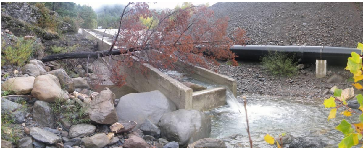
Figura 21. Vista de la escala de artesas sucesivas del azud de la C.H. de Aguilero. La entrada al paso se encuentra descolgada de la lámina del río de aguas abajo del azud. Además, en la última artesa se aprecia un bolo de grandes dimensiones en su interior.
