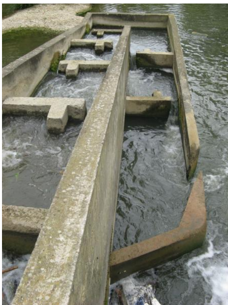
Figura 29. Imagen izquierda: Interior de la escala donde se aprecia que el vertido entre artesas es semisumergido. La entrada a nivel, el mayor tamaño de la primera artesa y el emplazamiento en una zona de calado suficiente favorece la entrada de los peces al interior del paso. Imagen derecha: Vista de la entrada de caudal a la escala, donde se ha construido un deflector de forma triangular, para evitar la entrada de flotantes.
