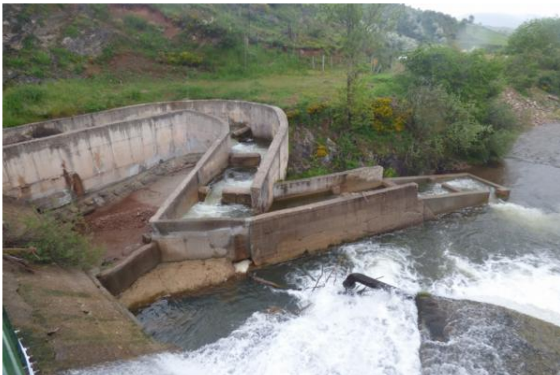
Figura 10. Escala de peces del azud de la toma de aguas de Reinosa en Espinilla en donde se aprecia que se han añadido dos artesas más al objeto de conectar la lámina de aguas abajo del azud con la escala.
