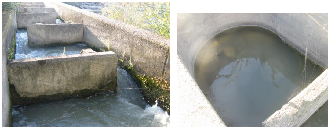
Figura 96. Izquierda, interior del paso donde se aprecia el vertido semisumergido de los vertederos. Derecha, entrada de caudal al paso.
