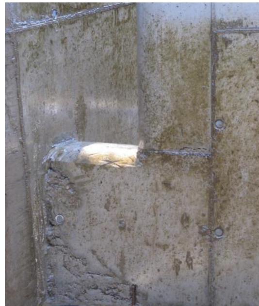
Figura 12. Tabiques interiores de la escala, donde los cantos de los vertederos se encuentran redondeados con el propósito de disminuir turbulencias no deseadas, que se generarían en el caso de presentar aristas vivas, así como disminuir posible daños a los peces cuando remontan el paso
