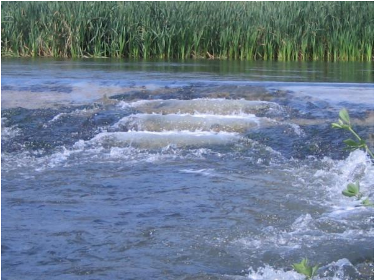
Figura 37. Detalle del paso excavado en el azud de Torrelameu.
