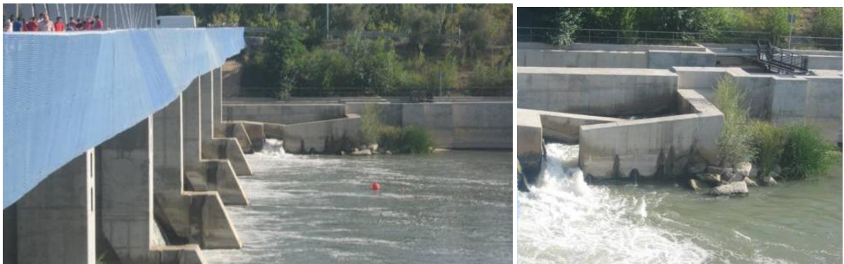
Figura 87. Vista del paso de peces del azud de Zaragoza. En la imagen se aprecia la zona de entrada para los peces a la escala donde las turbulencias y velocidad del agua son muy elevadas. Además, existe un caudal de llamada en toda la longitud del azud, no generándose una atracción entorno a la entrada al paso.
