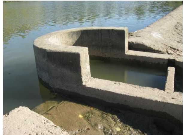
Figura 15. Izquierda, detalle de uno de los vertederos del paso. El calado de la artesa inferior es muy bajo, apreciándose el vertido del orificio sumergido. Derecha, detalle del deflector construido en la entrada de caudal al paso para minimizar la entrada de flotantes en él.
