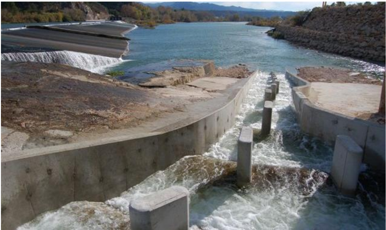
Figura 76. Vista del nuevo paso del azud de Cherta desde aguas arriba.
