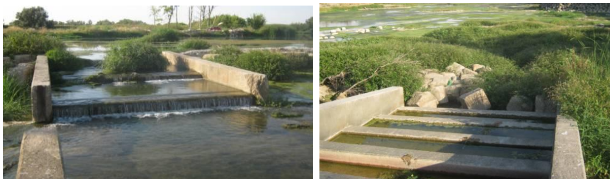
Figura 91. Vista de la entrada de caudal al paso de la margen derecha (izquierda) y de la entrada al paso para los peces que se encuentra totalmente obstruida por la vegetación del azud de la CH de Pina.
