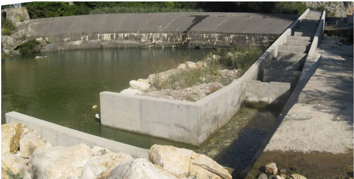
Figura 80. Entrada al paso del azud del Canal de Pinyana
