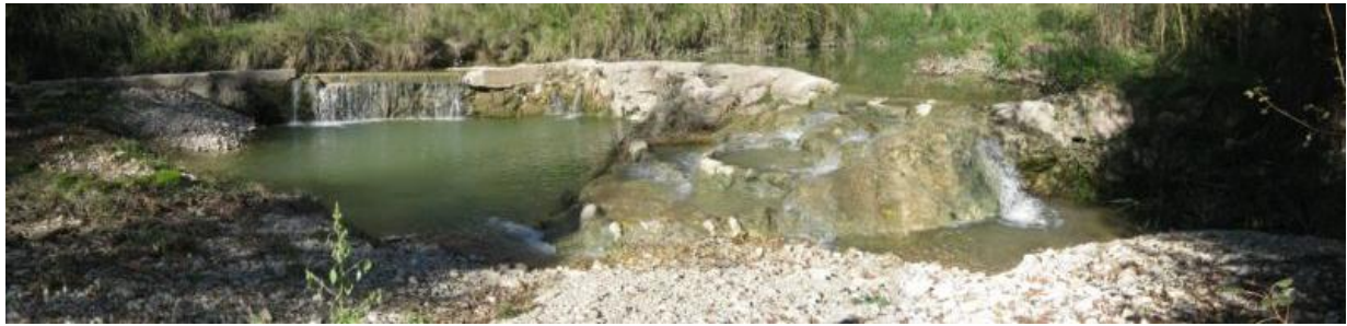
Figura 3. Azud del Molino La Torreta en el río Bergantes. El paso está construido con sillares de roca, de ahí que la integración en el medio sea alto.
