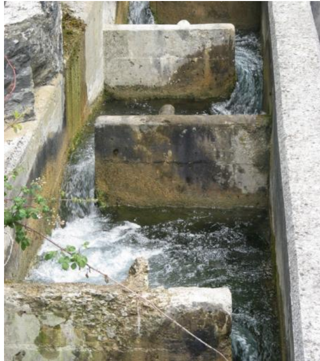
Figura 5. Vista interior de las artesas donde se puede observar el vertido semisumergido que se produce en los vertederos.
