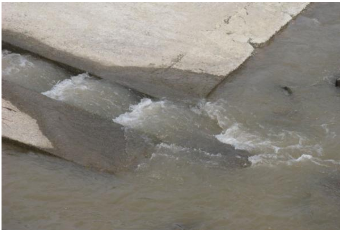
Figura 50. Detalle de la entrada al paso que se encuentra casi a nivel de la lámina de aguas debajo de la estructura. El caudal de llamada es muy bajo, no obstante, a la circular tan poco caudal por este tramo del río Segre puede ser suficiente para atraer los peces a la entrada del paso. El vertido entre artesas es libre y el calado y volumen es muy reducido para un río de estas características.
