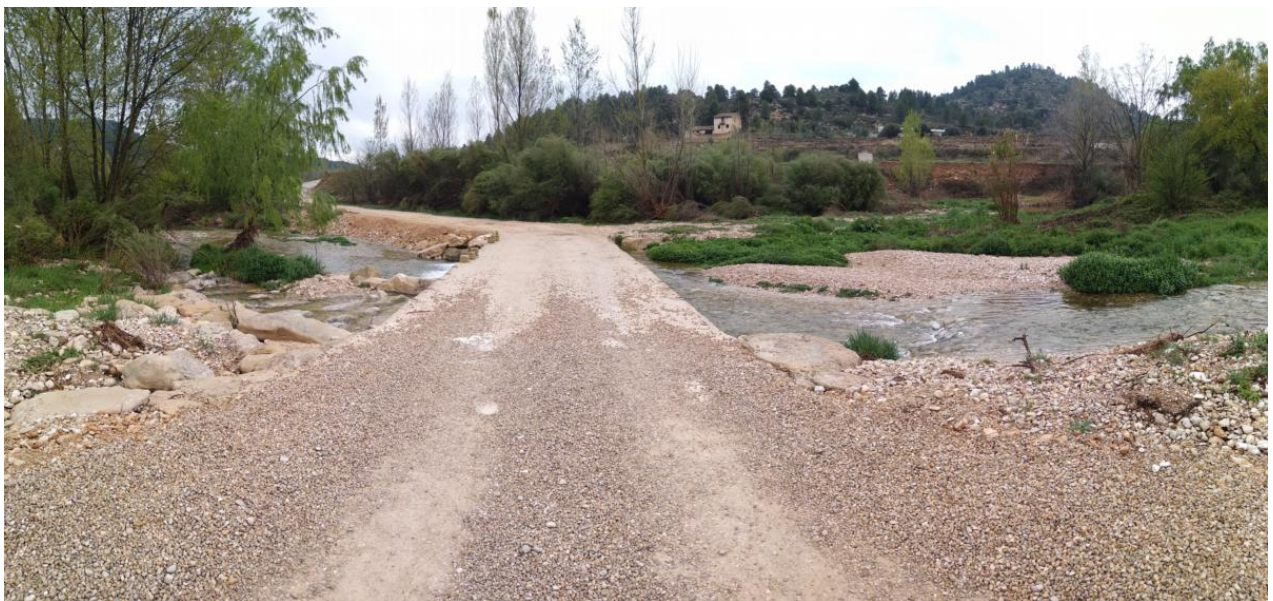
Figura 46. Vista del badén desde la margen izquierda en abril de 2019. Con las últimas crecidas la vegetación que se había desarrollado en el interior del paso fue arrastrada por la corriente.
