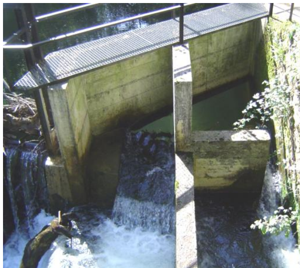
Figura 17. Imagen izquierda, entrada de caudal a la escala y de la artesa construida junto a esta cuyo cometido es concentrar un mayor caudal en la entrada del paso generando un mayor efecto llamada. Imagen derecha, Vista del interior de la escala, los tabiques interiores no cuentan con deflectores.
