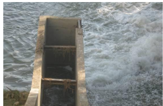
Figura 96. A la izquierda vista general de la escala de peces. Como puede observarse en algún tabique el caudal rebosa por encima debido a que los orificios sumergidos se encuentran obstruidos. A la derecha se presentan dos imágenes la de arriba se corresponde con la entrada de caudal al paso que es mediante un orificio sumergido y la entrada para los peces al mismo. Como puede observarse hay mucha espuma en la zona de entrada al paso debido al caudal que se deriva por la rampa que hay en el costado izquierdo de la escala.
