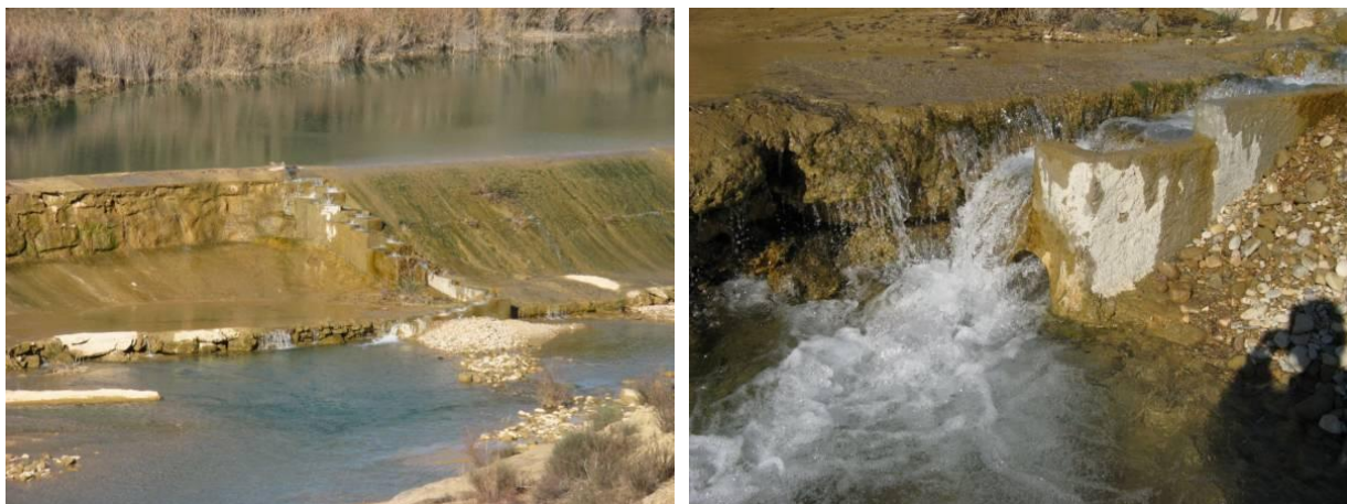
Figura 5. Vista de la escala que presenta una disposición en forma de L. Como puede apreciarse que ha descendido el nivel del cauce aguas abajo del azud y se ha alargado el paso para conectar la lámina de agua del río de aguas abajo con el paso. Sin embargo, en la imagen de la derecha, se aprecia la entrada del paso para los peces que se encuentra desconectada de la lámina del río de aguas abajo del azud.
