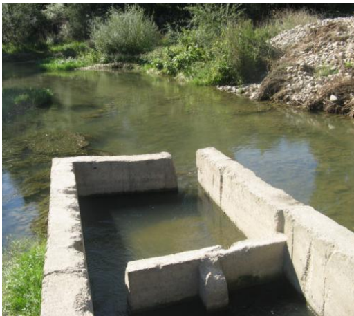
Figura 13. Izquierda, vista de la entrada para los peces al paso, la cual se encuentra conectada con la lámina del río de aguas abajo del azud. Cabe destacar que durante la visita apenas circulaba caudal por el paso por lo que el caudal de llamada en la entrada al paso todavía es menor. Imagen derecha: Vista de la escala desde aguas abajo del azud. Esta tipología de escala, con las mismas dimensiones y características se repite en varias ocasiones en el tramo del río Ebro a su paso por la CCAA del País Vasco, La Rioja y Navarra.
