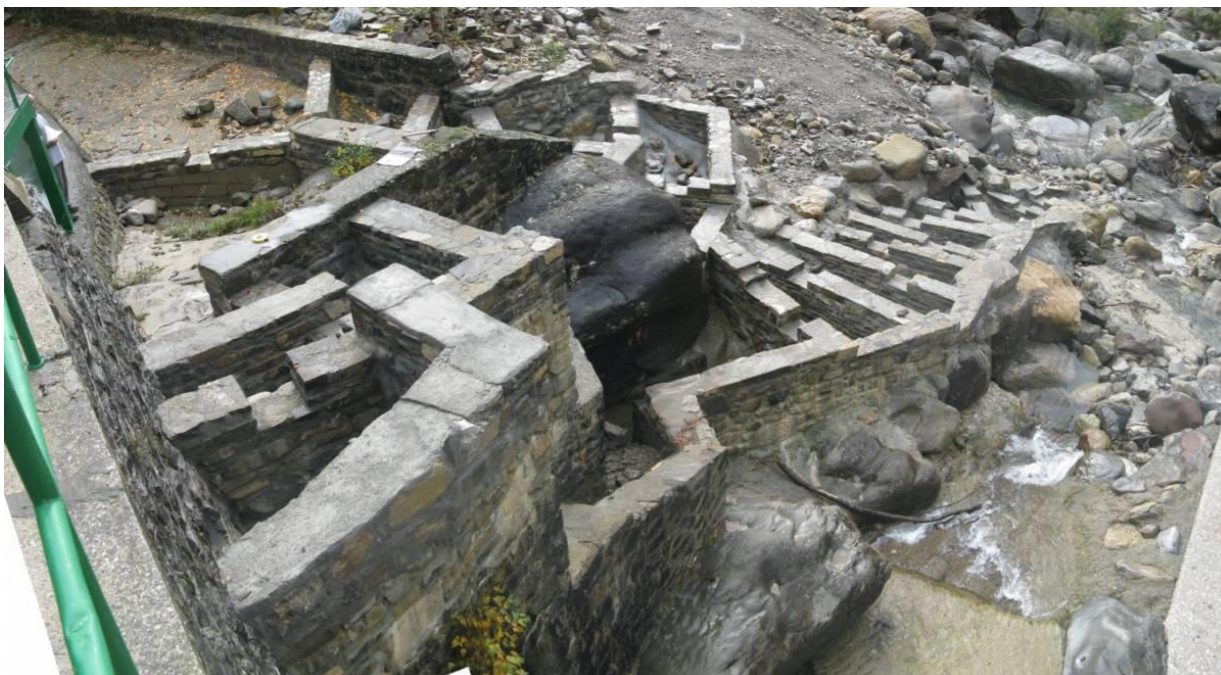
Figura 22. Vista de la escala de peces de artesas sucesivas en la presa de la CH de Biescas I. La escala está bien integrada en el medio, sin embargo presenta deficiencias técnicas en el diseño y posterior ejecución que limitan considerablemente su correcto mantenimiento y funcionamiento.
