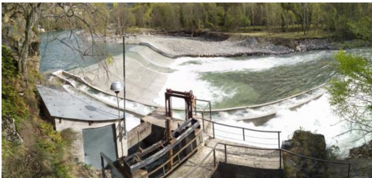
Figura 17. Vista panorámica del azud, la escala de peces de hendiduras verticales y el tobogán para el descenso de rafts
