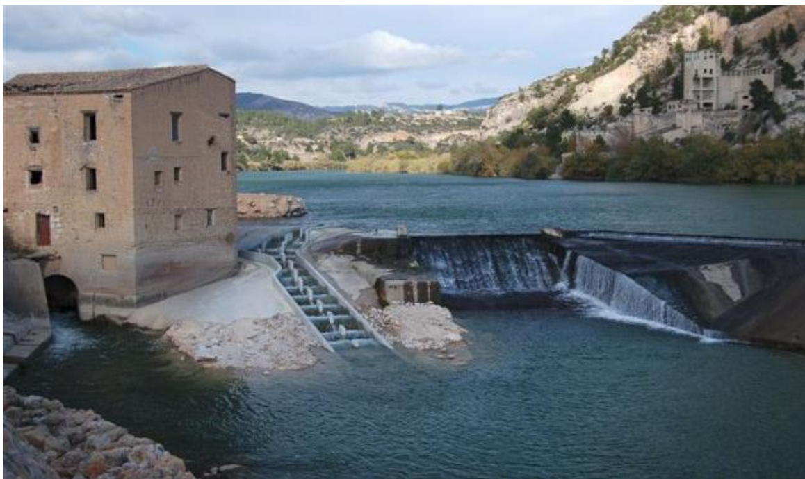
Figura 74. Vista del nuevo paso construido en el azud de Xerta, emplazada en la zona donde el río hace embudo en relación con el eje del azud. Este emplazamiento es correcto.
