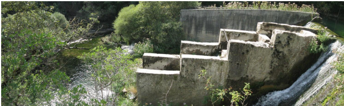
Figura 42. Presa de la piscifactoría de Zudaire que cuenta con dos pasos, uno más antiguo (el más próximo en de la imagen) y uno más reciente (al fondo de la imagen).
