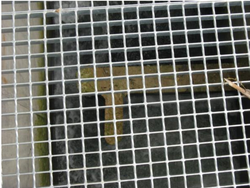
Figura 55. Detalle del tramex del paso del Azud del Molino de Labeaga. La instalación de éste, unido a la altura de los muros exteriores, hace que la oscuridad en el interior del paso sea elevada, factor que no favorece las migraciones piscícolas.
