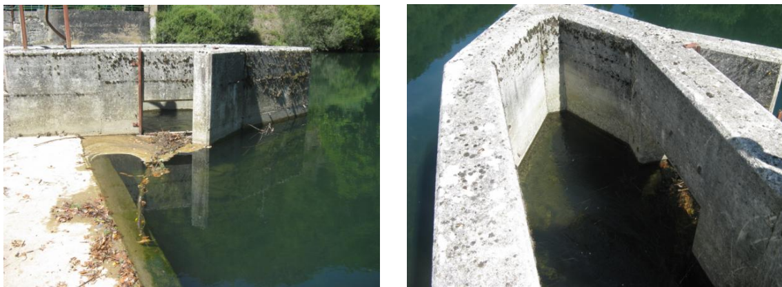
Figura 58. Izquierda, vista lateral de la entrada de caudal a la escala. Derecha, vista cenital del deflector construido para evitar la entrada de flotantes al paso.
