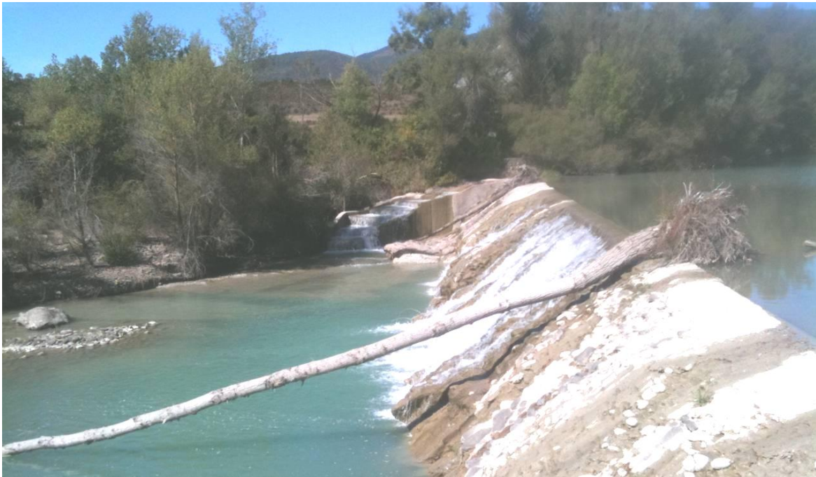
Figura 8. Vista de la escala de artesas sucesivas en vertido libre del azud de la CH Las Tiendas construida en el costado de la margen derecha. La entrada al paso no está bien conectada con la lámina de aguas abajo y no existe caudal de llamada en la zona de entrada al paso. Fuente: Pedro Peyron.
