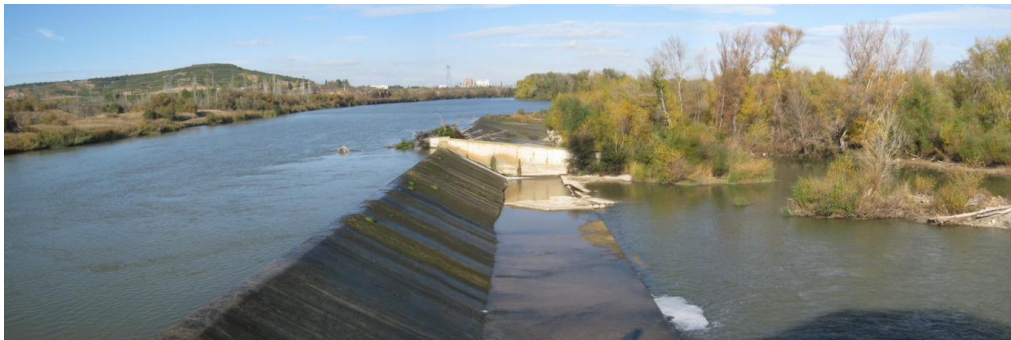
Figura 94. Azud y escala de artesas sucesivas de la C.H. Electra Tudela.
