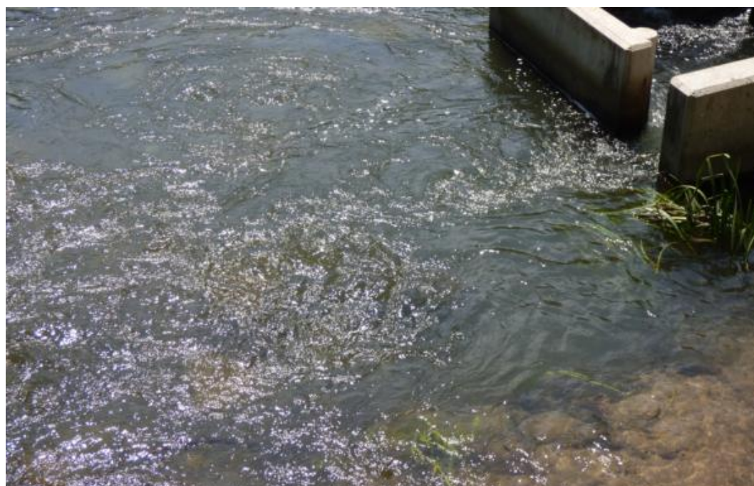
Figura 24. Detalle de la entrada al paso para los peces de la escala del azud de la toma de aguas de Logroño donde el caudal de llamada es el generado por el propio caudal circulante en la escala más un añadido por un tubo que vierte aguas abajo de la entrada
