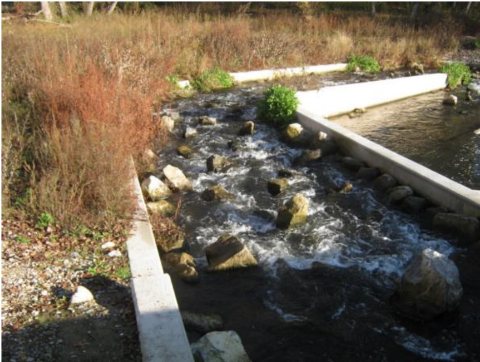
Figura 69. Primer tramo de la rampa de bloques de perturbación de la CH de Buicio.
