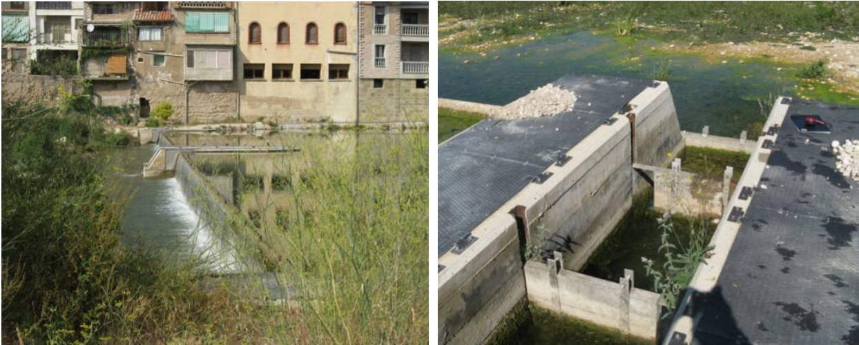
Figura 43. Derecha, vista de la entrada a la escala donde se aprecia que no hay caudal de llamada . Izquierda, imagen donde se aprecia que el azud vierte caudal en toda su longitud y en la entrada al paso apenas existe un caudal importante que favorezca la atracción de los peces a esta zona.
