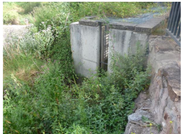
Figura 56. Entrada de caudal a la escala de peces de Ezcaray. Izquierda, mayo de 2018 y, derecha, agosto de de 2018.
