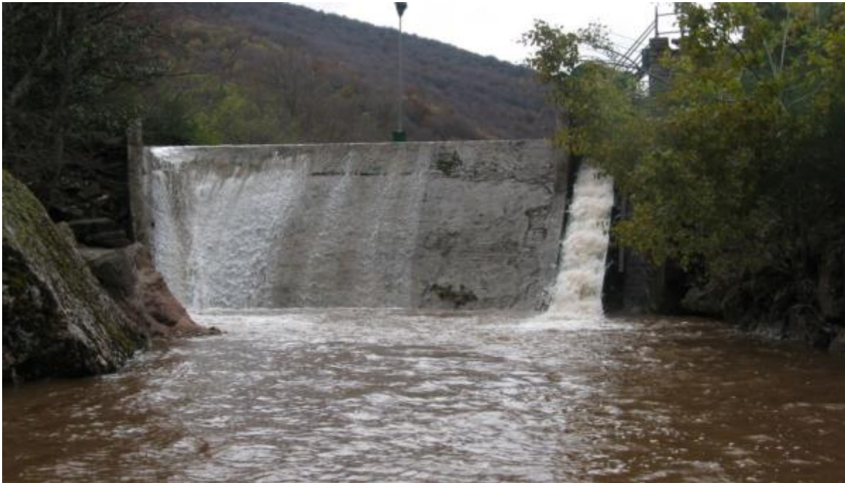
Figura 3. Presa de la CH de Zumañón y la escala de peces de artesas sucesivas durante un periodo de caudales altos. Las turbulencias que se generan en el interior de las artesas son muy elevadas para que un pez pueda ascender por el paso.
