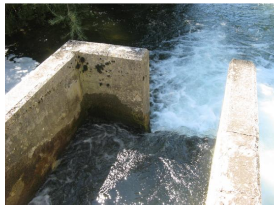
Figura 62. Izquierda, orificio de entrada de caudal a la escala de la Central Hidroeléctrica de Oroz Betelu. Derecha, entrada a la escala para los peces, la cual presenta una mayor sección que el resto de vertederos, por lo que la carga de vertido en este es menor que en el resto de los tabiques.
