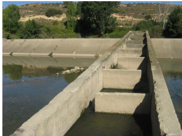
Figura 13. Izquierda, vista de la entrada para los peces al paso, la cual se encuentra conectada con la lámina del río de aguas abajo del azud. Cabe destacar que durante la visita apenas circulaba caudal por el paso por lo que el caudal de llamada en la entrada al paso todavía es menor. Imagen derecha: Vista de la escala desde aguas abajo del azud. Esta tipología de escala, con las mismas dimensiones y características se repite en varias ocasiones en el tramo del río Ebro a su paso por la CCAA del País Vasco, La Rioja y Navarra.
