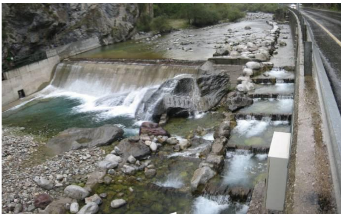
Figura 11. Vista de la escala de peces de artesas sucesivas en vertido libre de la toma de la CH de Salinas. Este paso se ha construido prácticamente con materiales del propio río quedando muy integrado. Como se aprecia arriba a la derecha de la fotografía, la salida de la escala para los peces se encuentra alejada de la rasante del azud, minimizando de esta forma que los peces puedan ser arrastrados por la corriente una vez han remontado el paso.
