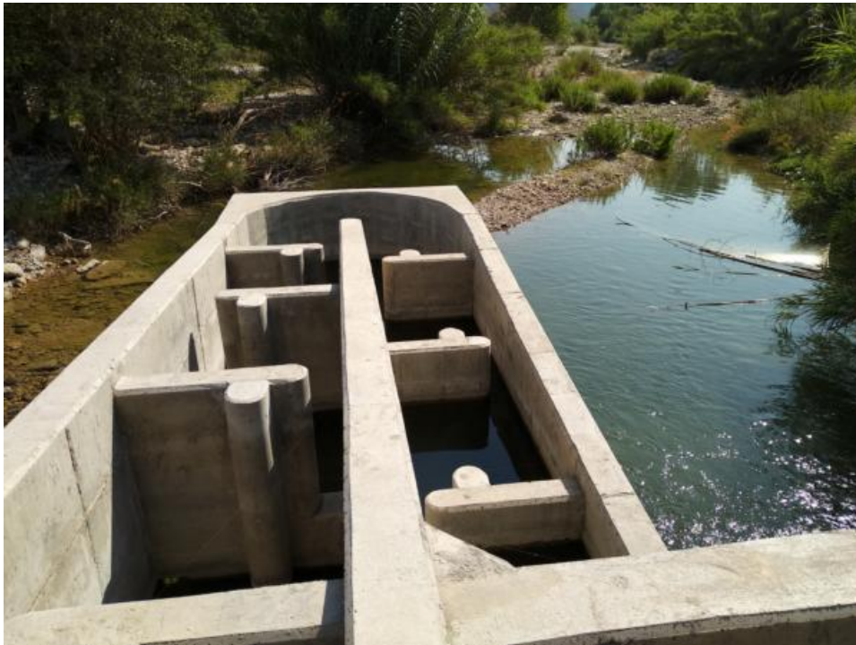
Figura 60. Vista del interior del paso. Puede apreciarse que se trata de un paso de escalas sucesivas en vertido sumergido que cuenta con una artesa de descanso.
