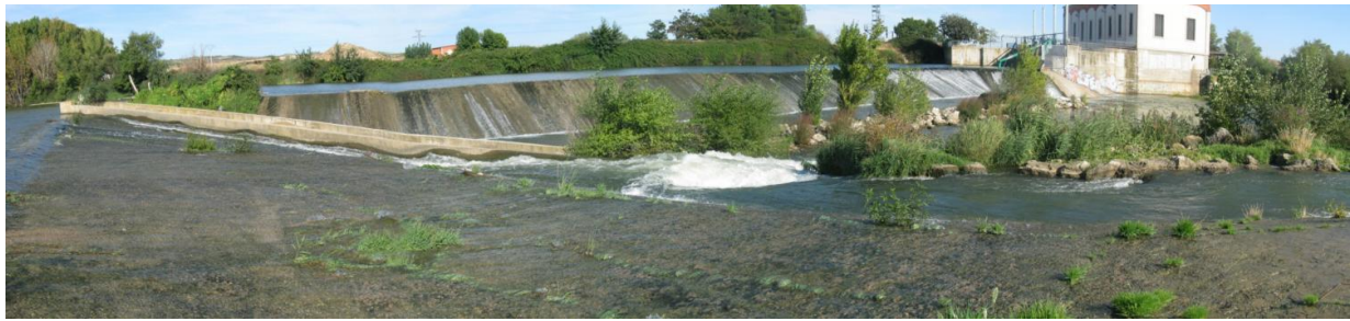
Figura 91. Escala y azud de la CH Azagra-Machín.
