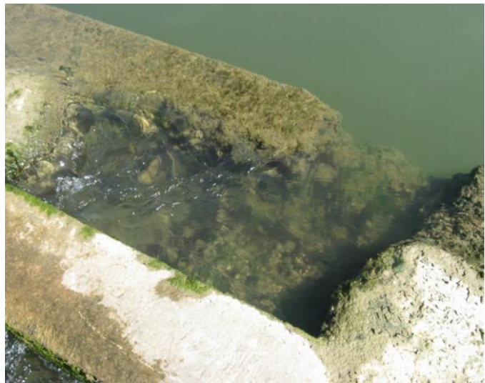
Figura 60. Vista del paso excavado en el azud (izquierda) y a entrada de caudal al paso, cuando circula poco caudal por el río y este no rebosa por el azud el caudal entra a través de un orificio sumergido. El día de la visita el calado en el interior de las artesas era muy bajo.
