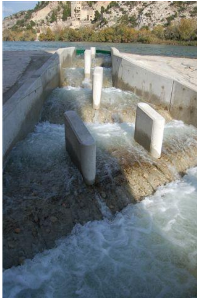
Figura 77. artesas de la parte superior del paso, que cuentan con unos deflectores en el centro de los tabiques. El salto entre estanques del paso es elevado, no siendo homogéneos. Las dimensiones de las artesas tampoco son homogéneas, construyéndose las más estrechas en la parte alta del paso.
