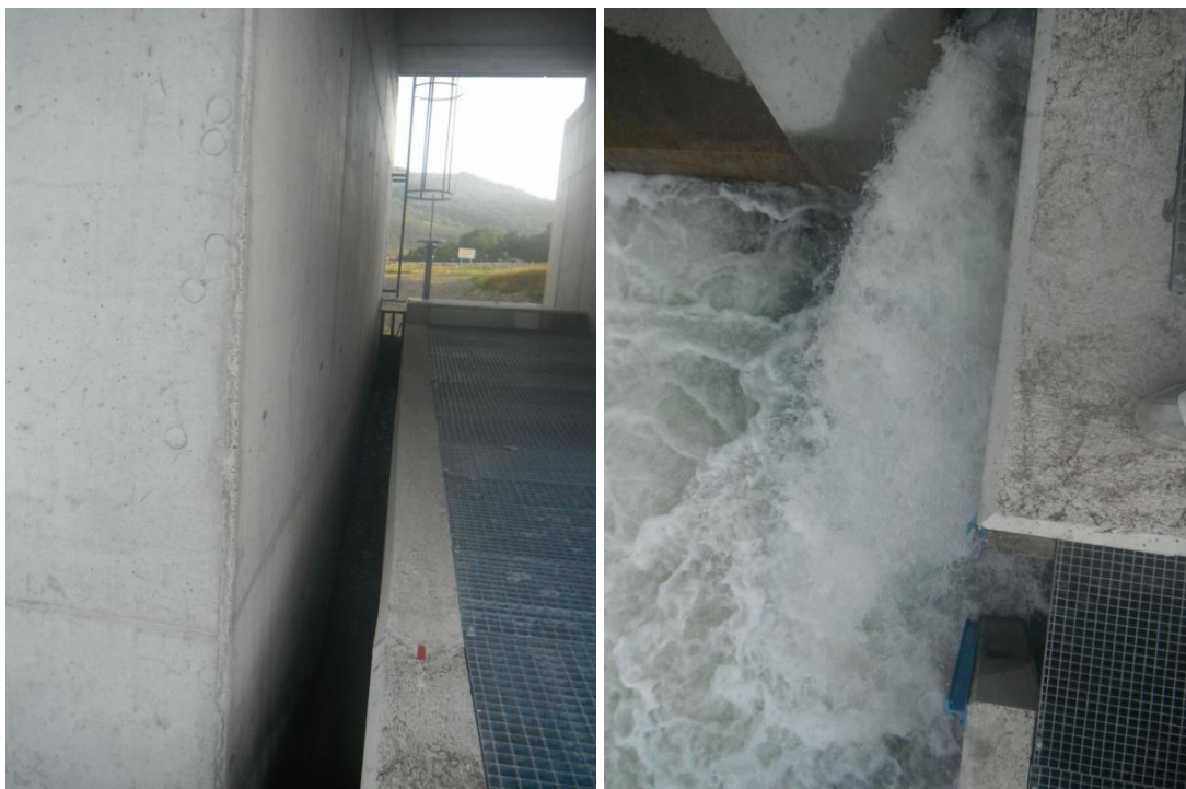
Figura 68. Izquierda, canal para concentrar mayor caudal en la entrada del paso para los peces. Derecha, vista de la entrada para los peces al paso del azud de la presa de cola de Itoiz.
