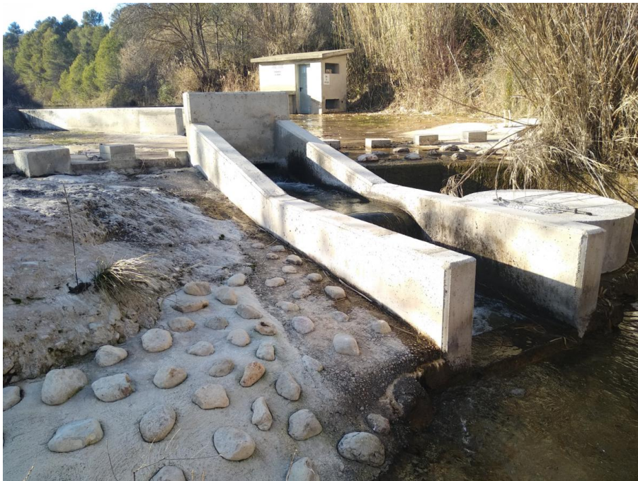
Figura 69. Vista de la segunda tramada desde aguas debajo de la escala del azud de la huerta nueva de Cretas
