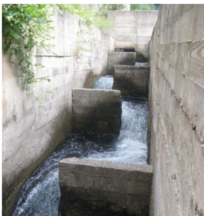
Figura 11. Vista del interior del paso (izquierda) donde el vertido entre alguna de las artesas es semisumergido. A la derecha se presenta una imagen de la entrada al paso de peces la cual se encuentra desconectada de la lámina del río de aguas abajo.
