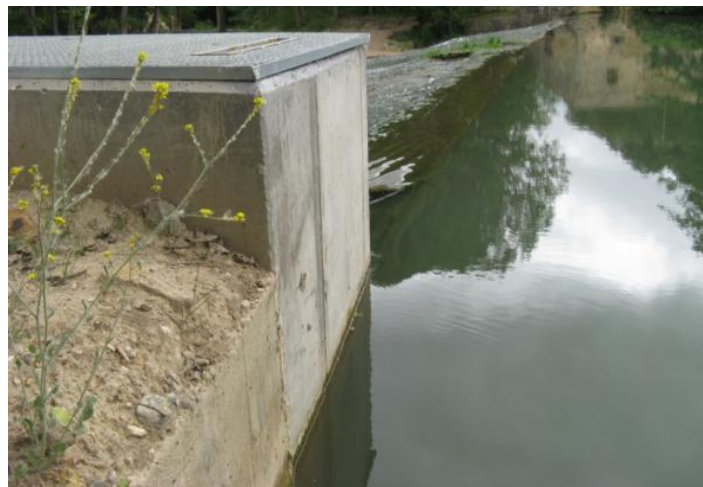
Figura 51. Coronación del azud y la entrada de caudal al paso.
