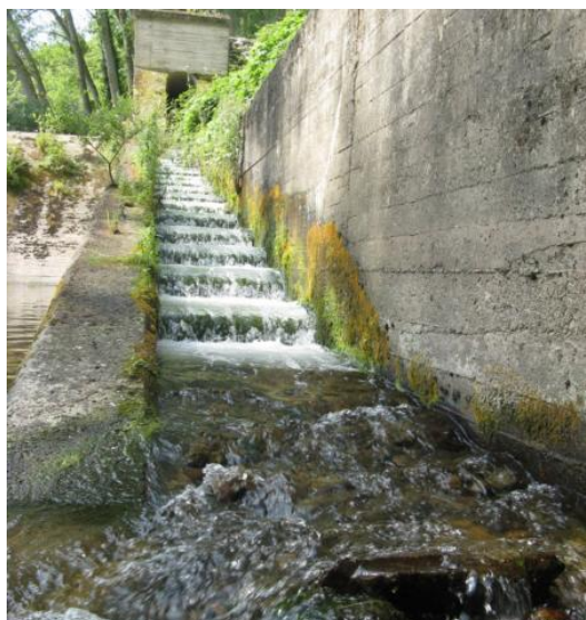
Figura 41. Izquierda, entrada al paso de peces del azud del Canal de la Margen Izquierda muy colmatada. Derecha, entrada de caudal al paso
