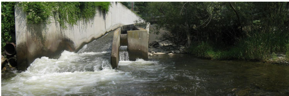
Figura 44. Entrada para los peces al paso descolgada de la lámina del río de aguas abajo del azud. Como puede observarse, a la izquierda del paso existe un canal para el descenso de piraguas que concentran un buen caudal próximo a la entrada a la escala, generándose un caudal de llamada para los peces.
