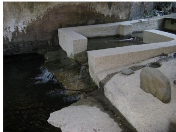
Figura 31. Imagen izquierda: entrada de caudal al paso obstruida por sedimentos, lo que dificulta la salida de los peces del paso. Imagen derecha: Entrada al paso para los peces descolgada del nivel del agua del barranco aguas abajo del obstáculo.
