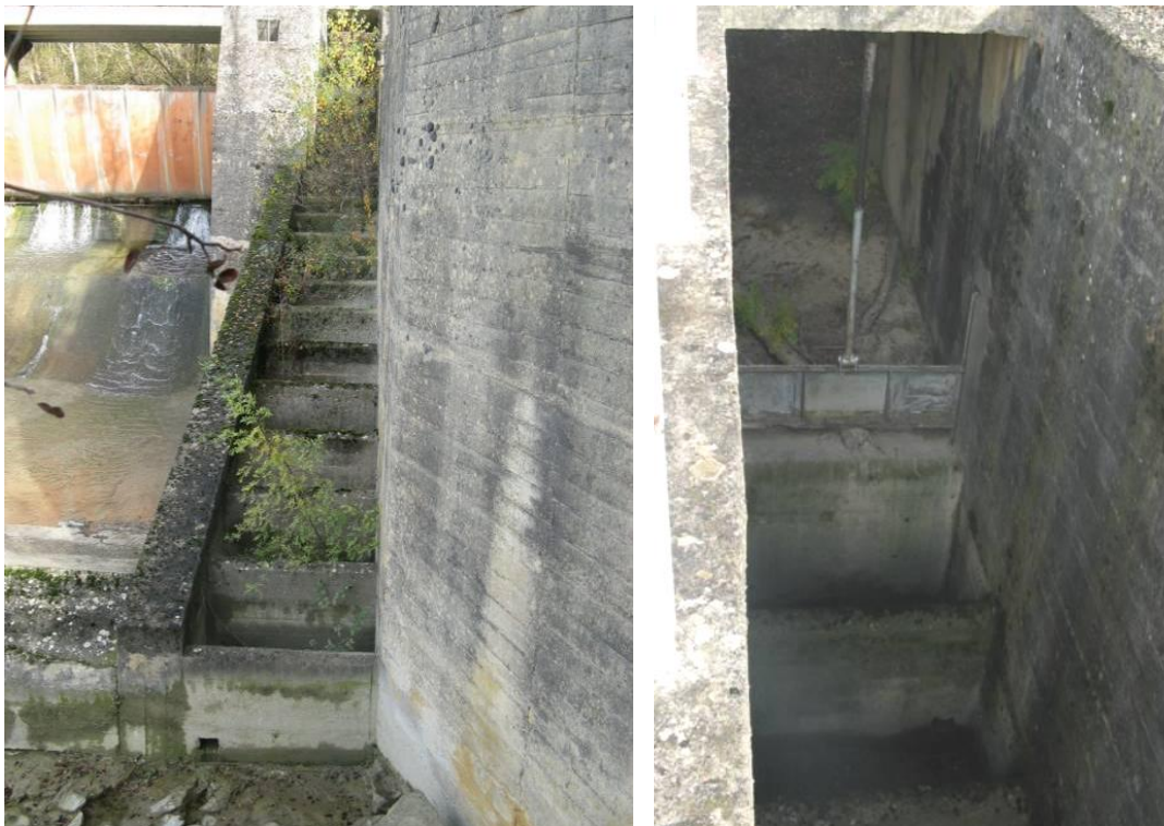
Figura 28. Vista general de la escala de peces del azud de la C.H. de Javierrelatre fuera de uso y colonizada por vegetación, a la derecha detalle de la entrada de caudal a la escala regulado por una compuerta vertical.
