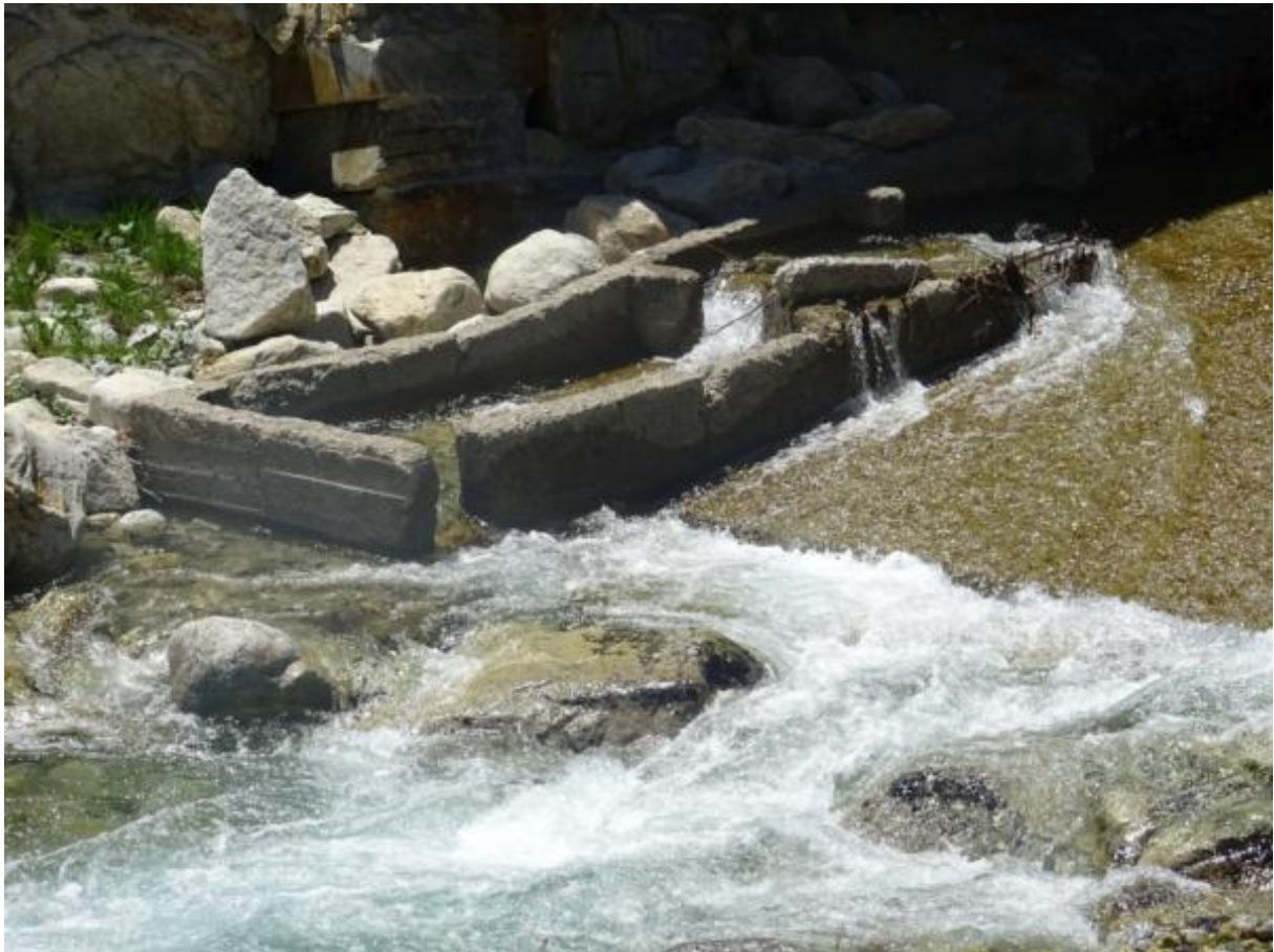
Figura 25. Detalle del tramo final del paso del puente de la N-420 en el que se aprecia el bajo calado de las artesas y el armado de la estructura.
