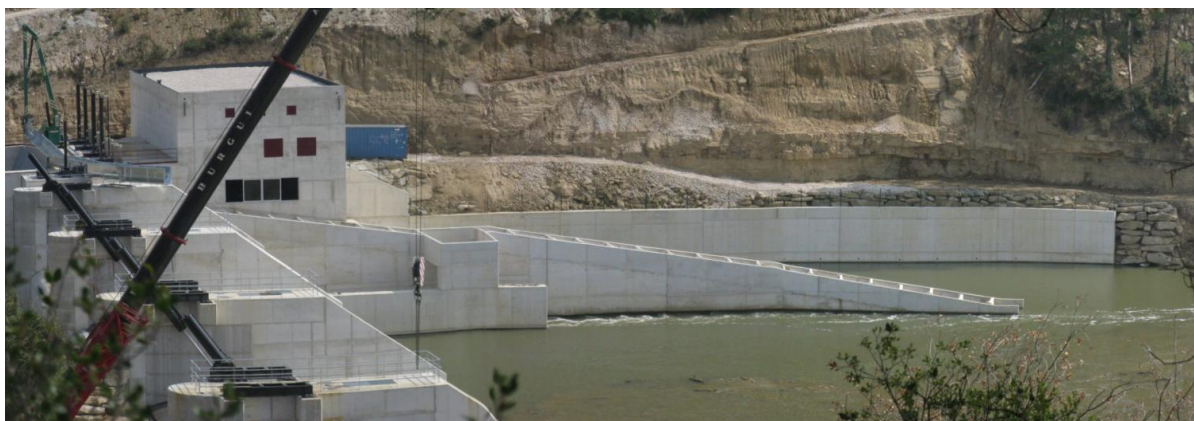
Figura 35. Escala de artesas sucesivas de la presa Señorío de Sarria II. En el centro de la escala, debido a su longitud, ha construido una artesa de descanso.
