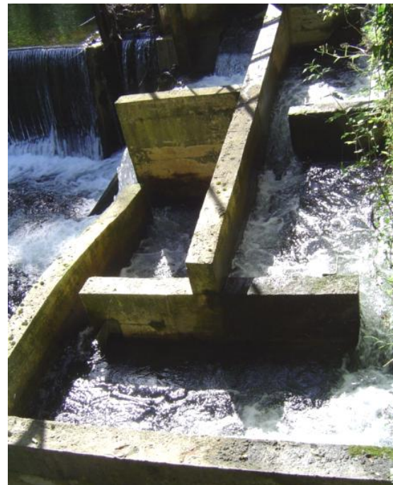
Figura 17. Imagen izquierda, entrada de caudal a la escala y de la artesa construida junto a esta cuyo cometido es concentrar un mayor caudal en la entrada del paso generando un mayor efecto llamada. Imagen derecha, Vista del interior de la escala, los tabiques interiores no cuentan con deflectores.
