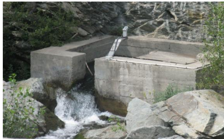
Figura 11. Vista del interior del paso (izquierda) donde el vertido entre alguna de las artesas es semisumergido. A la derecha se presenta una imagen de la entrada al paso de peces la cual se encuentra desconectada de la lámina del río de aguas abajo.
