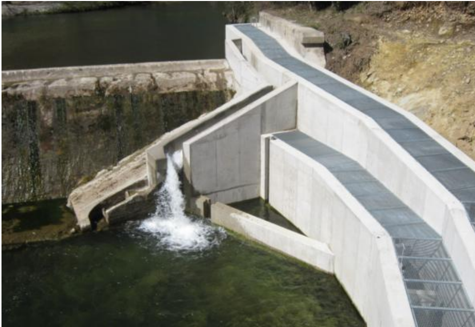
Figura 30. Escala de peces y del canal construido para incrementar el caudal en el entorno de la entrada del paso y generar una llamada para los peces.
