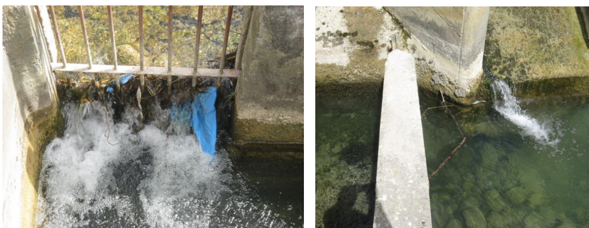
Figura 8. Izquierda, entrada de caudal a la escala protegida por una reja obstruida por flotantes. La entrada al paso para los peces (imagen derecha) se encuentra a nivel, y en una zona con calado suficiente para facilitar la entrada de los peces.
