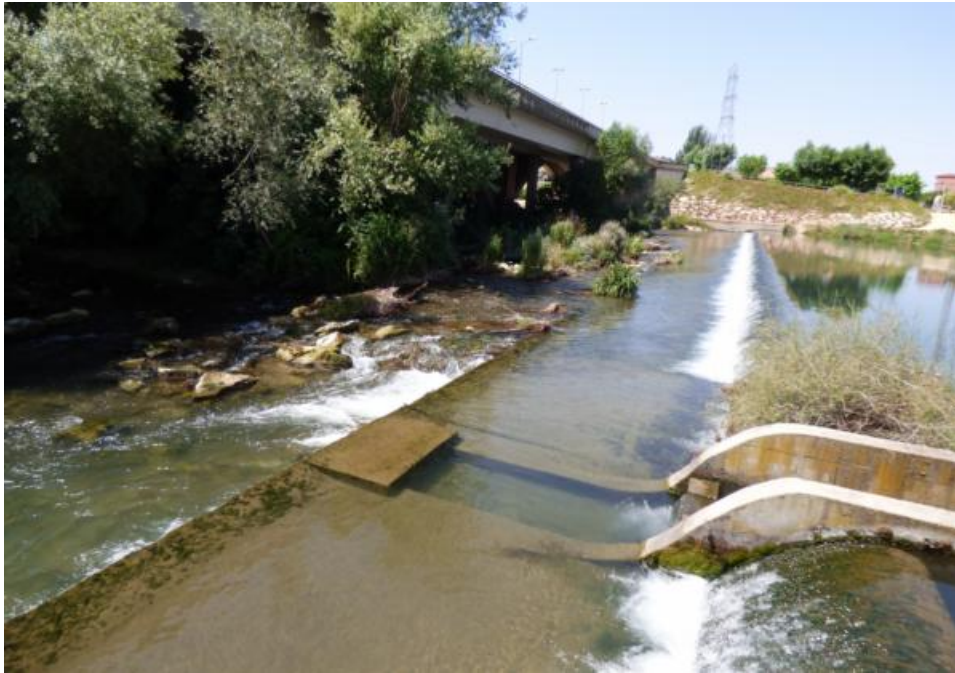
Figura 32. Vista del paso del azud de Alguerrí-Balaguer desde la margen izquierda. En esta fotografía se aprecia que la entrada al paso está desconectada de la lámina de aguas abajo del colchón amortiguador
