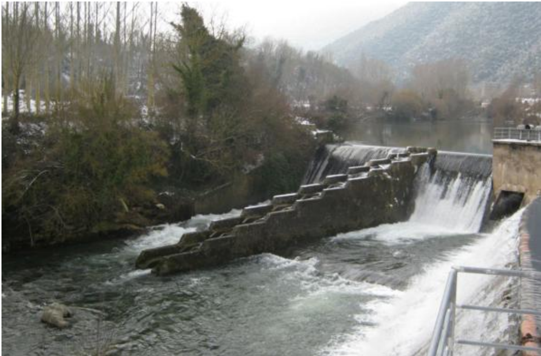
Figura 34. Azud y la escala de la CH de Cuevas. El paso se localiza en el centro del azud y su entrada se encuentra alejada de la base del azud, por lo que el efecto llamada de esta se ve reducido en su totalidad.
