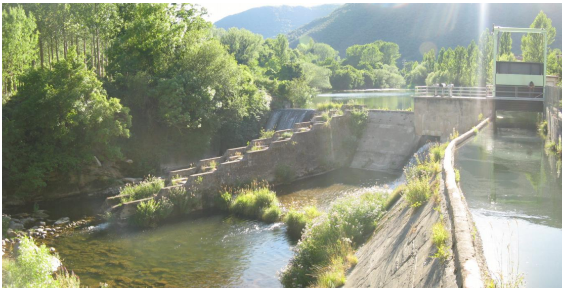
Figura 35. Vista del paso de la CH de Cuevas durante un periodo de caudales bajos.
