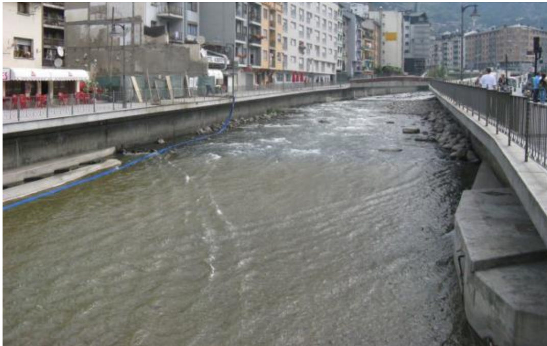
Figura 4. Tramo del río Valira con parte del lecho hormigonado y natural. El paso se inicia a la vez que el tramo de lecho hormigonado.
