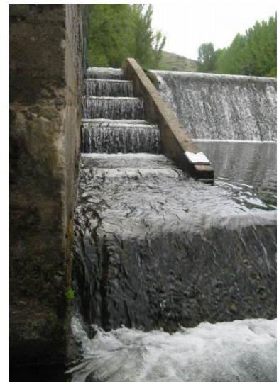
Figura 45. Escala de artesas sucesivas donde se aprecia el elevado salto entre artesas. La entrada a la escala no conecta directamente con el río, por lo que los peces para acceder a ella deberán superar el salto que representa el colchón amortiguador. También se aprecia que el efecto llamada en la entrada del paso es inexistente.
