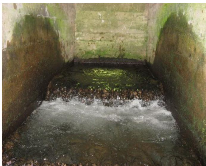
Figura 41. Izquierda, entrada al paso de peces del azud del Canal de la Margen Izquierda muy colmatada. Derecha, entrada de caudal al paso
