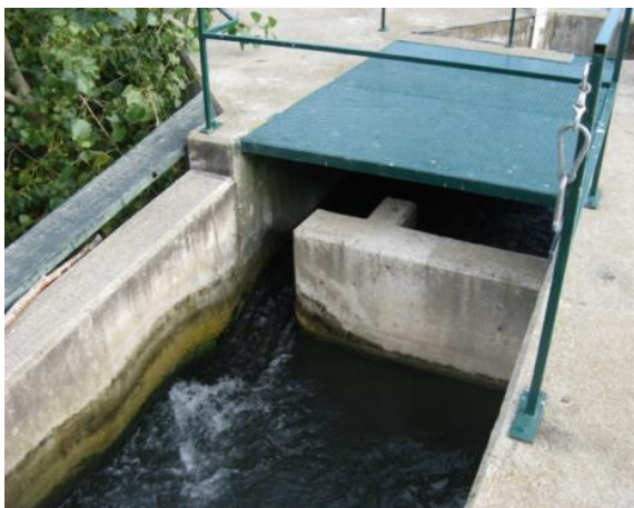
Figura 11. Izquierda, detalle del vertido semisumergido entre las artesas del paso y a la derecha del deflector construido en la entada de caudal al paso para evitar la entrada de flotantes en él.
