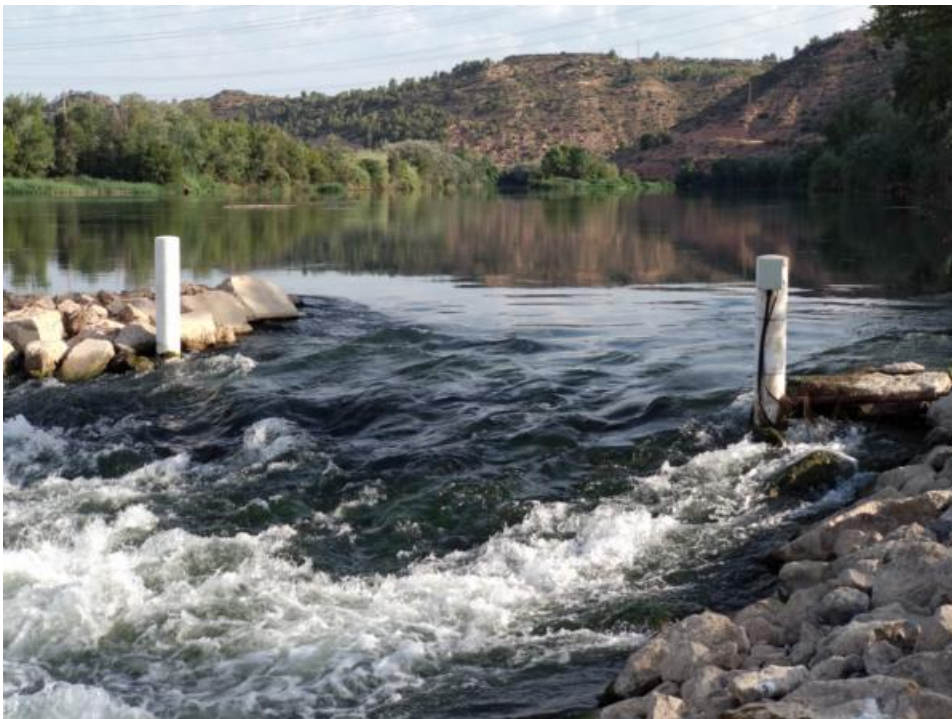
Figura 68. Detalle de la entrada de caudal al paso. En este punto las corrientes superan los 1,8 m/s, velocidad límite para que el paso sea franqueable para los ciprinidos
