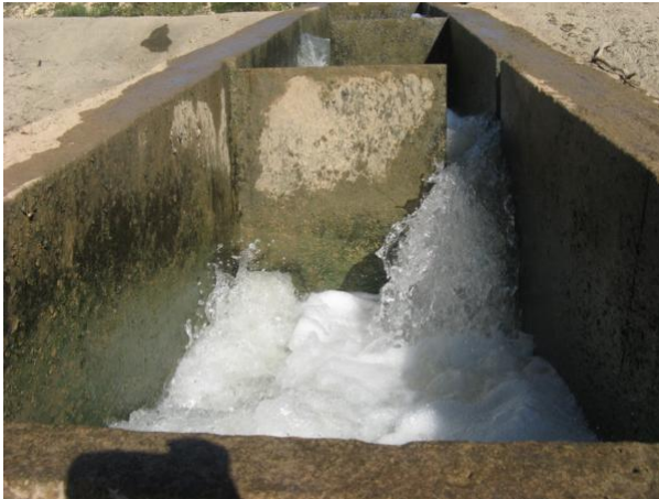
Figura 15. Izquierda, detalle de uno de los vertederos del paso. El calado de la artesa inferior es muy bajo, apreciándose el vertido del orificio sumergido. Derecha, detalle del deflector construido en la entrada de caudal al paso para minimizar la entrada de flotantes en él.
