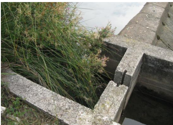
Figura 5. Izquierda, vista de la entrada de caudal obstruida por vegetación acuática. Derecha, escala de peces desde la coronación del azud donde alguna artesa se encuentra parcialmente colmatada.
