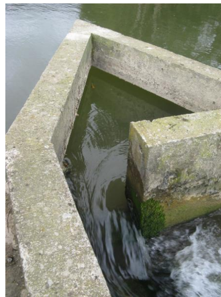
Figura 29. Imagen izquierda: Interior de la escala donde se aprecia que el vertido entre artesas es semisumergido. La entrada a nivel, el mayor tamaño de la primera artesa y el emplazamiento en una zona de calado suficiente favorece la entrada de los peces al interior del paso. Imagen derecha: Vista de la entrada de caudal a la escala, donde se ha construido un deflector de forma triangular, para evitar la entrada de flotantes.
