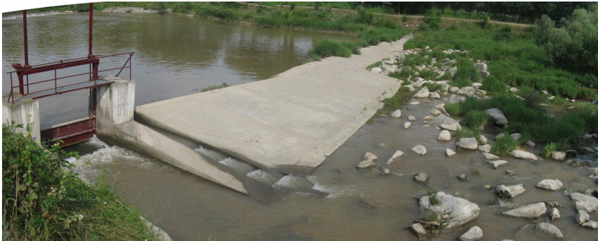
Figura 49. Azud del Parque del Segre para derivar los caudales al canal de aguas bravas de la Seu d'Urgell. Aguas debajo de este azud el río se queda prácticamente seco. Como se aprecia el paso se localiza en el costado derecho de la estructura de derivación de caudales.
