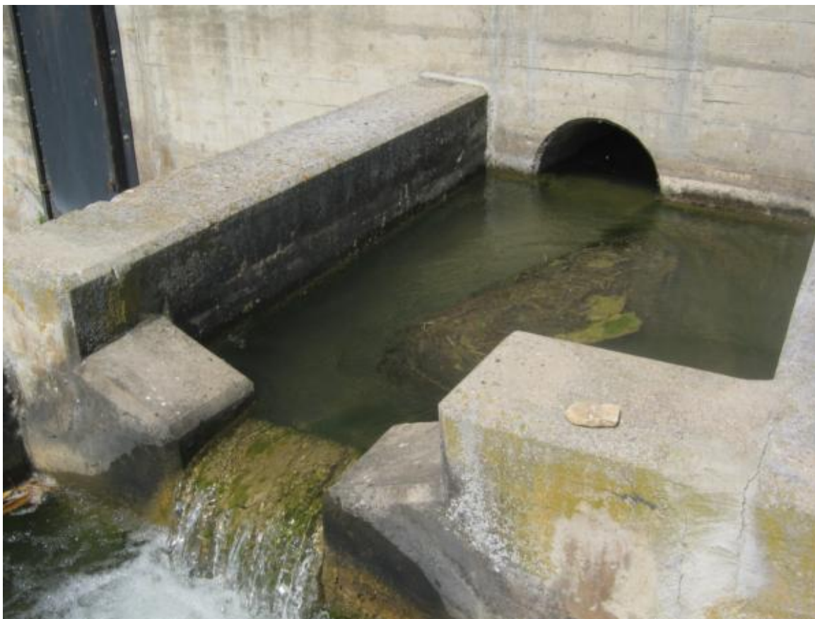
Figura 61. Detalle de la entrada de caudal al paso y salida para los peces a través de un orificio sumergido. Esta salida no es la más adecuada ya que la oscuridad que hay en su interior puede limitar la entrada de los peces a ella.
