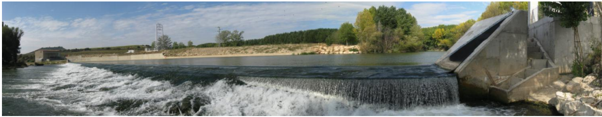
Figura 61. Azud neumático de la CH de Río Antiguo que cuando se realizó la fotografía se encontraba deshinchada. El paso de peces se localiza en el costado de la margen izquierda
