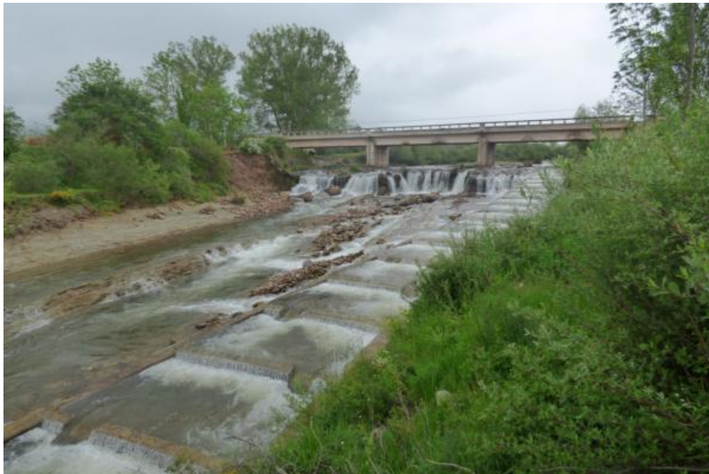
Figura 12. Escala de peces en el puente de la carretera CA-280 con vertederos en vertido libre y en la que circula un caudal superior al de diseño.
