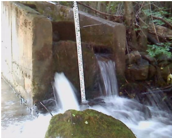
Figura 54. Salto de entrada a la escala del azud de la CH. Castellas. Este salto es muy elevado (> 30 cm) limitando la entrada al paso para los peces. A la derecha, detalle de un tabique lateral del paso donde se aprecia el mal estado de la estructura.
