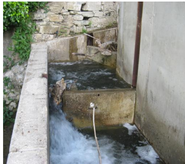
Figura 78. Paso de peces de la CH. de Ezcároz. Izquierda, elevado salto en el primer vertedero desde la entrada a la escala para los peces. Derecha, obstrucción de varios vertederos.
