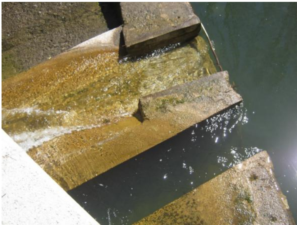
Figura 22. Canal de entrada de caudal y rebaje practicado en el azud para incrementar el caudal de llamada en la entrada del paso y mejorar las migraciones de descenso durante periodos de caudales bajos.
