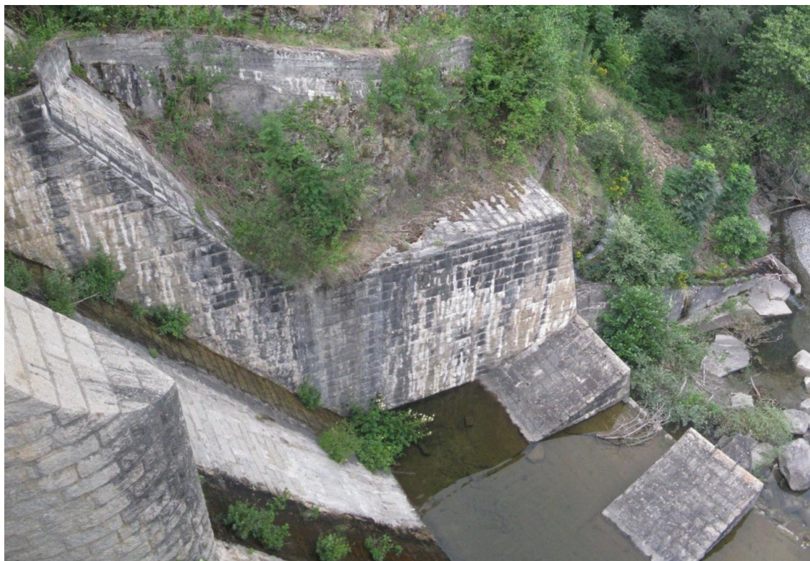
Figura 3. Vista de la presa de la Torrasa y de la escala de peces que se localiza en la margen izquierda del obstáculo. Este paso presenta una elevada pendiente.
