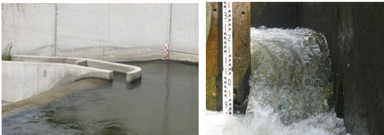
Figura 45. A la izquierda, detalle de la entrada de caudal al paso, emplazada muy próxima a la rasante del azud y a la derecha vertido libre entre dos artesas.
