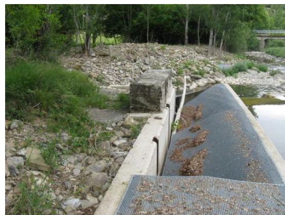
Figura 87. Izquierda, entrada para los peces a la escala del azud del Molino de Sarriés. Derecha, Detalle del tramex que cubre unas artesas.
