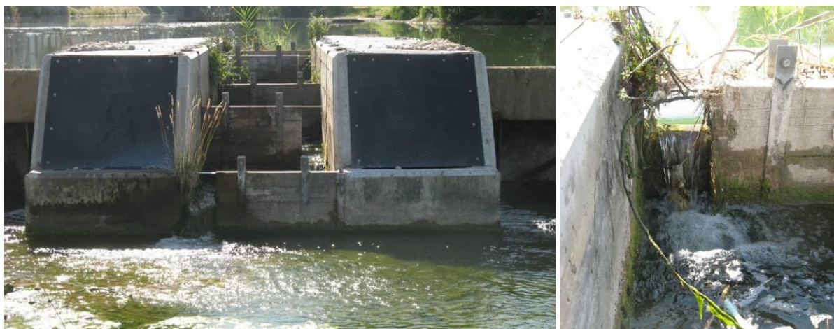
Figura 42. A la izquierda, imagen de la entrada para los peces al paso del azud de la acequia Mayor de Valderrobres. Derecha, Entrada de caudal al paso de la El caudal de llamada en la entrada del paso es muy bajo.
