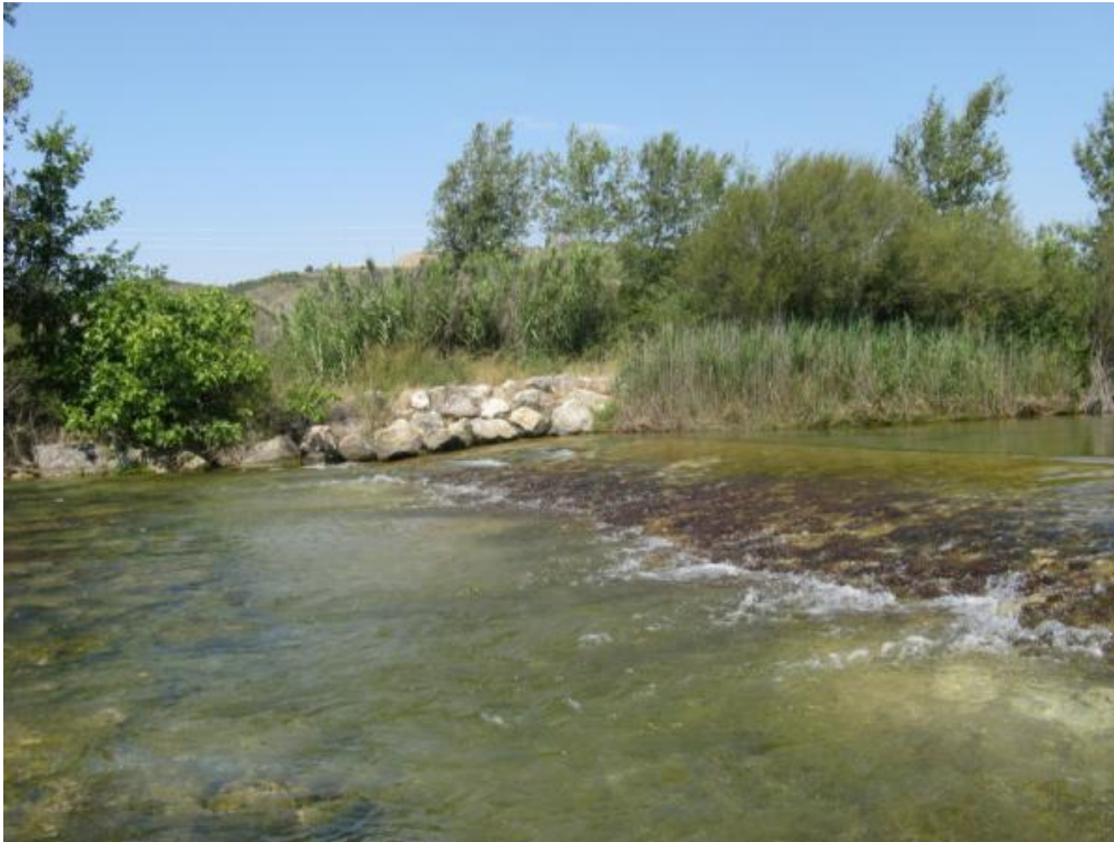
Figura 26. Vista desde el centro del azud de la Piscifactoría de Santa Ana.
