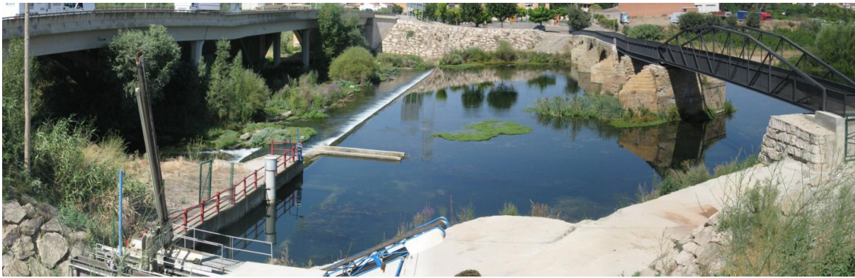
Figura 30. Vista del azud y la escala del canal de Algerri-Balaguer.
