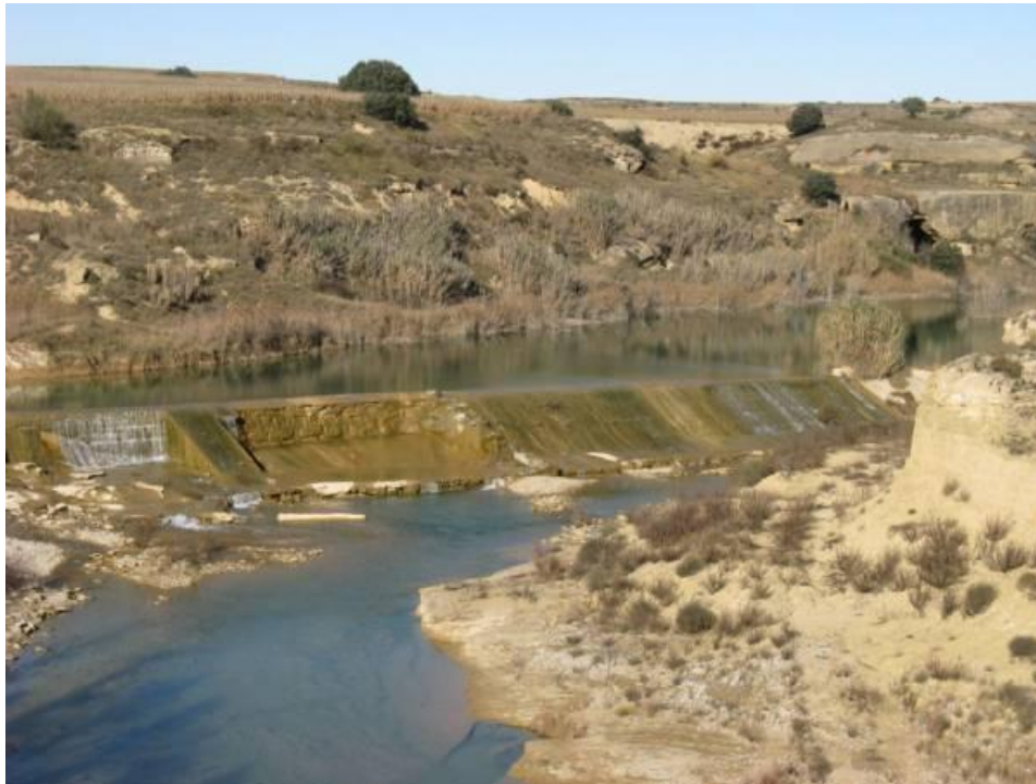
Figura 3. Vista del emplazamiento de la escala, localizada en el centro del azud. El paso apenas cuenta con caudal de llamada en la entrada del paso.
