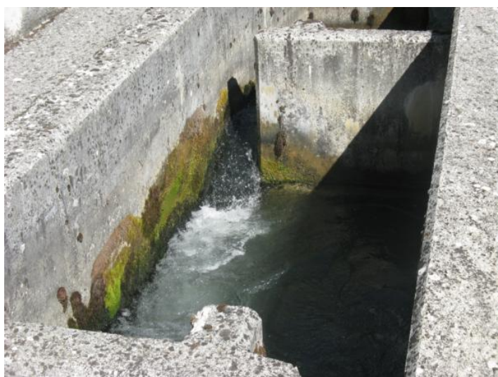
Figura 70. Artesa y vertedero de la escala del azud de la Central Hidroeléctrica de Oroz-Betelu.
