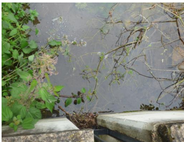
Figura 57. Detalle de la entrada de caudal al paso en mayo de 2018. Como puede apreciarse, la entrada de caudal se encuentra obstruida por materia orgánica que limita la entrada de caudal al paso.
