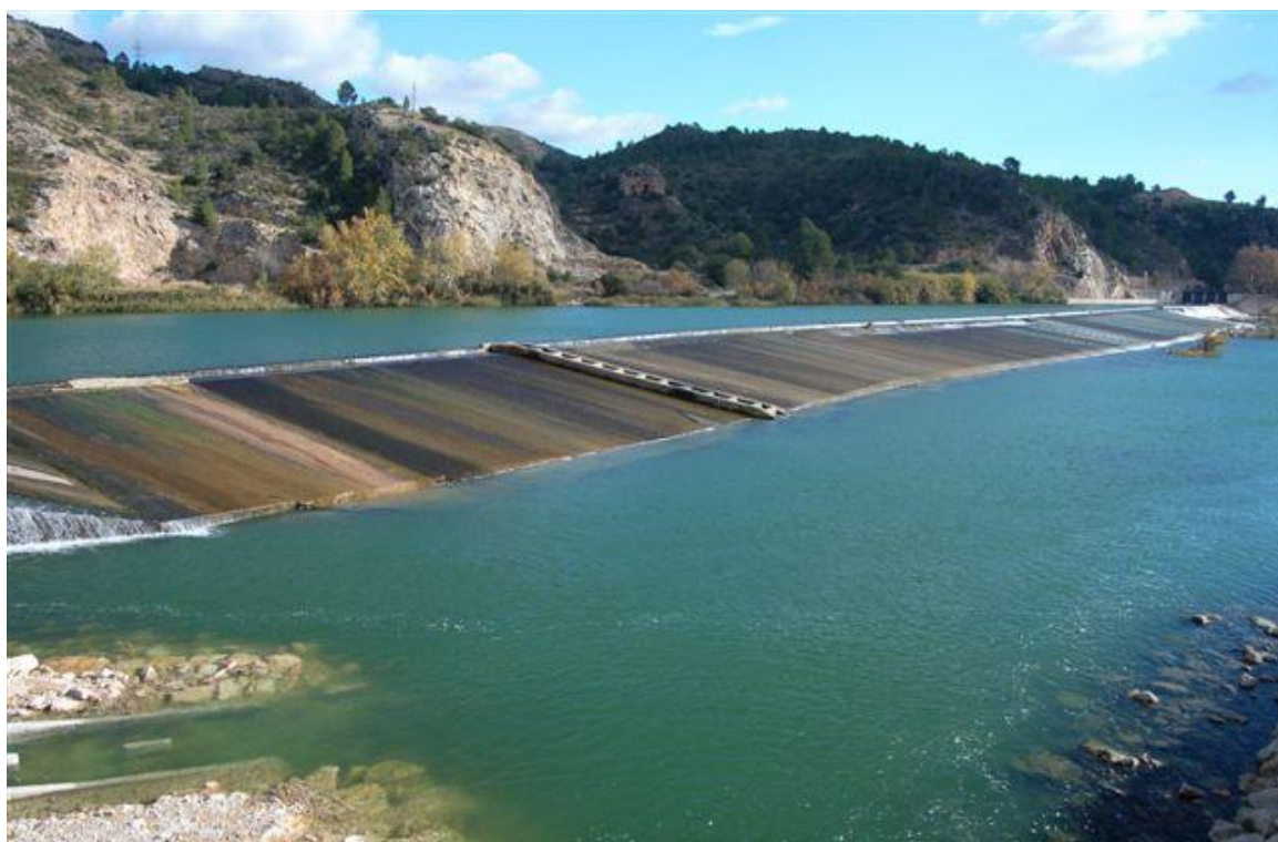
Figura 72. Azud de Xerta y de la primera escala que se construyó emplazada en el centro del azud. En la esquina inferior izquierda se aprecia la entrada para los peces al nuevo paso.
