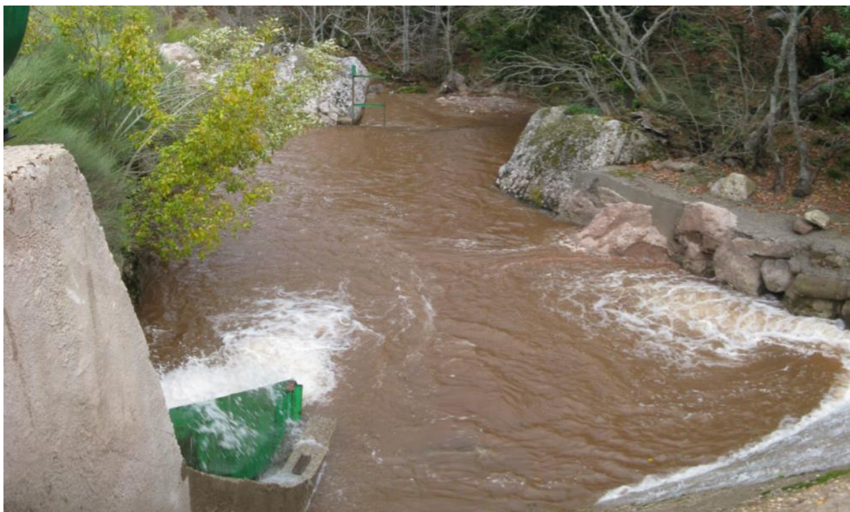
Figura 6. Vista de aguas abajo del azud durante un periodo de aguas altas, como puede observarse la compuerta de la represa de aguas abajo se encuentra cerrada dificultándose o impidiendo totalmente la migración de los peces.
