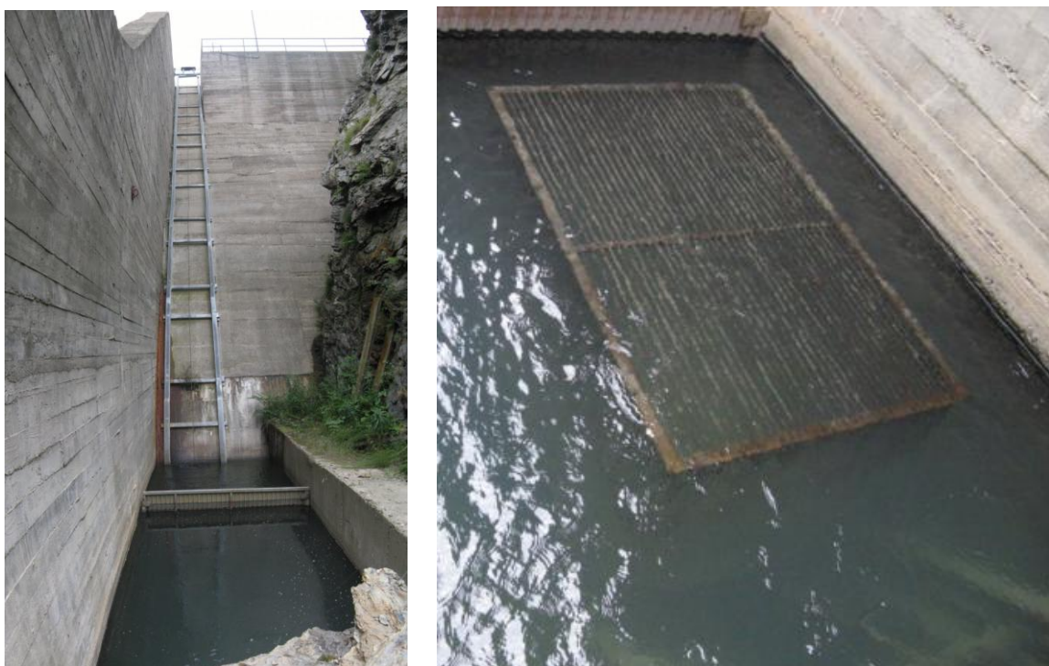
Figura 9. A la izquierda se presenta una imagen de la poza donde está la jaula con la que son remontados los peces y las guías o carriles del ascensor. A la derecha, detalle de la jaula donde se atrapan los peces para remontar la estructura. Para que los peces sean atraídos a esta jaula es necesario un caudal de llamada que atraviese la misma desde aguas arriba hacia aguas abajo, durante la visita este caudal no se apreció por lo que la atracción de los peces a la jaula es reducida o prácticamente nula.
