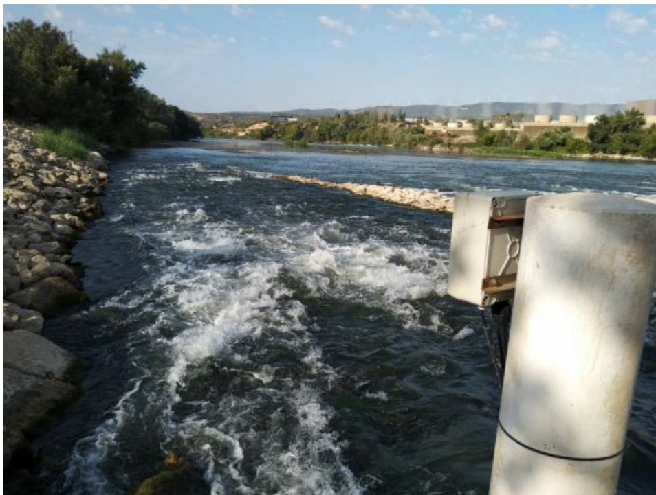
Figura 70. Rampa desde la coronación del azud. En la foto se aprecia la elevada velocidad de la corriente en la rampa, lo cual condiciona en gran medida la franqueabilidad del paso.
