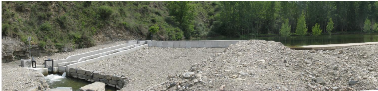
Figura 3. Vista panorámica del azud con la escala de peces en 2011.
