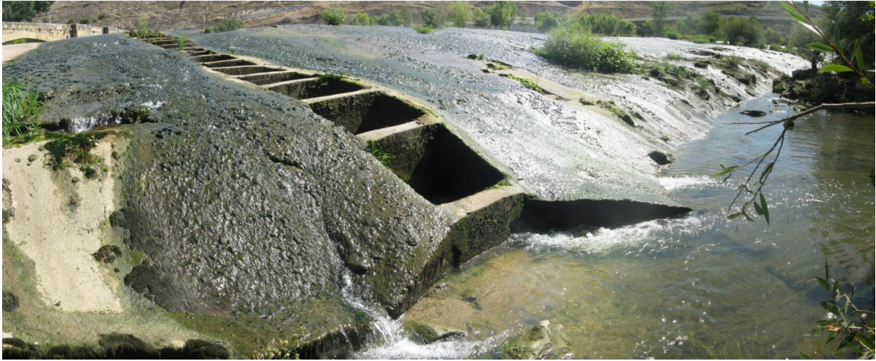
Figura 59. Escala de peces del azud de la CH de San Vicente de la Sonsierra. La llamada en la zona de la entrada al paso es muy baja.
