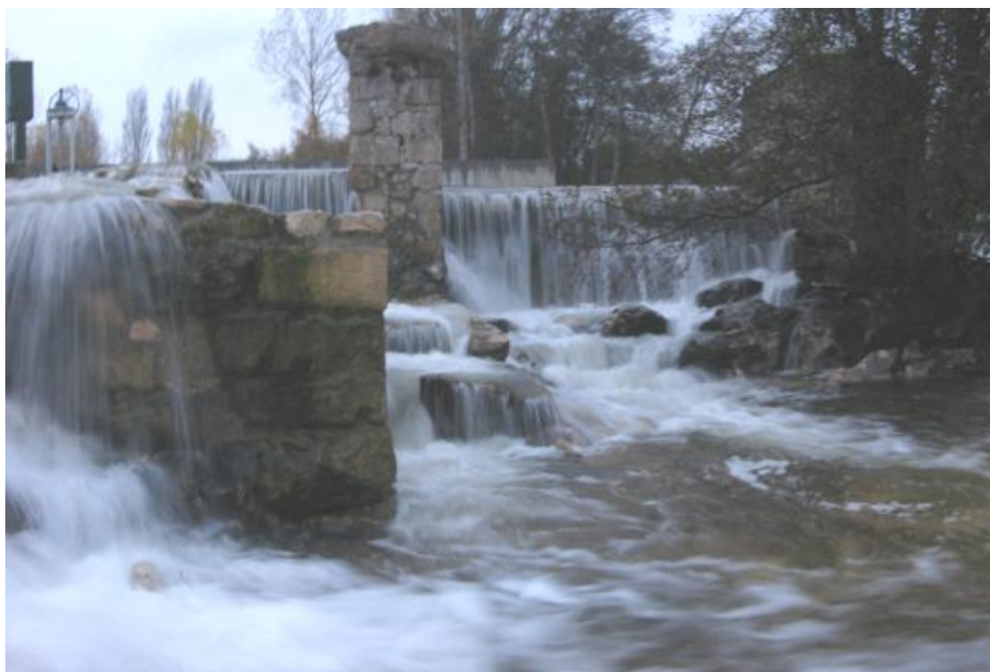
Figura 18. Escala de peces con caudales altos la cual se desborda en varios puntos debido al incorrecto diseño de la entrada de caudal y a que no se han sobredimensionado las artesas.
