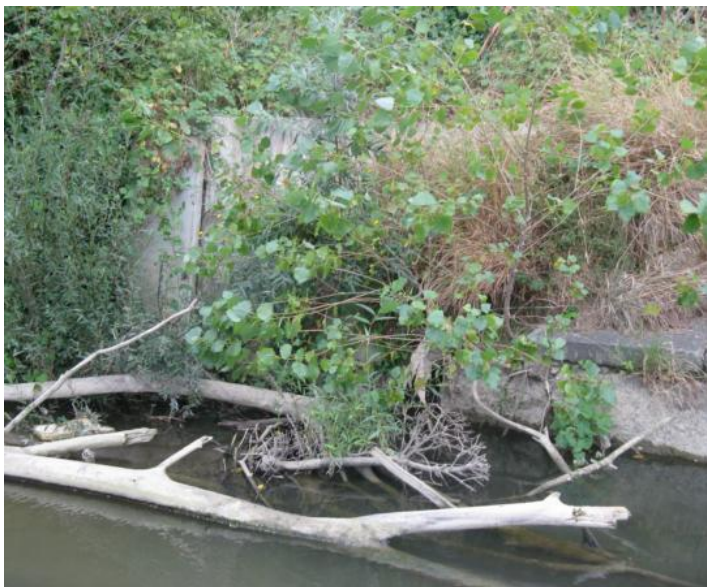
Figura 27. Imagen izquierda, entrada de caudal al paso obstruida por materiales flotantes y vegetación. Imagen derecha, interior de la escala donde se aprecia que apenas circula caudal
