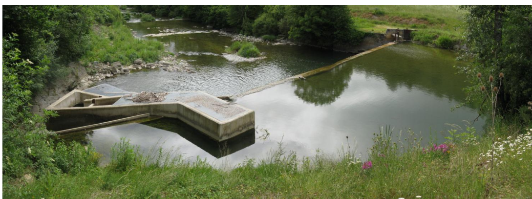
Figura 83. Vista desde aguas arriba de la escala de peces del azud de Electra Molino Esparza de Salazar protegida mediante un trames.
