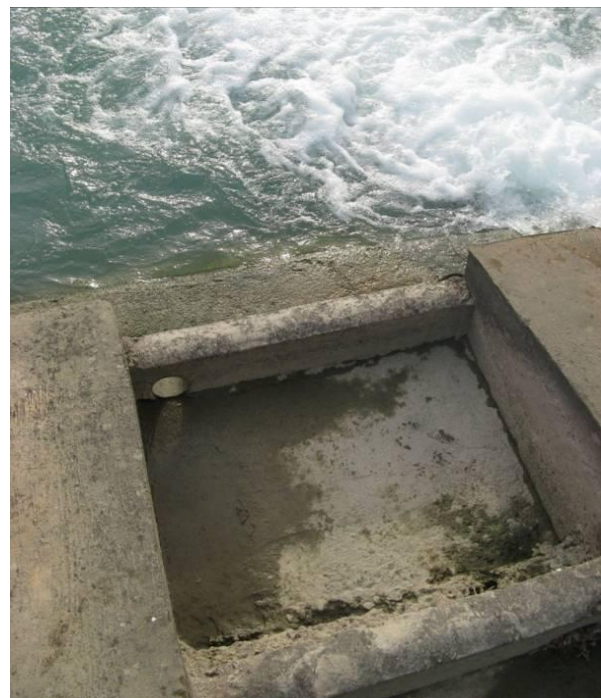
Figura 30. Imágenes de la escala de peces del azud de la C.H. de Javierrelatre II donde se puede observar el bajo calado de las artesas y las pequeñas dimensiones de los orificios de limpieza. Además no circula caudal por el paso y la entrada al mismo no está conectada con la lámina del río de aguas abajo del azud.
