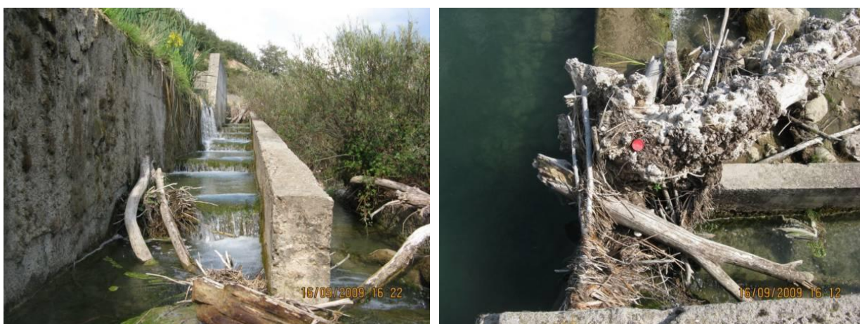
Figura 35. Vista de artesas de la primera de las dos tramadas de la escala. El vertido entre las mismas se realiza en libre. En el primer plano de la imagen izquierda se observa un tronco atrancado al igual que en la entrada de caudal al paso (imagen derecha). Esta falta de mantenimiento puede deberse a que el aprovechamiento se encuentra fuera de uso.
