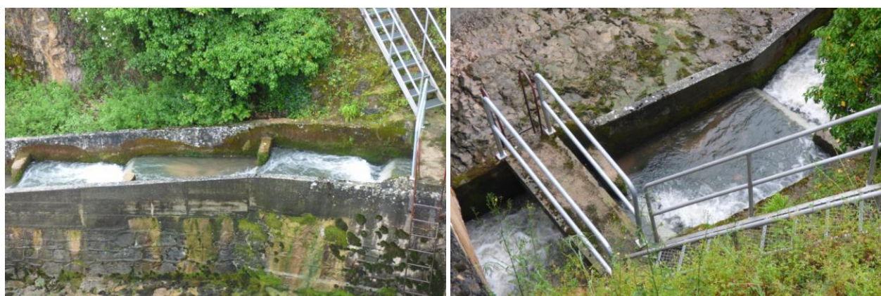
Figura 10. Artesanas en las que se aprecia el vertido en libre entre éstas.
