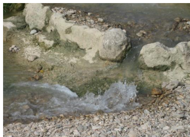
Figura 5. Izquierda: entrada de caudal al paso mediante un vertido en libre. A la derecha, entrada para los peces al paso, desconectada de la lámina de aguas abajo del azud
