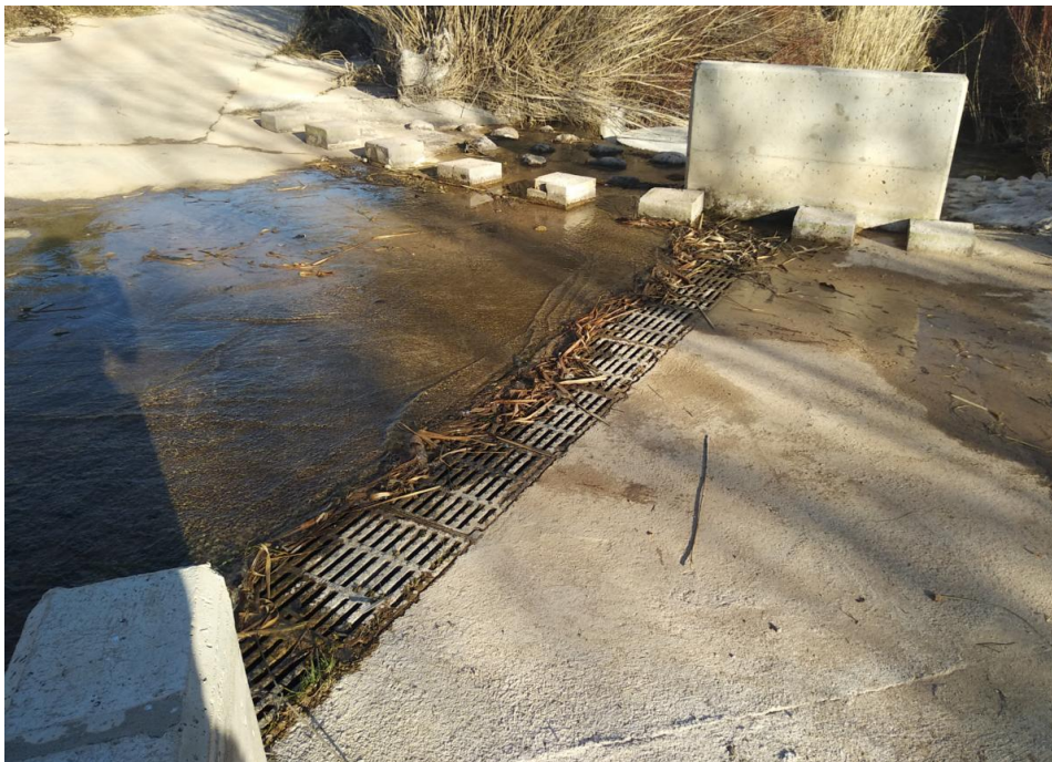
Figura 67. Vista del canal cubierto que conecta la primera y segunda tramada de la escala de peces del Azud de la huerta nueva de Cretas. Este paso es muy oscuro y puede dificultar el tránsito de los peces
