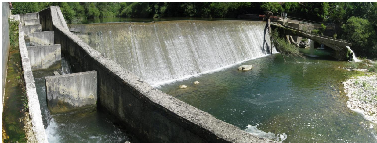
Figura 13. Vista panorámica del azud y la escala de la Central Municipal de Garde.
