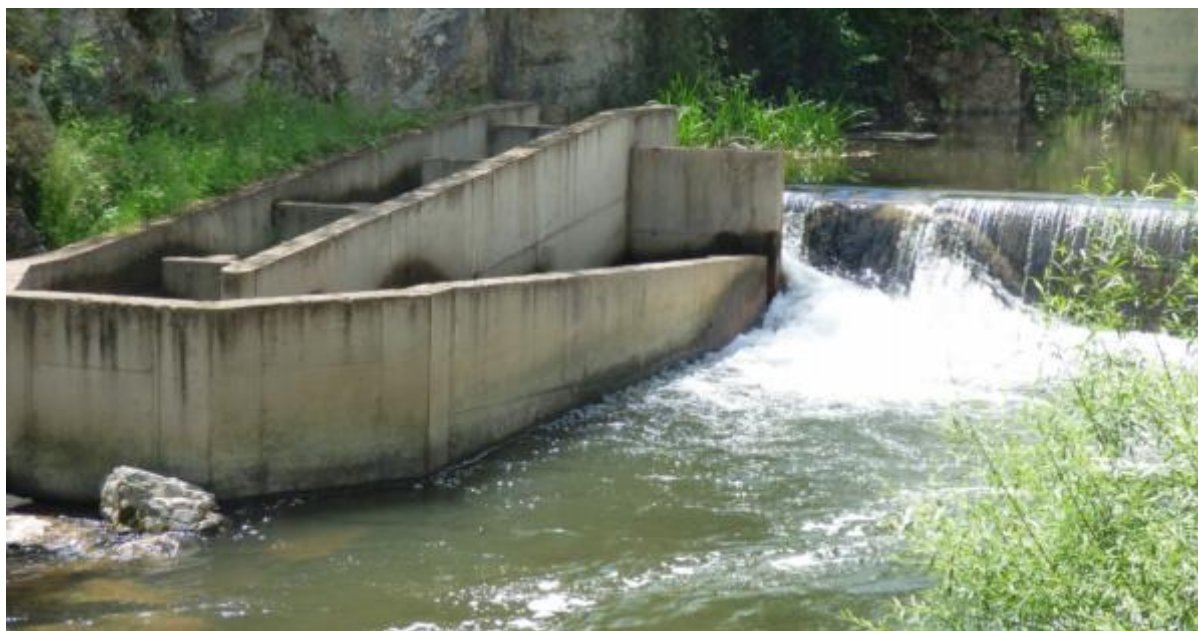
Figura 11. Azud y escala de peces de la CH del Molino de Nieva. Este paso construido en el 2011 se localiza en el costado derecho del azud. En la rasante del azud, a la altura de la entrada a la escala se ha realizado un rebaje en el azud y construido una rampa para incrementar la llamada en la entrada al paso y facilitar la migración descendente de los peces
