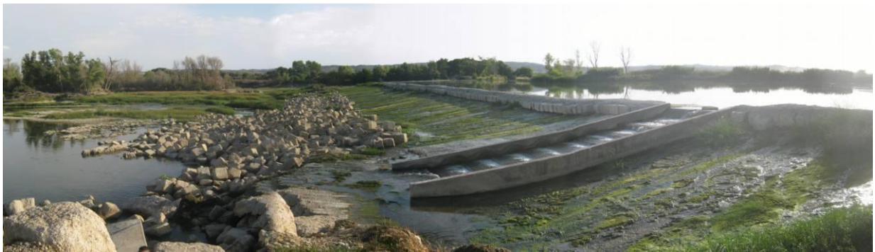
Figura 94. Escala del la margen izquierda del azud de la CH de Pina. Este paso se encuentra desconectado de la lámina del río de aguas abajo del azud.
