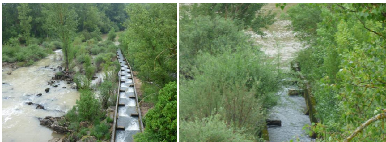
Figura 9. Escala de artesanas sucesivas en vertido libre de la presa de Cillaperlata (izq.). Derecha, entrada al paso para los peces donde no hay caudal de llamada.
