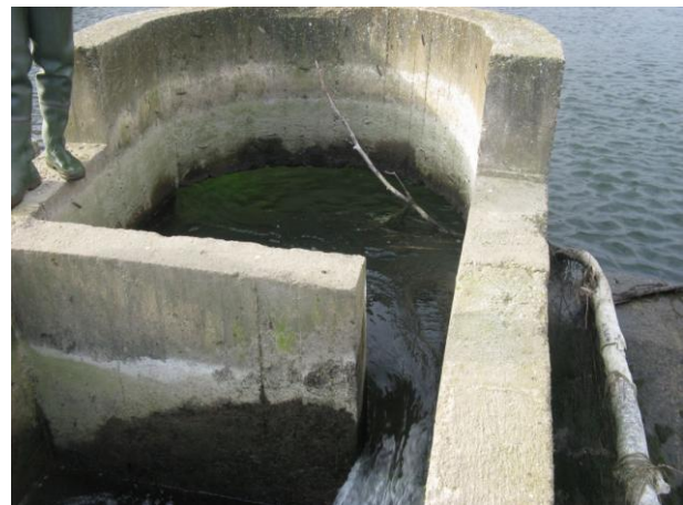
Figura 66. Vista de aguas arriba de la escala de Buicio. Los deflectores del interior de las artesas se construyeron aguas abajo de los tabiques interiores en vez de aguas arriba. La función de estos dispositivos es romper la corriente en la zona del vertedero (derecha). Deflector de la primera artesa (entrada de caudal) el cual evitan en gran medida la entrada de flotantes a la escala, derivándolos hacia los laterales de esta (izquierda).
