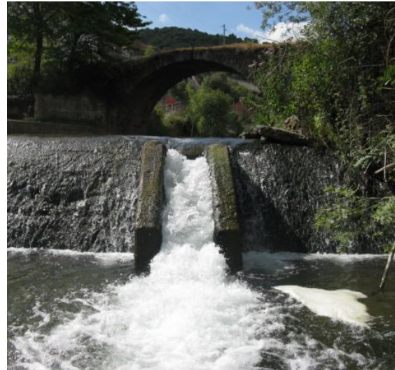
Figura 43. Paso de peces del azud de la piscifactoría de Bobadilla. El caudal que circula por él es mayor que el que esta puede soportar, por lo que las potencias y velocidades internas son muy elevadas, imposibilitando así la entrada y remonte de cualquier especie piscícola.
