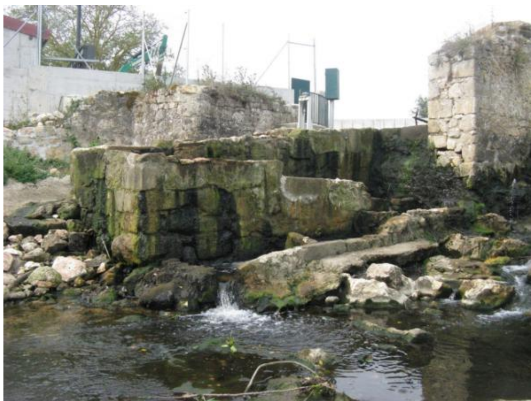
Figura 17. Escala de peces en funcionamiento. La entrada de aguas abajo del azud está desconectada de la lámina del río de aguas abajo del azud. Además, apenas existe caudal de llamada que favorezca la atracción de los peces a la entrada del paso.
