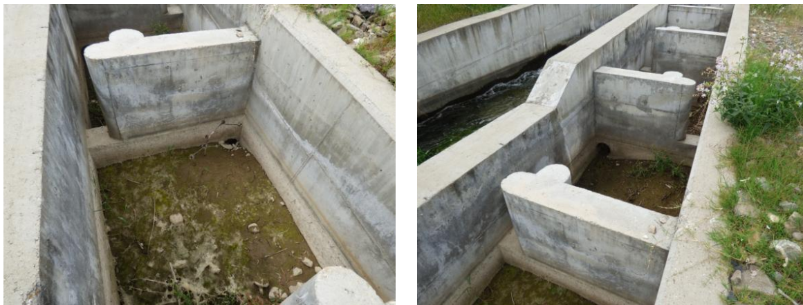
Figura 7. Interior de las artesas en verano de 2018 (están ligeramente colmatadas, fundamentalmente las de la parte baja del paso).
