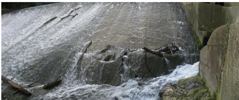
Figura 22. La entrada a la escala no presenta conexión alguna con la lámina de agua del río aguas abajo del azud.
