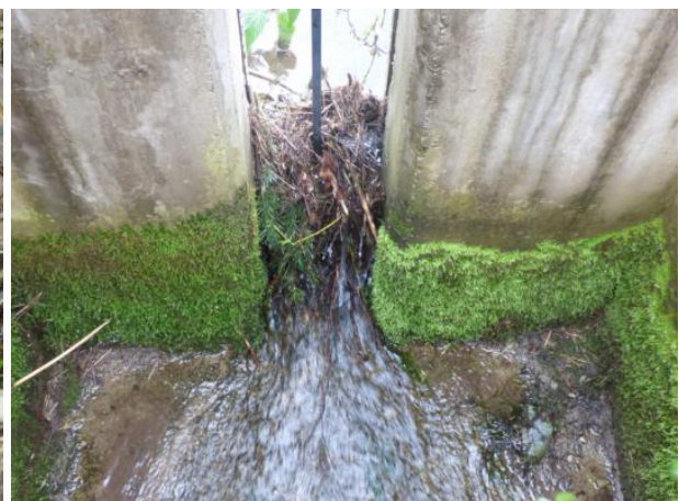
Figura 57. Detalle de la entrada de caudal al paso en mayo de 2018. Como puede apreciarse, la entrada de caudal se encuentra obstruida por materia orgánica que limita la entrada de caudal al paso.
