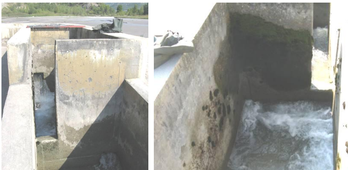
Figura 18. Vista de la escala de peces de la toma de la C.H. Graus durante un periodo de aguas bajas (izquierda) y durante un periodo de aguas altas (derecha). Vista del interior de las artesas de la escala de peces durante un periodo de aguas bajas. Todo el caudal que circula por la escala discurre por los orificios sumergidos.
