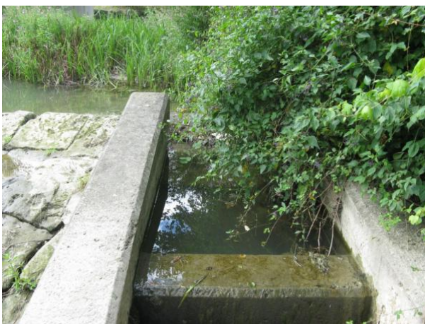
Figura 25. Vista de la entrada de caudal a la escala obstruida.
