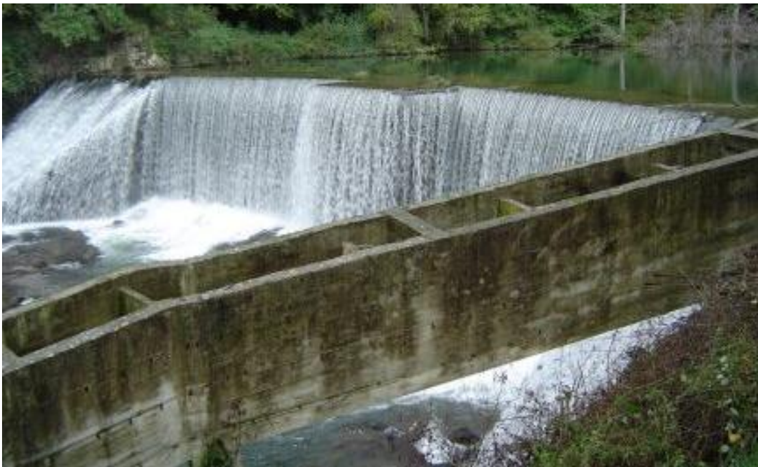
Figura 19. Vista de un tramo de la escala de peces.
