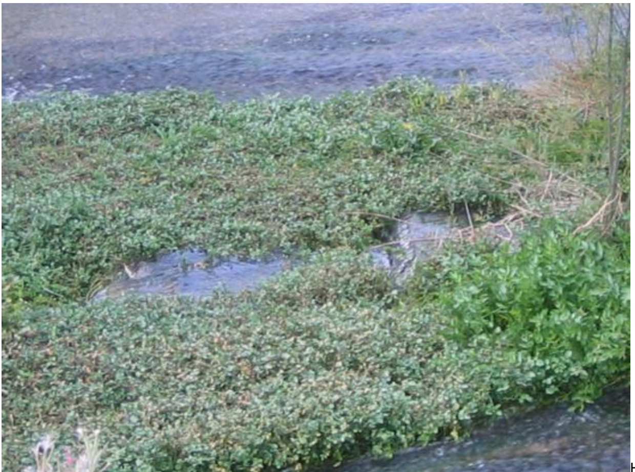
Figura 35. Detalle de uno de los saltos del paso del azud de Albesa camuflado parcialmente por la vegetación.
