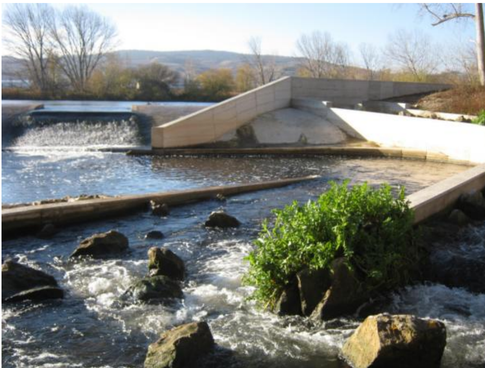
Figura 72. Vista del rebaje practicado en el azud para incrementar el caudal en la entrada de la rampa y permitir las migraciones descendentes.
