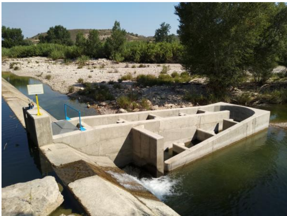
Figura 59. Paso de peces en junio de 2018. Durante la visita de campo la compuerta de entrada de caudal al paso se encontraba cerrada.
