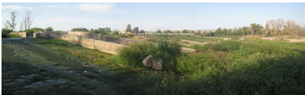
Figura 90. Azud de la CH de Pina y de la escala de peces de la margen desde aguas abajo.
