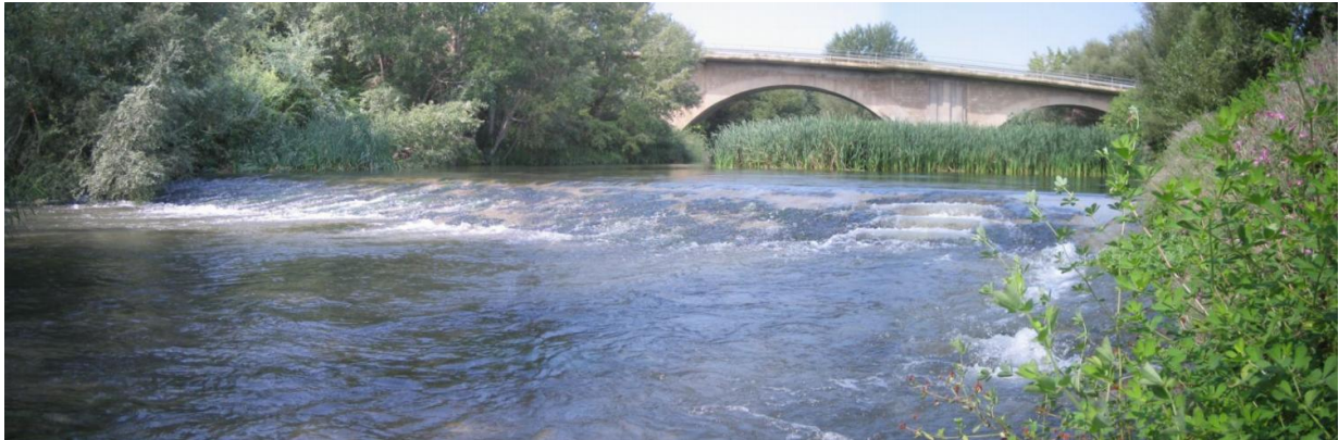
Figura 36. Vista del azud de Torrelameu y del paso localizado en el costado de la margen izquierda.
