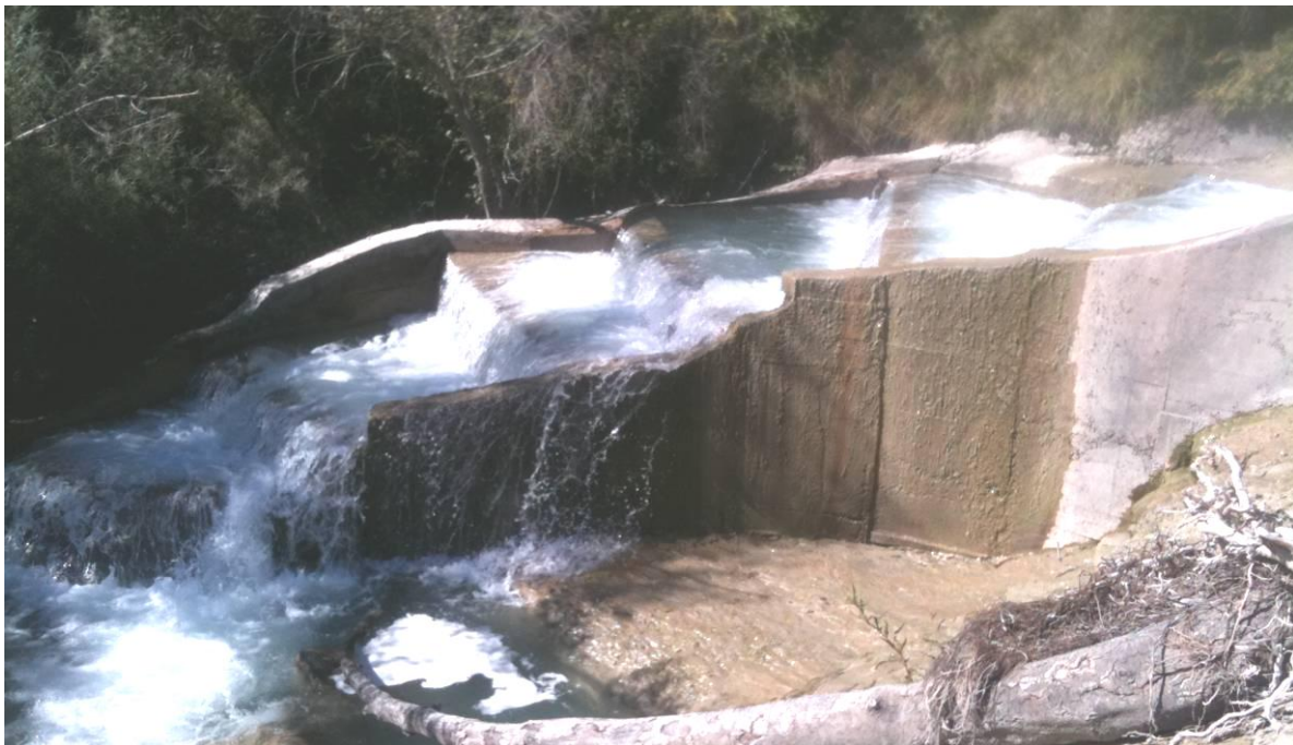
Figura 9. Detalle del paso donde se observa el reducido tamaño de las artesas, las aguas blancas que denotan la elevada energía que hay en su interior y que el vertido entre ellas es en libre. Fuente: Pedro Peyron.
