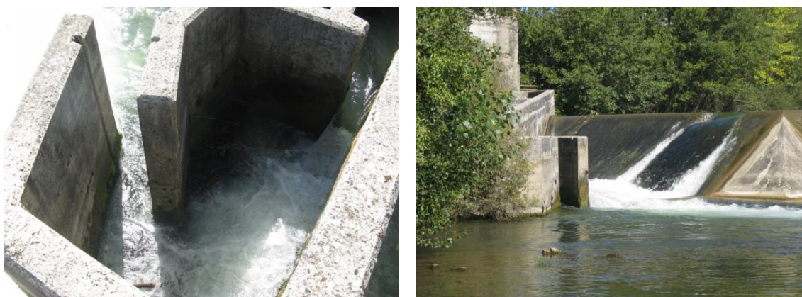
Figura 71. Izquierda, primera artesa después de la entrada de caudal y salto entre ésta y la segunda. Derecha, entrada de la escala para los peces la cual se encuentra a nivel. En esta zona existe un importante caudal de llamada que atrae los peces a la entrada del paso.
