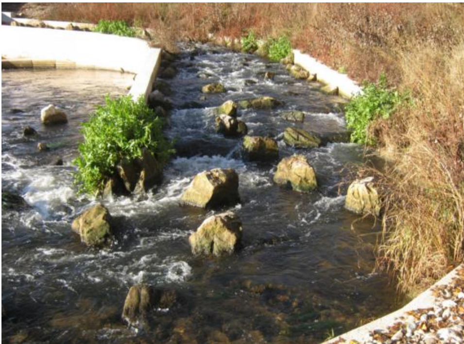
Figura 70. Tramo previo al giro de 180 ° de la rampa de bloques de perturbación de la CH de Buicio.
