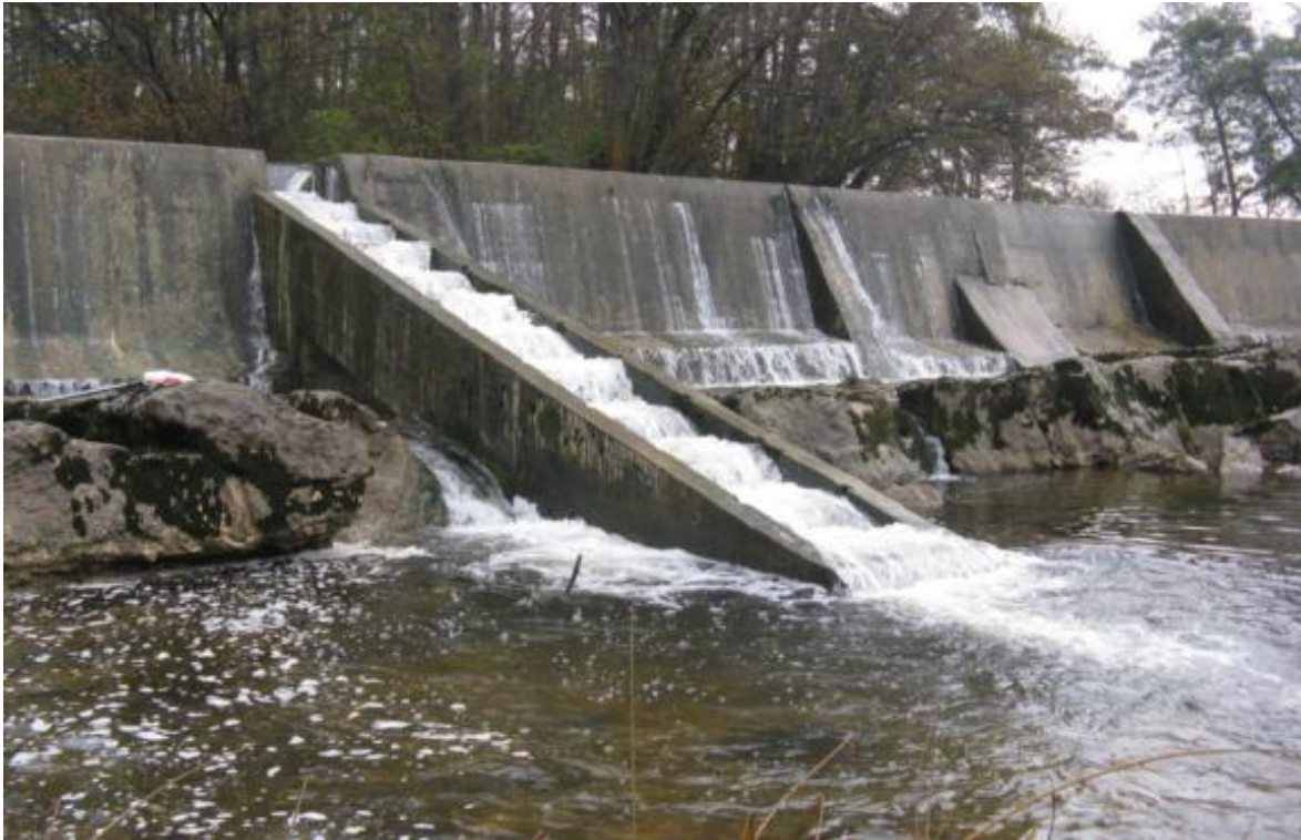
Figura 20. Escala de peces de artesas sucesivas en vertido libre de la CH de Nofuentes donde el caudal circula por encima de los tabiques de los vertederos.
