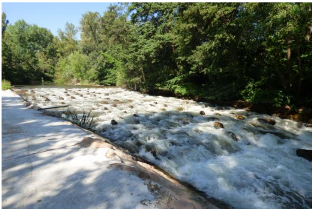
Figura 46. Rampa de bloques de perturbación en el azud de la C.R. de Ciudad de Cenicero en el mes de junio de 2018.
