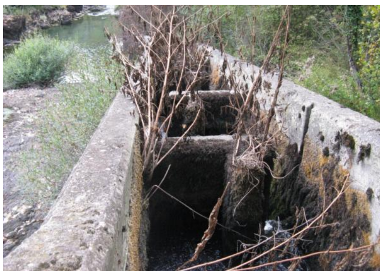
Figura 48. Interior de la escala de artesas del azud de San Fausto colonizado por vegetación
