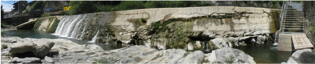
Figura 10. Escala del azud de la Electra Municipal de Roncal. En el costado izquierdo del azud se encuentra la rampa para el descenso de troncos que permite la migración descendente de los peces.
