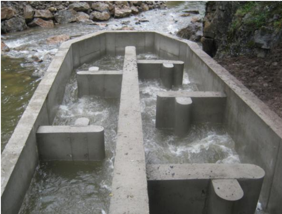
Figura 13. Giro de la escala de la CH del Molino de Nieva que conecta la primera y la segunda tramada del paso. La artesa del giro se ha realizado mediante ángulos mayores de 90 °.
