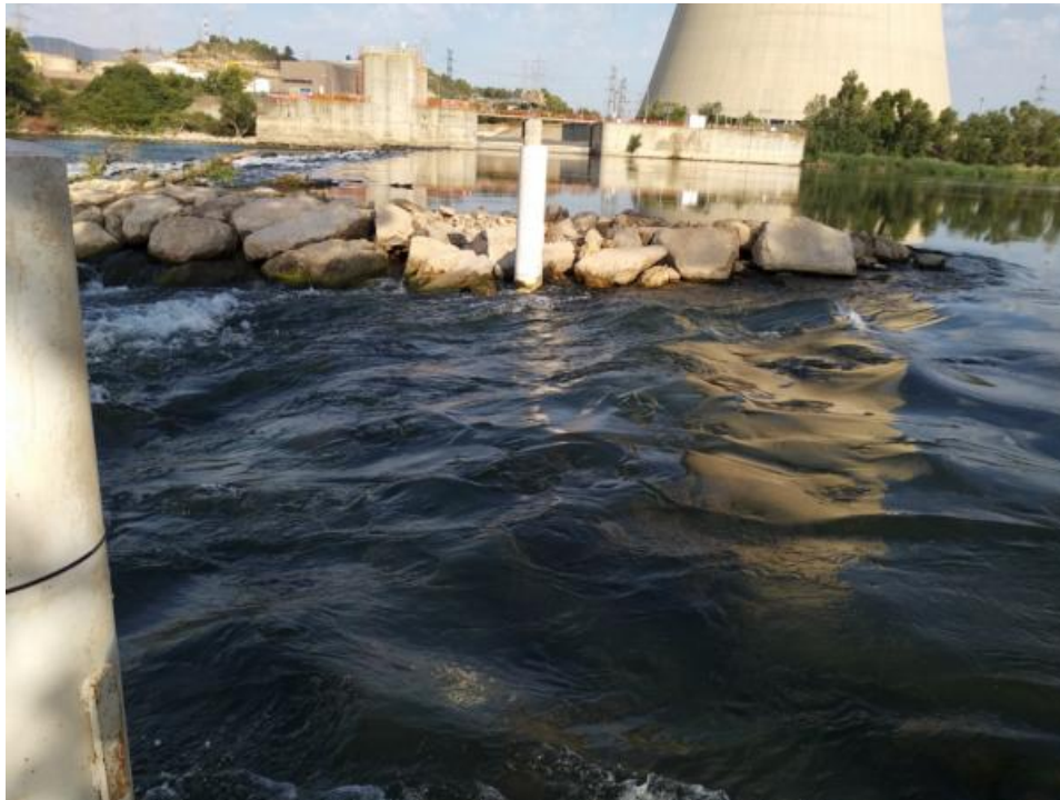
Figura 69. Vista de la entrada de caudal al paso en la que se ha instalado un sensor para evaluar la franqueabilidad del paso
