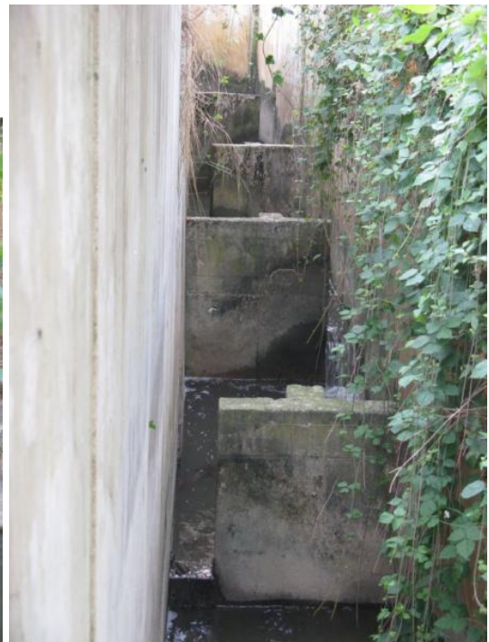
Figura 27. Imagen izquierda, entrada de caudal al paso obstruida por materiales flotantes y vegetación. Imagen derecha, interior de la escala donde se aprecia que apenas circula caudal
