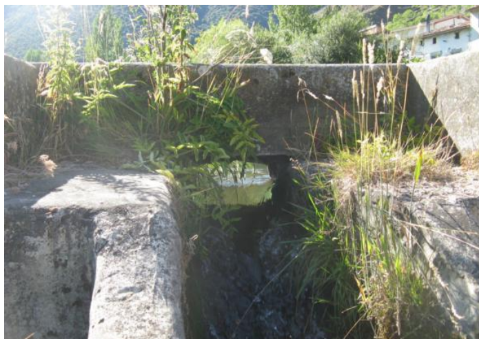
Figura 37. Entrada de caudal a la escala de la CH de Las Cuevas mediante un orificio estrecho.
