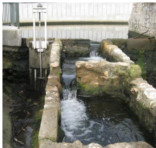
Figura 19. Izquierda, artesa de entrada de caudal después de acabar su construcción, presentando un calado muy bajo y sin vertedero. Derecha, entrada de caudal donde se aprecia que se ha recrecido la artesa construyendo un vertedero por el que se regula el caudal de entrada al paso.
