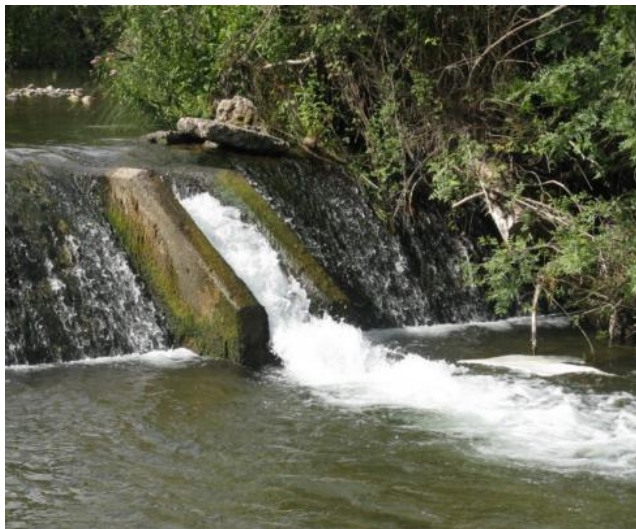
Figura 43. Paso de peces del azud de la piscifactoría de Bobadilla. El caudal que circula por él es mayor que el que esta puede soportar, por lo que las potencias y velocidades internas son muy elevadas, imposibilitando así la entrada y remonte de cualquier especie piscícola.
