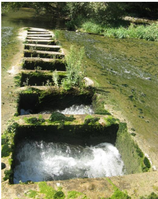
Figura 60. Vista del paso excavado en el azud (izquierda) y a entrada de caudal al paso, cuando circula poco caudal por el río y este no rebosa por el azud el caudal entra a través de un orificio sumergido. El día de la visita el calado en el interior de las artesas era muy bajo.
