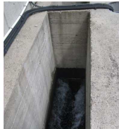
Figura 12. medidor de nivel (izquierda) instalado en la artesa de entrada para los peces. A la derecha compuerta que regula la entrada de caudal al paso, y primera artesa por donde el caudal circula a una velocidad muy elevada y con un calado muy bajo, hecho que condiciona totalmente la funcionalidad del paso.
