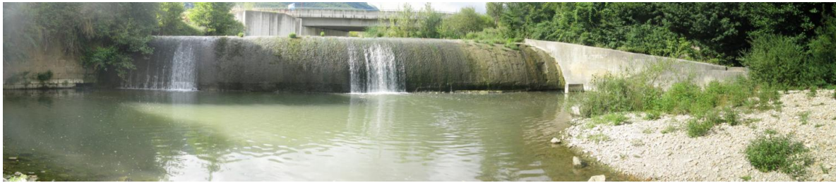
Figura 23. Vista de la escala en el azud de la Presa de la central de Altsasu/Alsasua.
