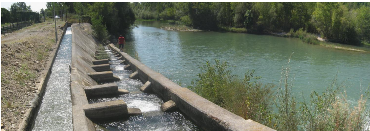
Figura 60. La entrada al paso se encuentra muy alejada de la base del obstáculo y no existe caudal de llamada, es por ello que resulta muy complicado que los peces encuentren fácilmente la entrada a la escala.
