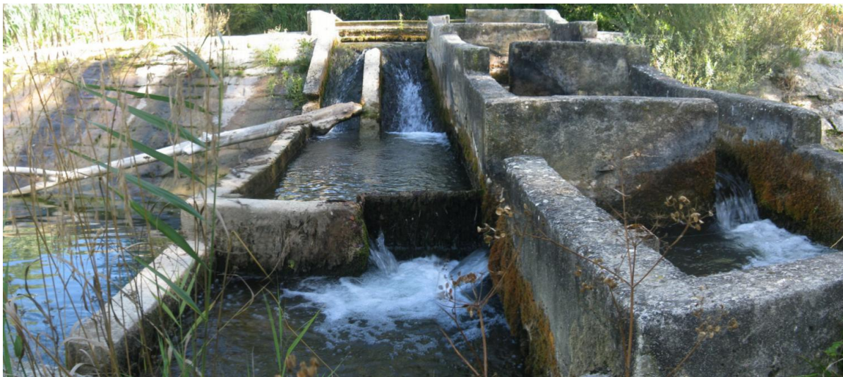
Figura 73. Interior de la escala del azud de la de la Electra de Urroz. Junto al último estanque y paralelo a la escala, se ha construido una artesa que recoge el agua desde la rasante del azud y lo vierte al primer estanque del paso a través de un vertedero protegido por una reja, incrementándose el efecto llamada en la entrada del mismo.
