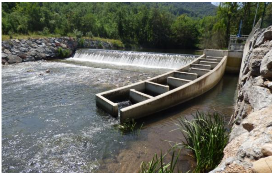
Figura 23. Vista del azud y la escala de peces de la nueva toma de aguas de Logroño
