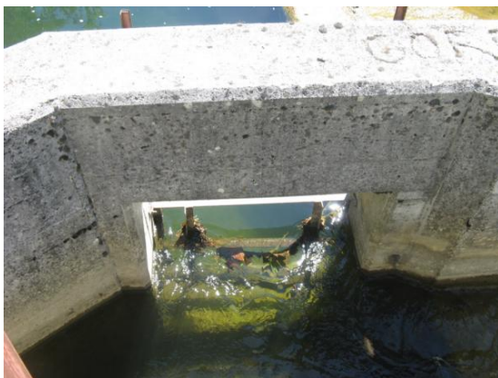
Figura 62. Izquierda, orificio de entrada de caudal a la escala de la Central Hidroeléctrica de Oroz Betelu. Derecha, entrada a la escala para los peces, la cual presenta una mayor sección que el resto de vertederos, por lo que la carga de vertido en este es menor que en el resto de los tabiques.
