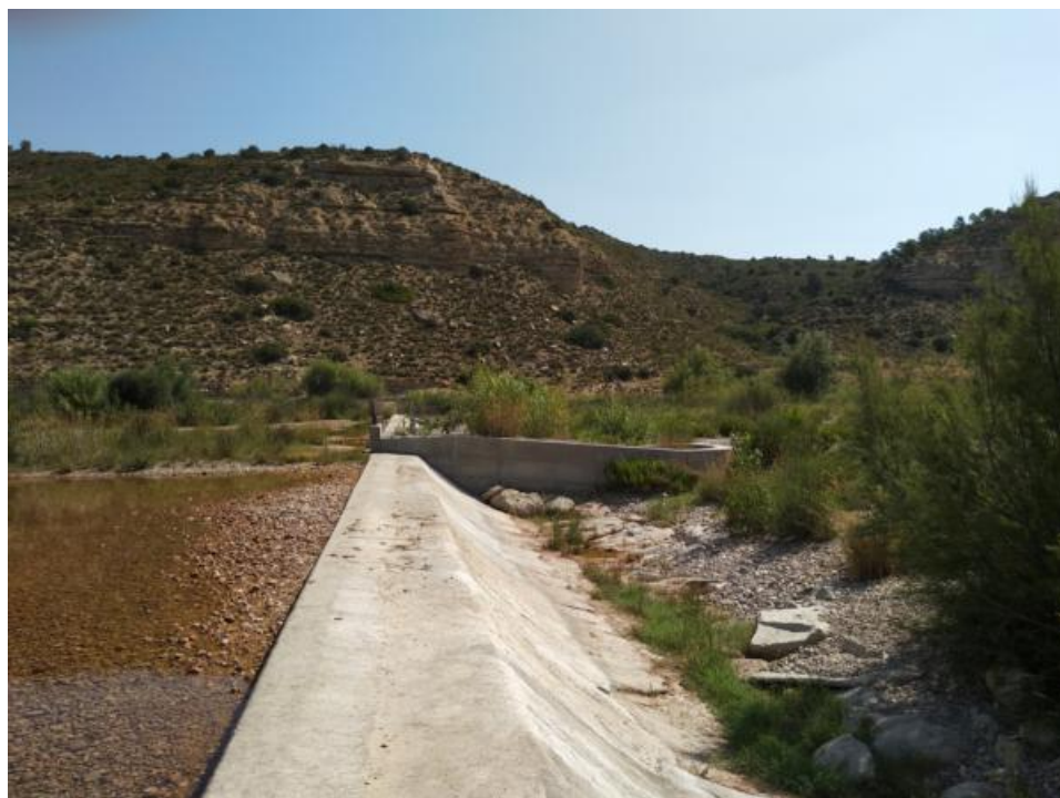
Figura 54. Vista del azud del Matarraña y la escala de artesas
