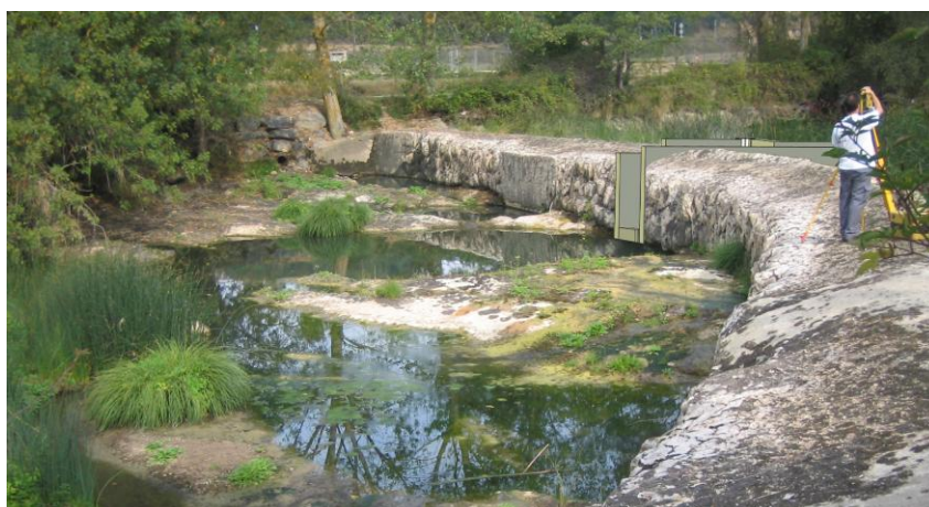
Figura 1. Vista de la recreación del paso del azud del Molino de Pobes en el río Bayas.
