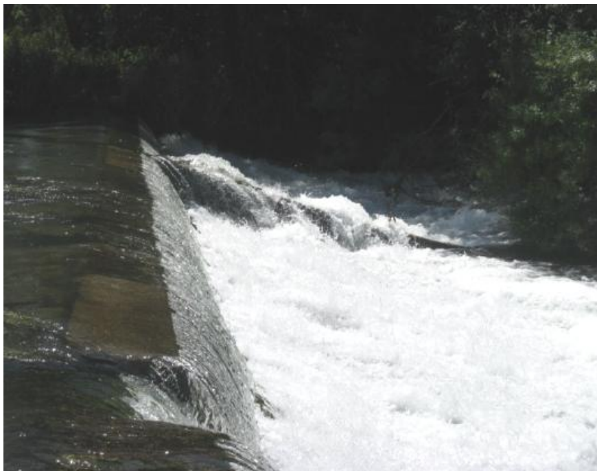
Figura 18. Escala del azud de la Central de Torrecilla. El caudal que circula por la escala es superior al de diseño; en consecuencia se producen unas velocidades y potencias elevadas que imposibilitan el franqueo del obstáculo por parte de los peces.
