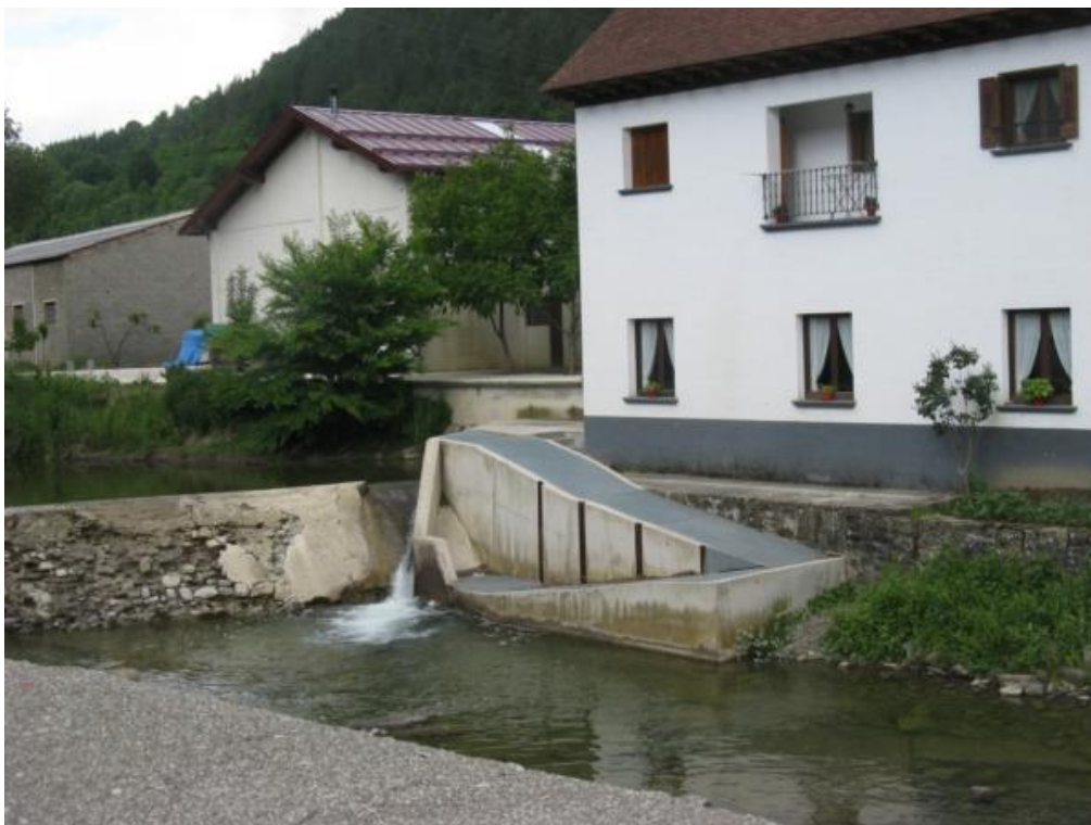
Figura 75. Escala del azud del Molino de Ochagavía, emplazada en la margen izquierda
