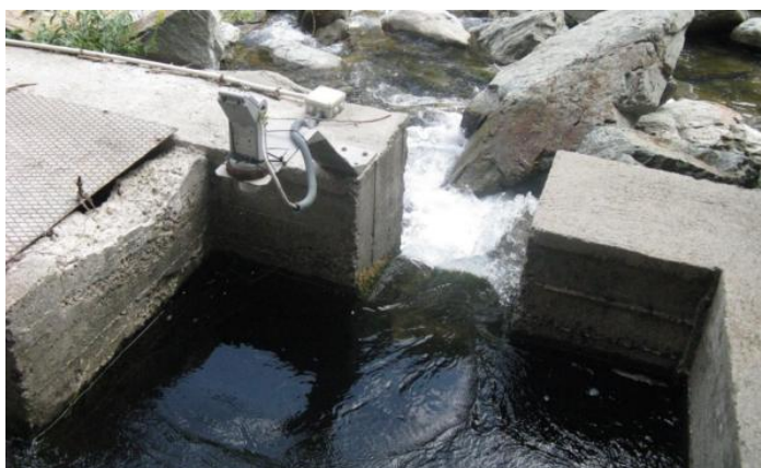
Figura 12. medidor de nivel (izquierda) instalado en la artesa de entrada para los peces. A la derecha compuerta que regula la entrada de caudal al paso, y primera artesa por donde el caudal circula a una velocidad muy elevada y con un calado muy bajo, hecho que condiciona totalmente la funcionalidad del paso.
