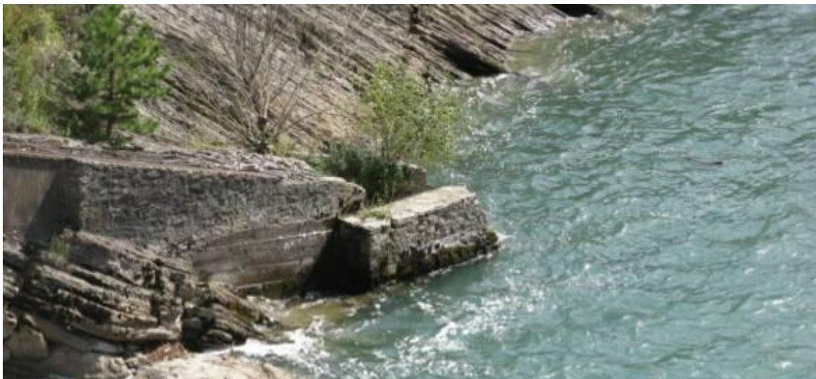
Figura 16. Detalle de la entrada a la escala por la que no discurre caudal, además se encuentra muy alejada del obstáculo y no dispone de caudal de llamada para atraer los peces a su entrada.
