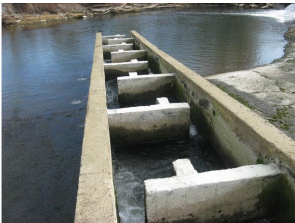
Figura 66. Vista de aguas arriba de la escala de Buicio. Los deflectores del interior de las artesas se construyeron aguas abajo de los tabiques interiores en vez de aguas arriba. La función de estos dispositivos es romper la corriente en la zona del vertedero (derecha). Deflector de la primera artesa (entrada de caudal) el cual evitan en gran medida la entrada de flotantes a la escala, derivándolos hacia los laterales de esta (izquierda).
