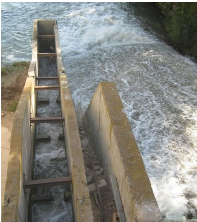
Figura 96. A la izquierda vista general de la escala de peces. Como puede observarse en algún tabique el caudal rebosa por encima debido a que los orificios sumergidos se encuentran obstruidos. A la derecha se presentan dos imágenes la de arriba se corresponde con la entrada de caudal al paso que es mediante un orificio sumergido y la entrada para los peces al mismo. Como puede observarse hay mucha espuma en la zona de entrada al paso debido al caudal que se deriva por la rampa que hay en el costado izquierdo de la escala.
