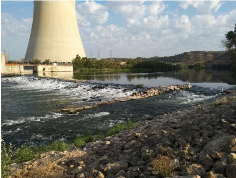
Figura 67. Azud de la central nuclear de Ascó y la rampa construida en el costado de la margen izquierda
