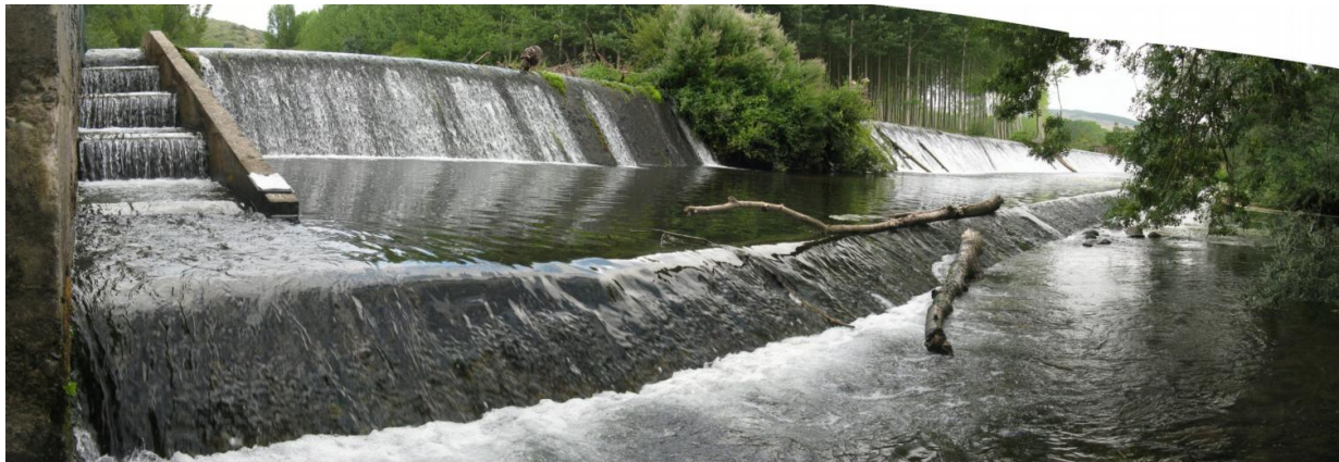
Figura 44. Azud de la Margen Derecha del Najerilla y escala de artesas.
