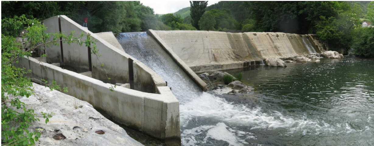
Figura 77. Azud de la CH. de Ezcároz, escala de peces y tobogán para mejorar la migración de descenso y el caudal de llamada en la entrada del paso para los peces.
