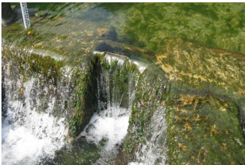
Figura 43. Entrada de caudal la escala antigua de la piscifactoría de Zudaite, obstruida mediante una compuerta manual.
