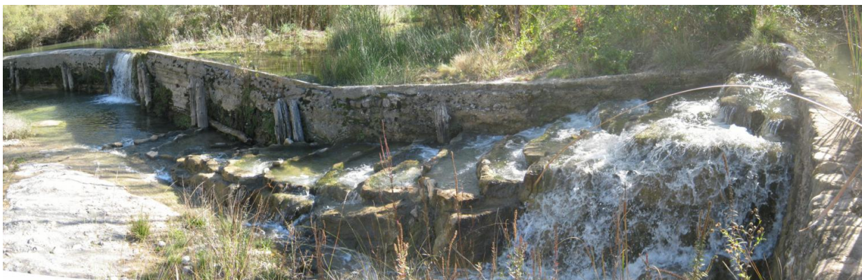
Figura 7. Panorámica del paso desde aguas arriba.
