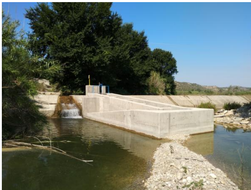
Figura 62. Vista del paso desde aguas abajo. A la izquierda del paso, en el azud, se localiza el rebaje practicado en la coronación del mismo para incrementar el caudal de llamada en la entrada del paso
