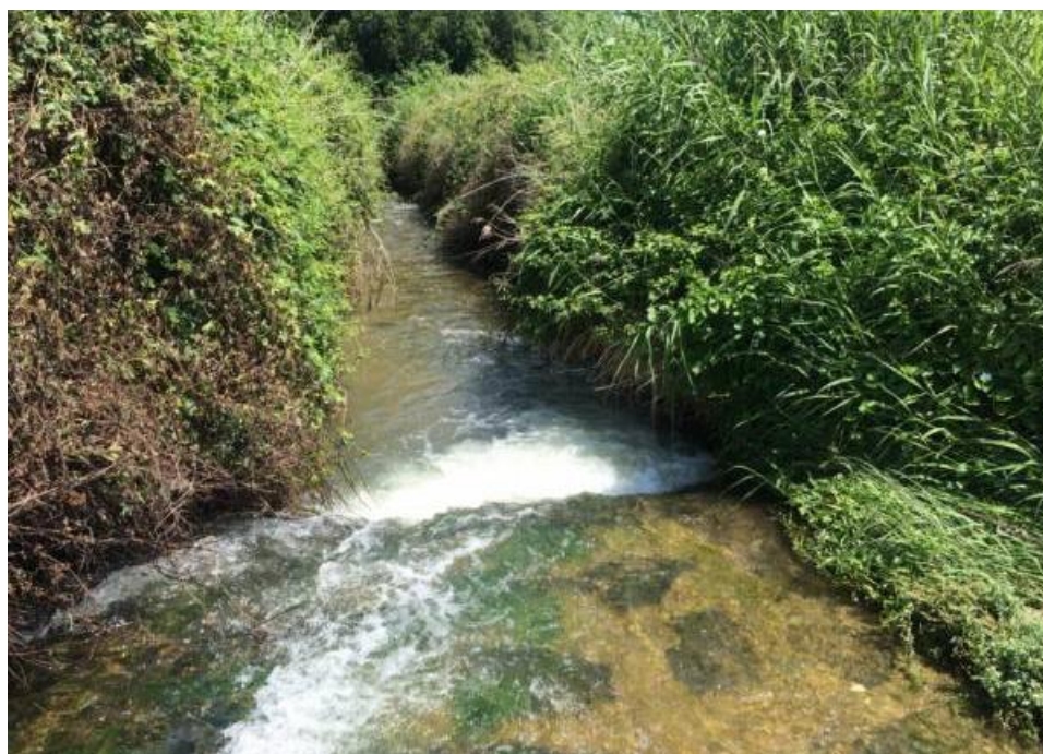
Figura 83. Salto existente aguas abajo del azud de la CR de Ablitas y la entrada para los peces.
