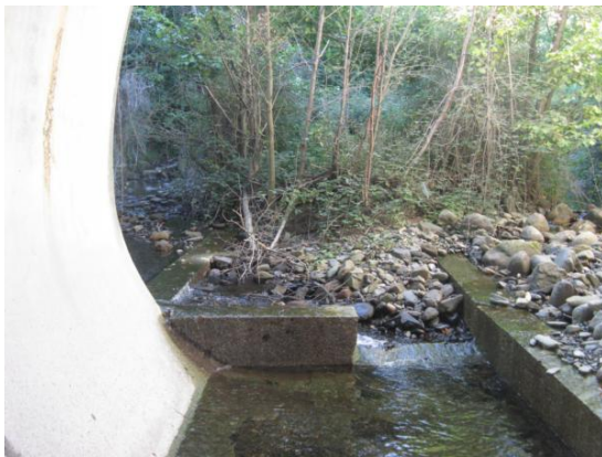
Figura 31. Imagen izquierda: entrada de caudal al paso obstruida por sedimentos, lo que dificulta la salida de los peces del paso. Imagen derecha: Entrada al paso para los peces descolgada del nivel del agua del barranco aguas abajo del obstáculo.
