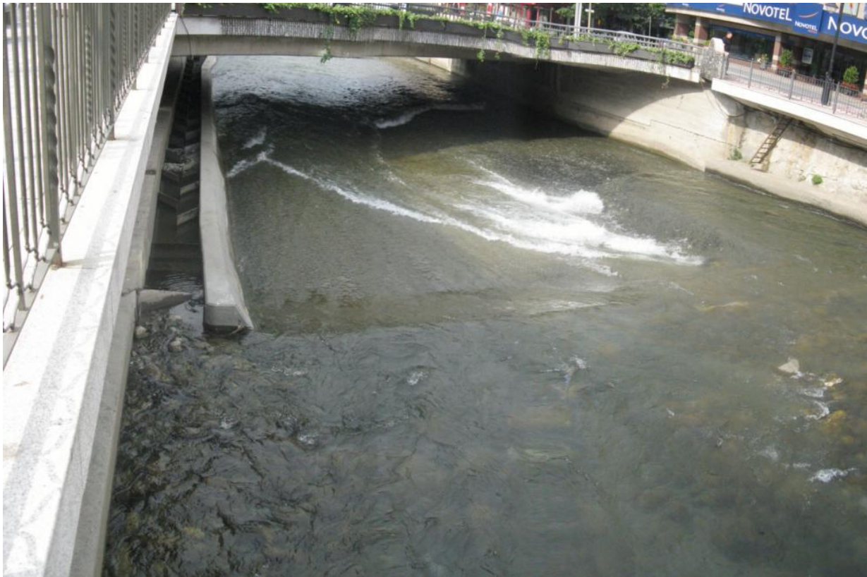
Figura 8. Entrada de caudal del tercero de los pasos obstruida por sedimentos.
