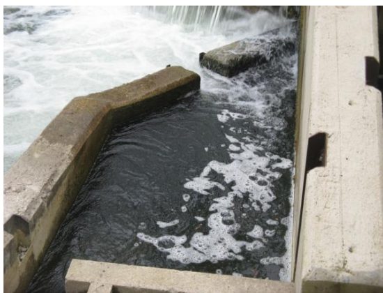
Figura 87. Izquierda, entrada para los peces a la escala del azud del Molino de Sarriés. Derecha, Detalle del tramex que cubre unas artesas.
