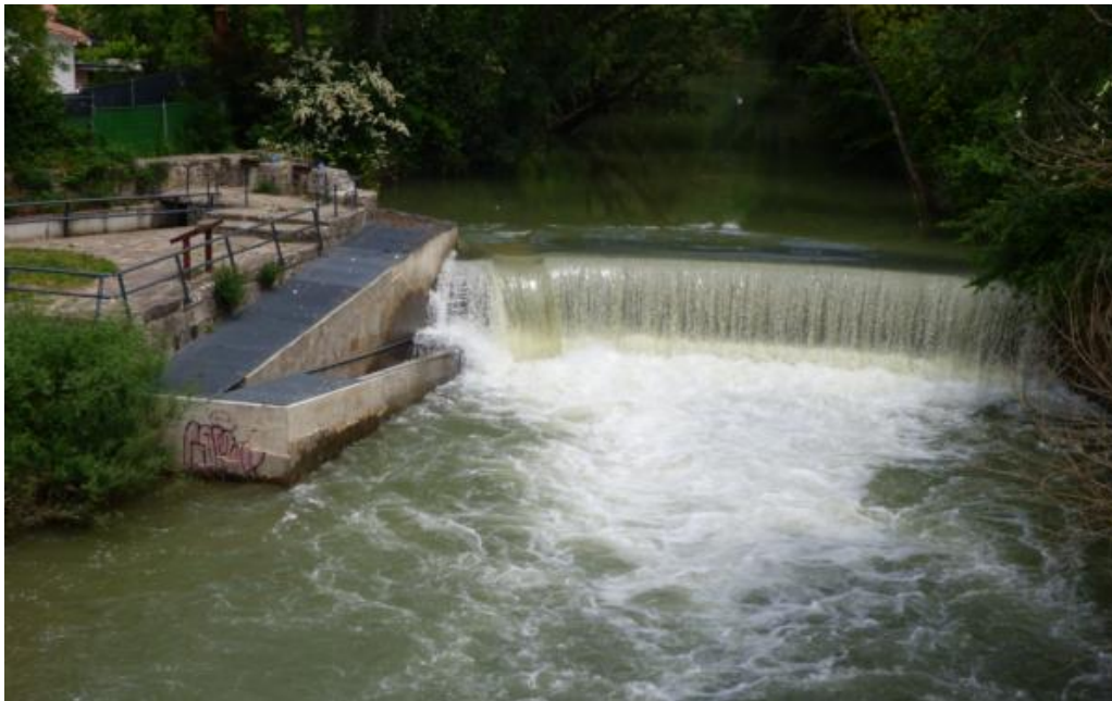
Figura 36. Vista de la escala de artesas sucesivas de la Presa del Molino de San Antonio. El paso se ha cubierto con trames para minimizar accidentes al encontrarse en un parque urbano.
