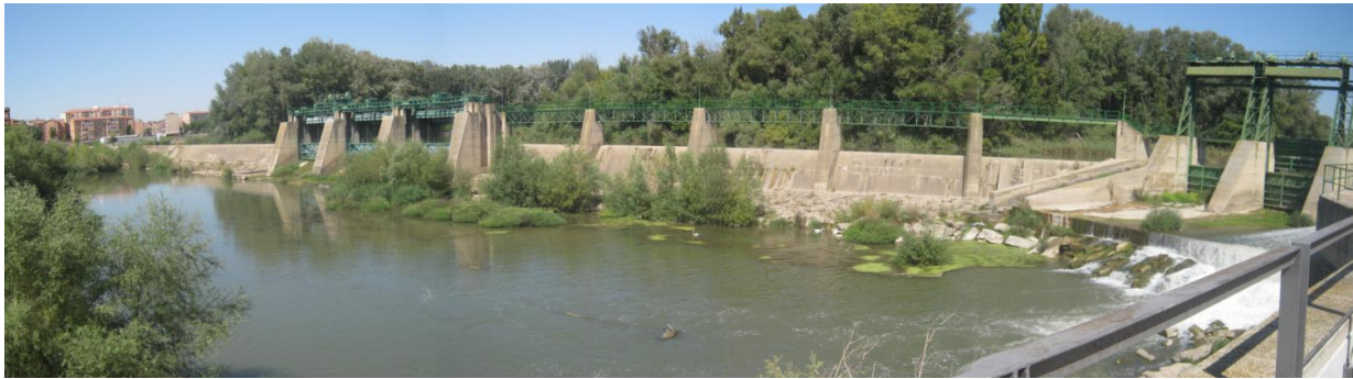
Figura 63. Vista panorámica del azud del canal de Serós. Esta estructura cuenta con dos pasos de peces.
