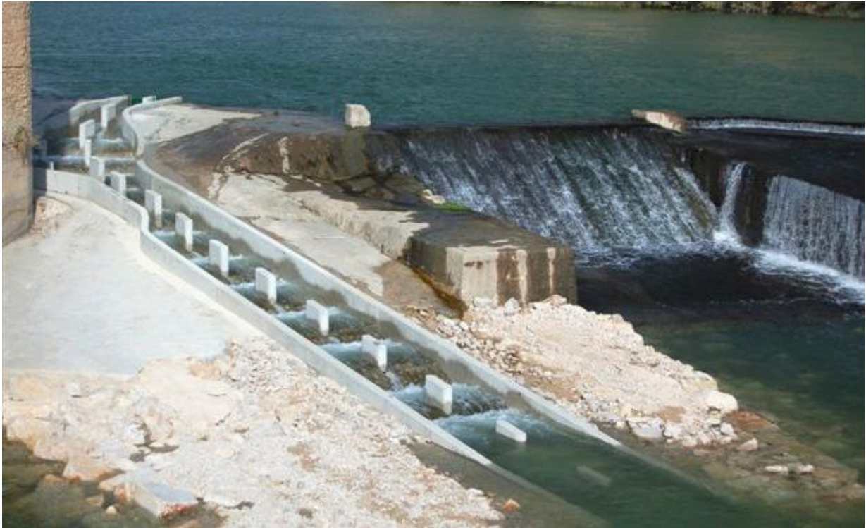
Figura 75. Paso nuevo del azud de Cherta donde el vertido entre artesanías es en el libre, además el caudal de llamada es muy reducido.
