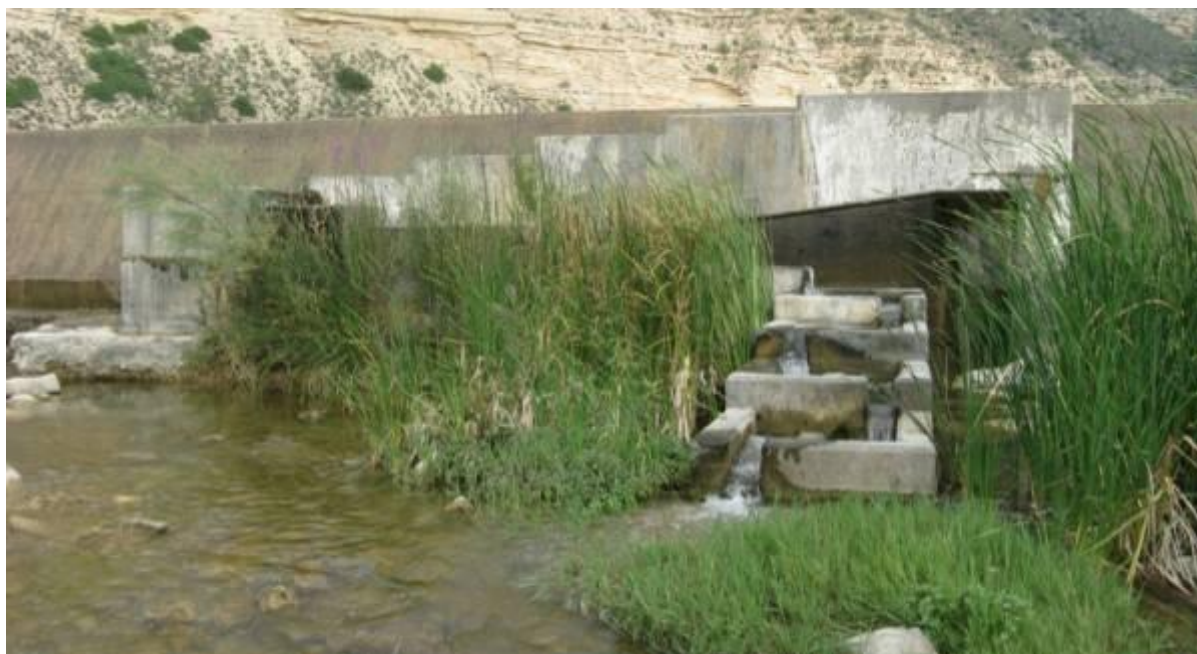
Figura 63. Escala de peces azud de la C.R. del Embatallador localizada en el centro del azud. Este paso no dispone de caudal de llamada que favorezca la atracción de los peces a la entrada del paso.
