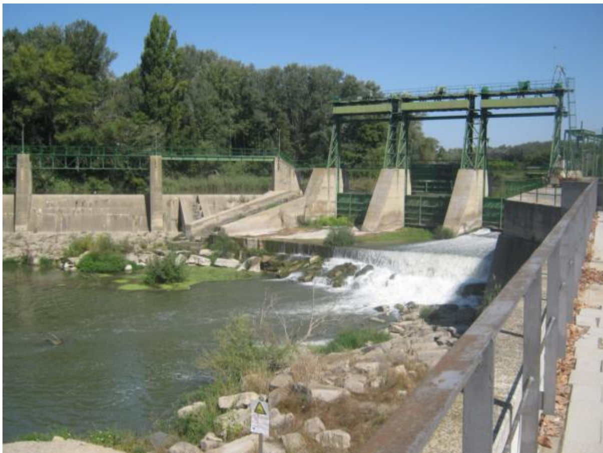
Figura 64. Detalle del costado izquierdo del azud donde se encuentran las dos escalas de artesas.
