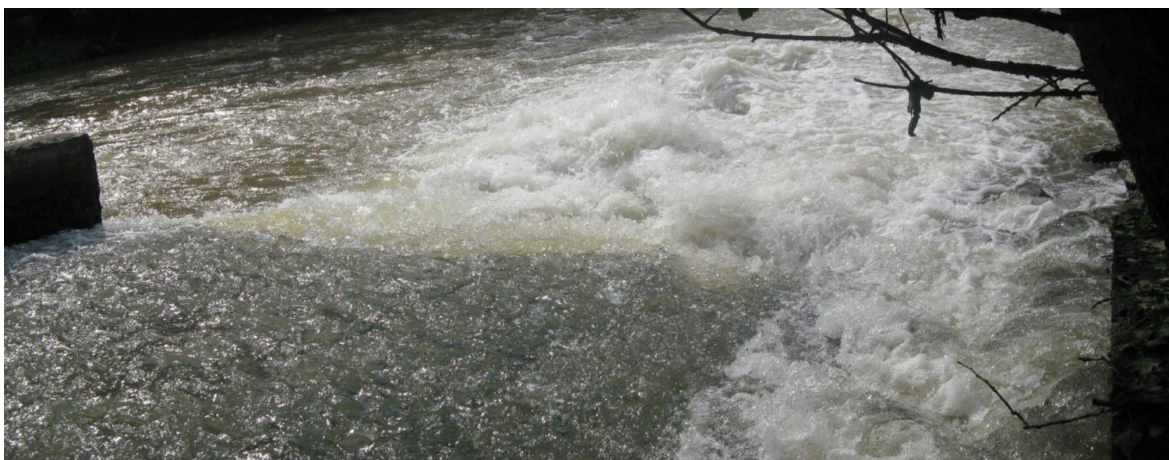
Figura 48. Vista de la entrada al paso el cual está descolgado de la lámina del río de aguas abajo del azud y la energía del agua en esta zona es muy elevada.
