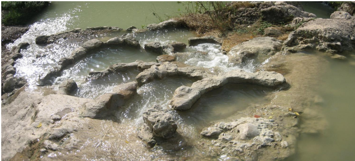
Figura 4. Vista desde aguas arriba del paso de peces donde se puede observar las pequeñas dimensiones de las artesanías
