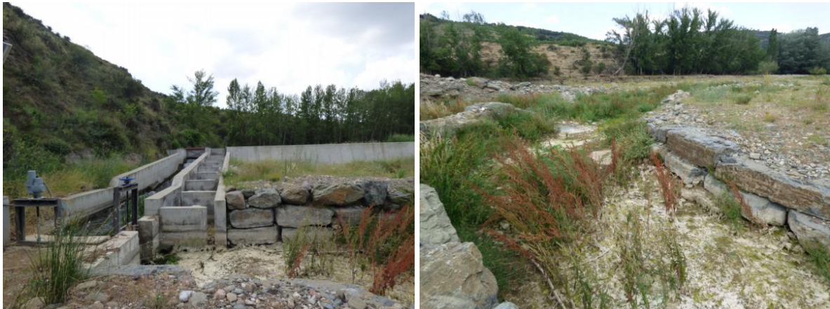
Figura 5. Poza de entrada al paso durante la visita de campo en verano de 2018. El paso se encontraba totalmente seco.
