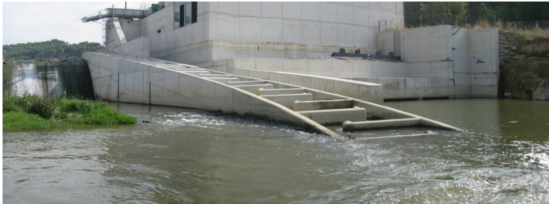
Figura 38. Entrada del paso para los peces, la cual varía en función del nivel de la lámina de agua de agua abajo del azud. La entrada de caudal a la escala carece de deflector.
