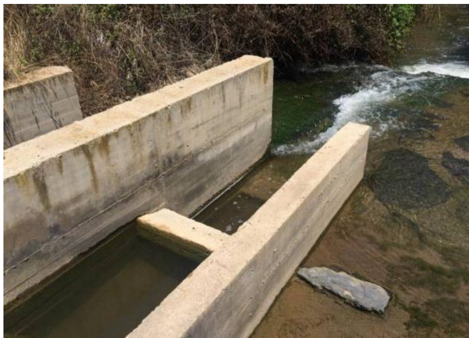
Figura 82. Entrada al paso de la escala del azud de la CR de Ablitas.
