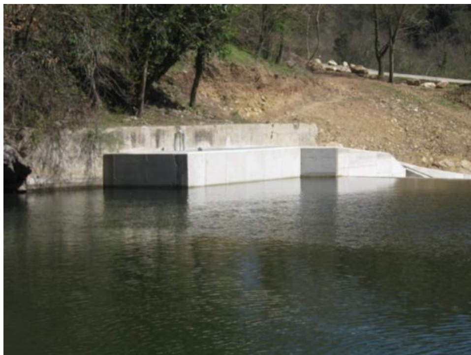
Figura 33. Vista del paso de peces aguas arriba del azud. El muro exterior se encuentra recrecido para que durante periodos de crecida el río no desborde el paso.
