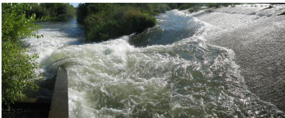
Figura 93. Vista de la entrada a la escala, la gran acumulación del agua vertiente por parte del paramento del azud genera unas turbulencias en la entrada del paso, dificultando a las especies piscícolas entrar en él.
