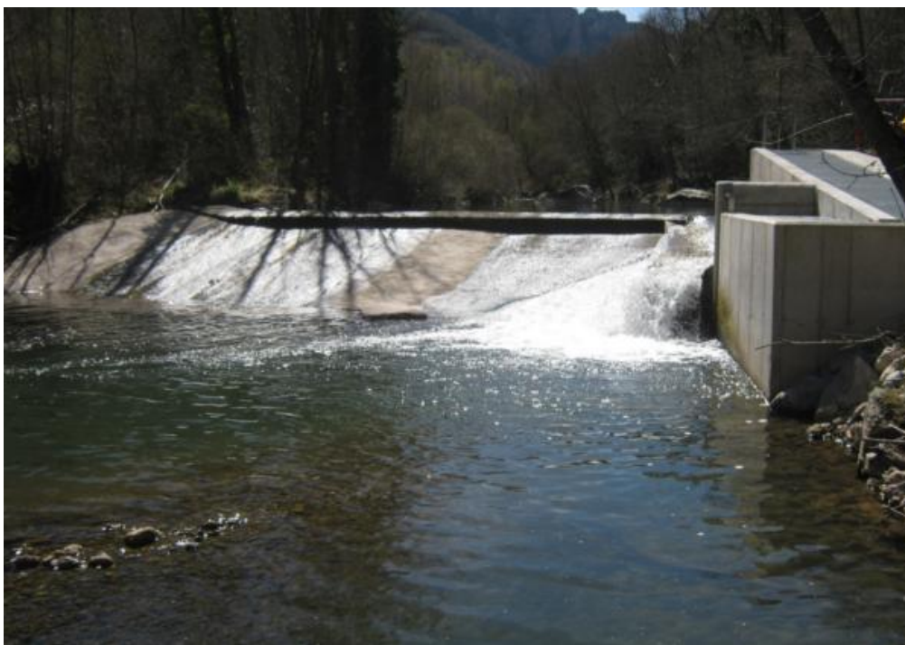
Figura 19. Azud y la escala de la C.H de Panzares durante la visita de campo en junio de 2017.
