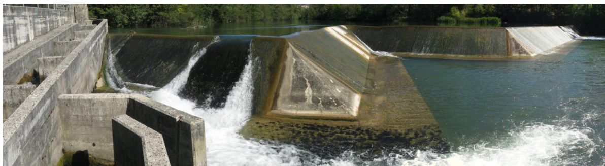
Figura 69. Escala en la zona central del azud de la Central Hidroeléctrica de Oroz-Betelu.
