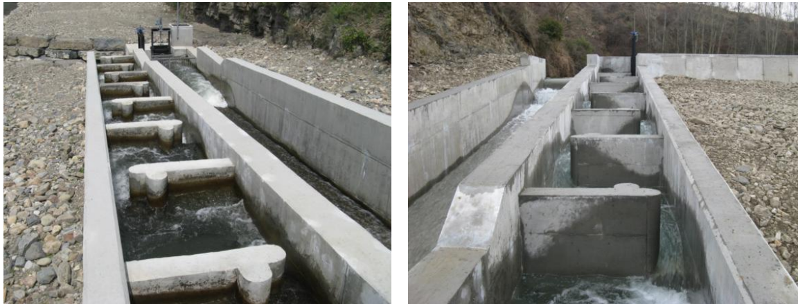
Figura 6. Escala de artesas en 2011 ( el vertido es semisumergido y la energía en el interior de las artesas es muy baja).
