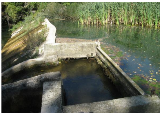
Figura 74. Izquierda, artesa que regula tanto el caudal de entrada a la escala como el del estanque diseñado para incrementar el efecto llamada en la entrada del paso. Derecha, entrada de caudal al paso y primer vertedero que se encuentra descolgado.
