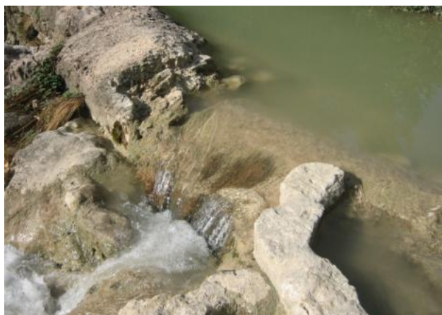
Figura 5. Izquierda: entrada de caudal al paso mediante un vertido en libre. A la derecha, entrada para los peces al paso, desconectada de la lámina de aguas abajo del azud
