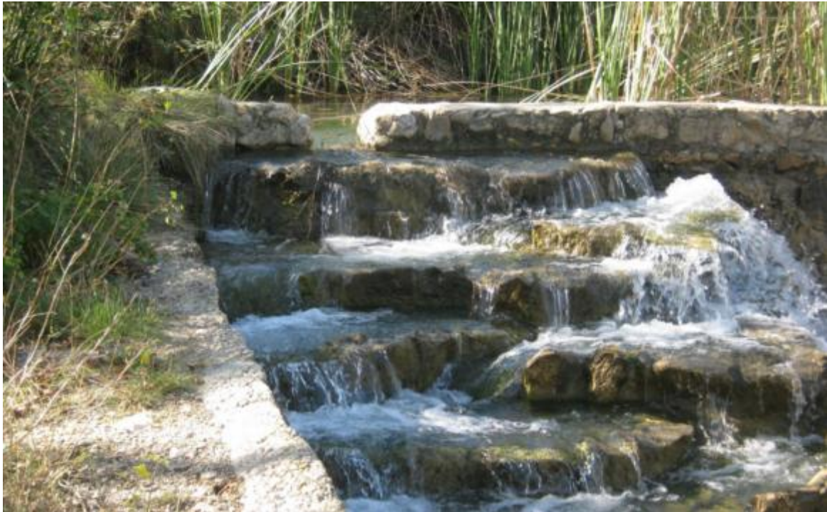
Figura 8. Vista de la entrada de caudal al paso y de los saltos con importante desnivel entre las primeras artesas.
