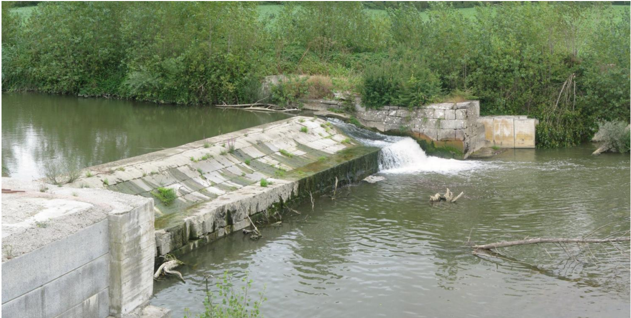
Figura 26. Azud de la Presa de la Electra de Ihabar donde la escala se localiza en el costado de la margen izquierda
