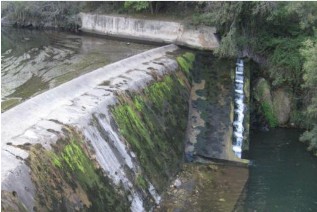
Figura 28. Azud y antiguo paso para peces de la CH de Anguiano que ha sido reemplazado por uno nuevo
