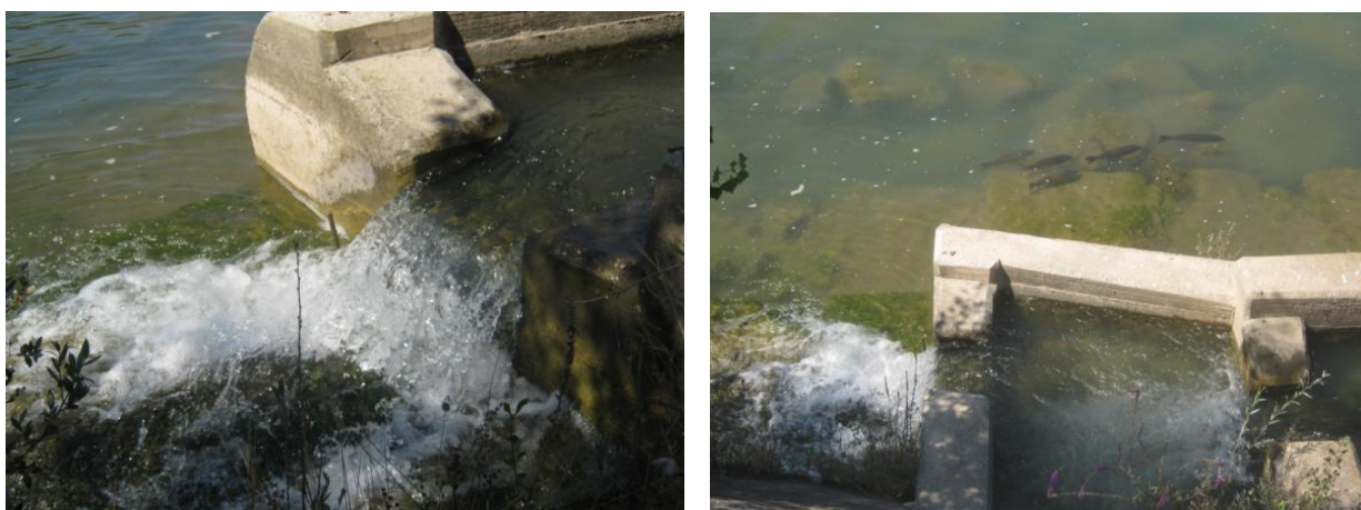
Figura 62. A la derecha, entrada al paso la cual se encuentra descolgada de la lámina del río de aguas abajo del azud. A la izquierda, primera artesa desde aguas abajo y un grupo de carpas en sus inmediaciones, antes de tomar la foto algunas de ellas se encontraban debajo del vertido de la artesa de entrada para los peces por lo que existe cierta llamada a la entrada del paso.
