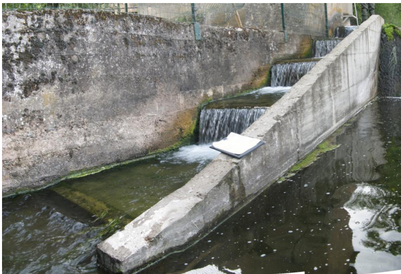
Figura 45. Escala de artesas sucesivas donde se aprecia el elevado salto entre artesas. La entrada a la escala no conecta directamente con el río, por lo que los peces para acceder a ella deberán superar el salto que representa el colchón amortiguador. También se aprecia que el efecto llamada en la entrada del paso es inexistente.
