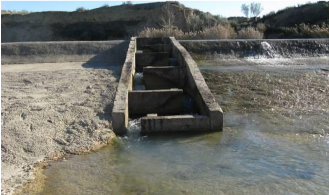
Figura 31. Vista de la escala de artesas sucesivas del azud de la Estacada de la Huerta Alta del Gállego. Todos los vertederos presentan un vertido libre excepto la entrada para los peces a la misma del azud de.
