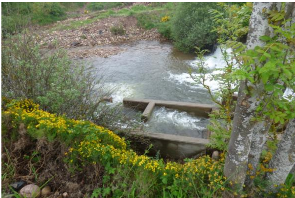
Figura 11. Últimas dos artesas construidas para mejorar la entrada al paso para los peces en la escala del azud de la toma de aguas de Reinosa en Espinilla.
