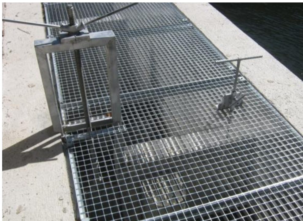
Figura 32. Compuertas instaladas en el primer vertedero sumergido y orificio de fondo para la impermeabilización del paso
