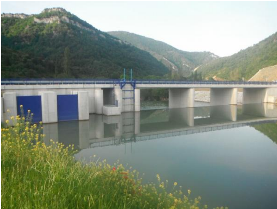
Figura 63. Remanso y azud de la presa de cola de Itoiz (Ortiz-Betelu) desde aguas arriba. En el costado izquierdo del azud se encuentra la entrada de caudal al paso
