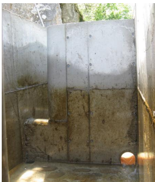
Figura 12. Tabiques interiores de la escala, donde los cantos de los vertederos se encuentran redondeados con el propósito de disminuir turbulencias no deseadas, que se generarían en el caso de presentar aristas vivas, así como disminuir posible daños a los peces cuando remontan el paso
