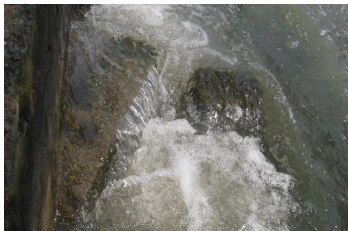
Figura 47. Detalle del paso que se asimila a un paso denil o de ralentizadores.
