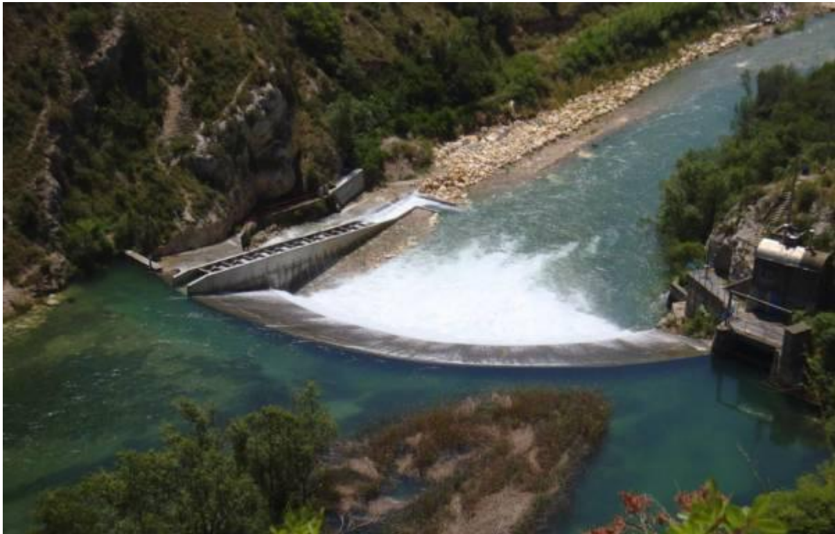
Figura 77. Vista cenital del azud y la escala de peces del Canal de Pinyana. Parte de los caudales que vierten por el paramento del costado izquierdo del azud entran en la última artesa del paso, incrementándose considerablemente el caudal que discurre por esta parte del paso. Fuente: Luis Alfonso Felix.
