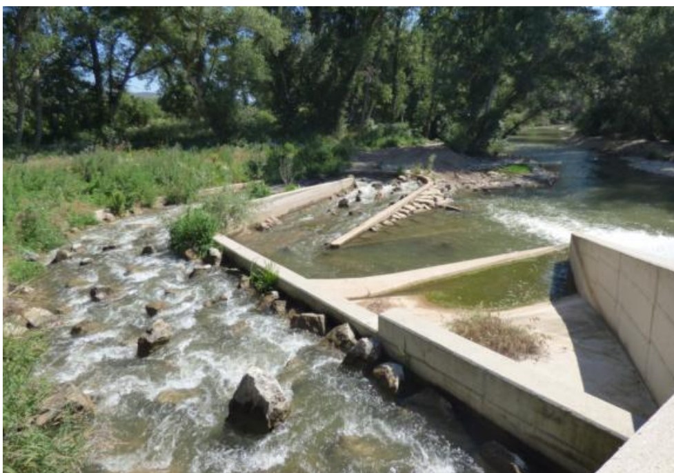
Figura 68. Rampa de bloques de perturbación de la CH. de Buicio
