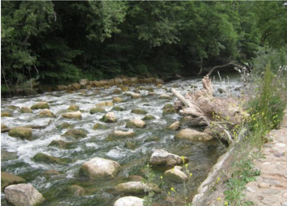
Figura 48. Rampa de bloques de perturbación del azud de la C.R de Cenicero con caudales más bajos durante una visita en el año 2015.
