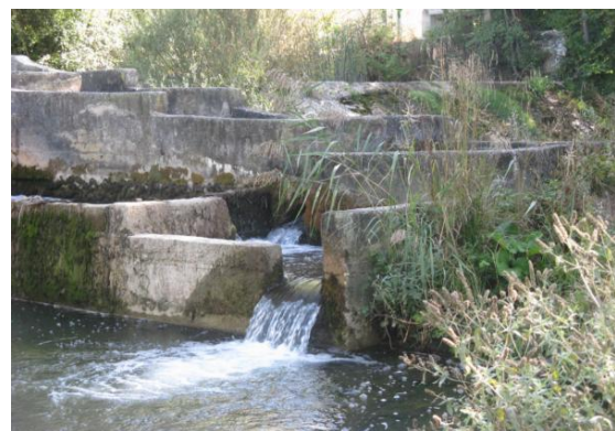
Figura 74. Izquierda, artesa que regula tanto el caudal de entrada a la escala como el del estanque diseñado para incrementar el efecto llamada en la entrada del paso. Derecha, entrada de caudal al paso y primer vertedero que se encuentra descolgado.
