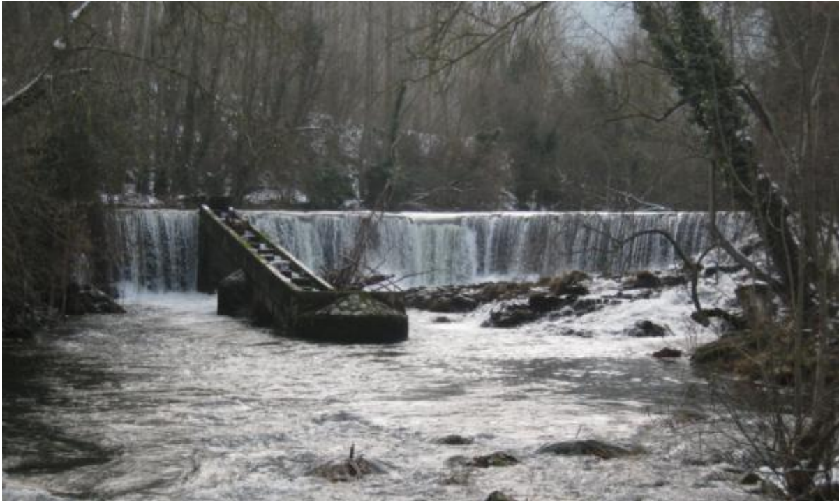
Figura 38. Azud y la escala del Molino de Cuevas. Este aprovechamiento se encuentra fuera de uso al igual que la escala de peces.
