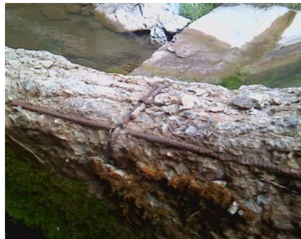
Figura 54. Salto de entrada a la escala del azud de la CH. Castellas. Este salto es muy elevado (> 30 cm) limitando la entrada al paso para los peces. A la derecha, detalle de un tabique lateral del paso donde se aprecia el mal estado de la estructura.
