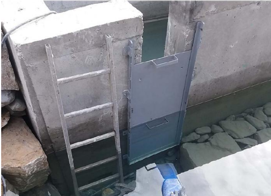
Figura 19. Vista de la compuerta de entrada de los peces al paso.
