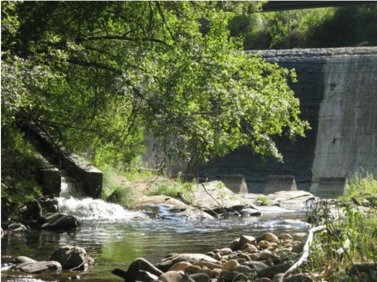
Figura 9. Entrada a la escala en el azud de la Toma de Aguas del embalse de González Lacasa (el Tollo); la entrada al paso se encuentra desconectada de la lámina del río de aguas abajo del azud.
