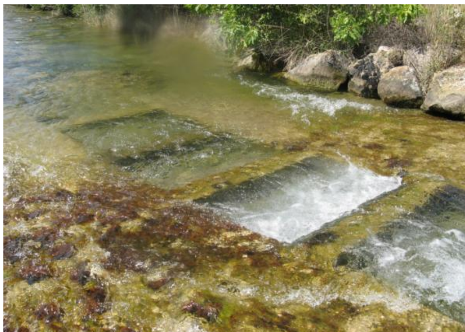
Figura 28. Detalle del paso del azud de la piscifactoría de Santa Ana desde la coronación del azud. En la foto se aprecia la ausencia de llamada en la entrada del paso.
