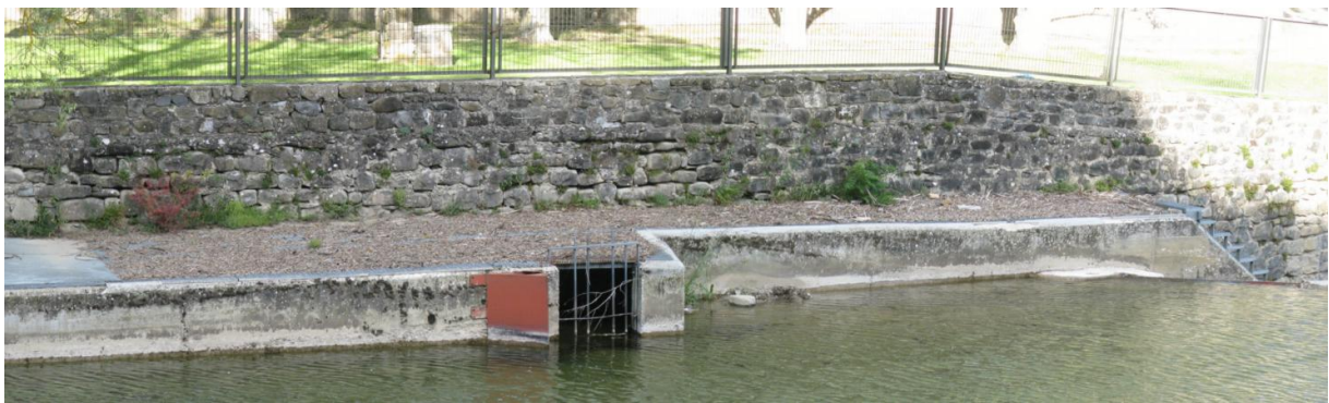
Figura 11. Vista de la entrada de caudal al paso, como se puede observar en la imagen, la sección de escala ganada aguas arriba del obstáculo es mayor que en el resto de los pasos
