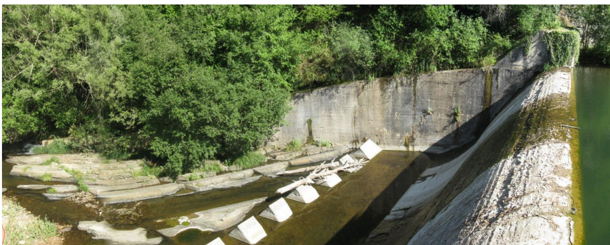
Figura 10. Vista lateral del paso el cual se encuentra cubierto por la vegetación.
