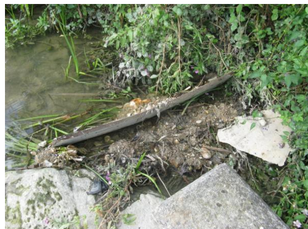
Figura 25. Vista de la entrada de caudal a la escala obstruida.
