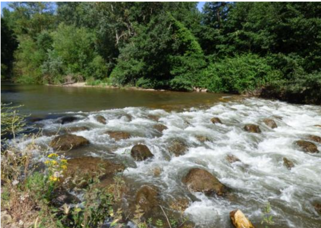
Figura 49. Detalle del inicio de la rampa desde aguas arriba donde los bloques de perturbación son de menores dimensiones
