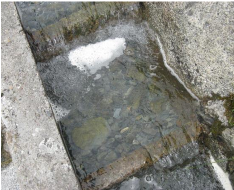
Figura 16. Detalle de una de las artesas en las que se puede apreciar el grado de colmatación de las artesas.
