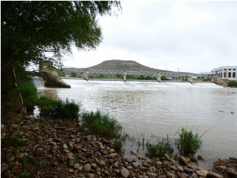
Figura 73. Azud de la CH de Las Norias donde el paso se localiza en el costado de la margen derecha
