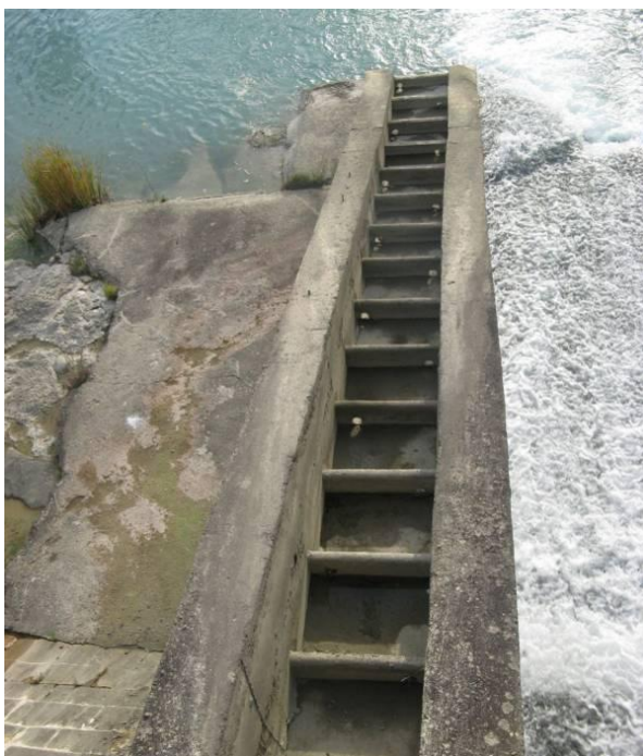
Figura 30. Imágenes de la escala de peces del azud de la C.H. de Javierrelatre II donde se puede observar el bajo calado de las artesas y las pequeñas dimensiones de los orificios de limpieza. Además no circula caudal por el paso y la entrada al mismo no está conectada con la lámina del río de aguas abajo del azud.
