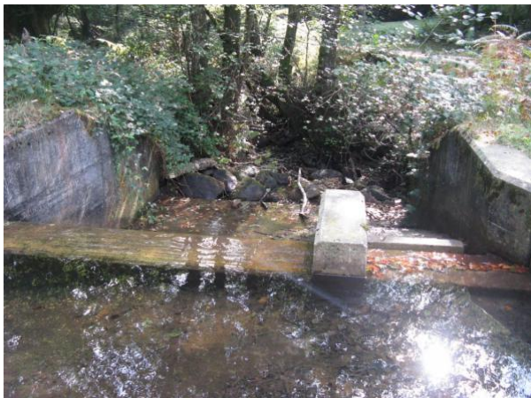
Figura 8. En la imagen de la izquierda se puede apreciar la sección de entrada al paso y en la imagen de la derecha el reducido tamaño de las artesas.
