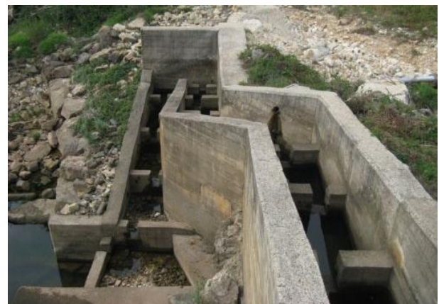
Figura 5. Izquierda, vista de la entrada de caudal obstruida por vegetación acuática. Derecha, escala de peces desde la coronación del azud donde alguna artesa se encuentra parcialmente colmatada.
