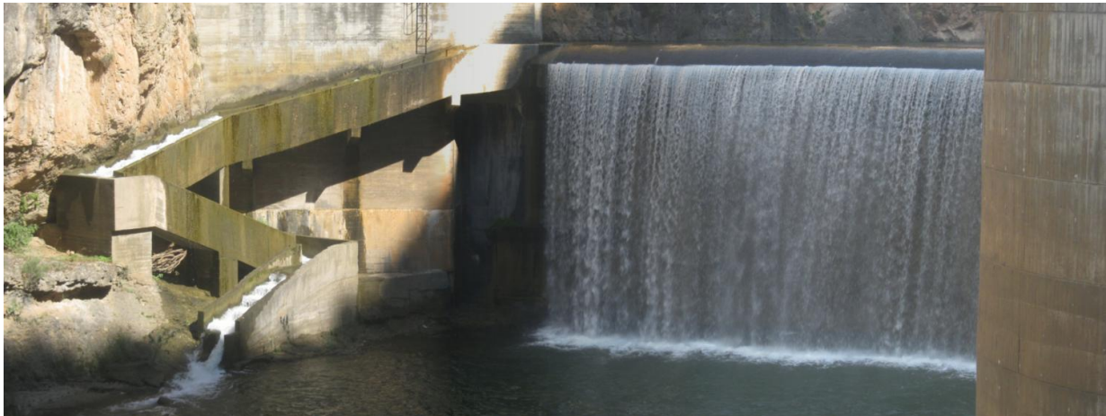
Figura 57. Vista del Azud de la CH Alós y de la escala de peces de artesas sucesivas en vertido libre. Este paso presenta una elevada pendiente. Además, la entrada al mismo se encuentra muy alejada de la base del azud.
