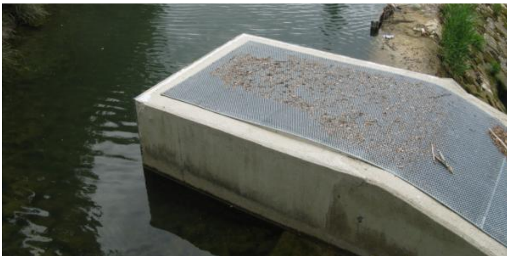
Figura 81. Artesa de entrada de caudal a la escala de peces del azud de la CH. de Oronz cubierta con un tramex.
