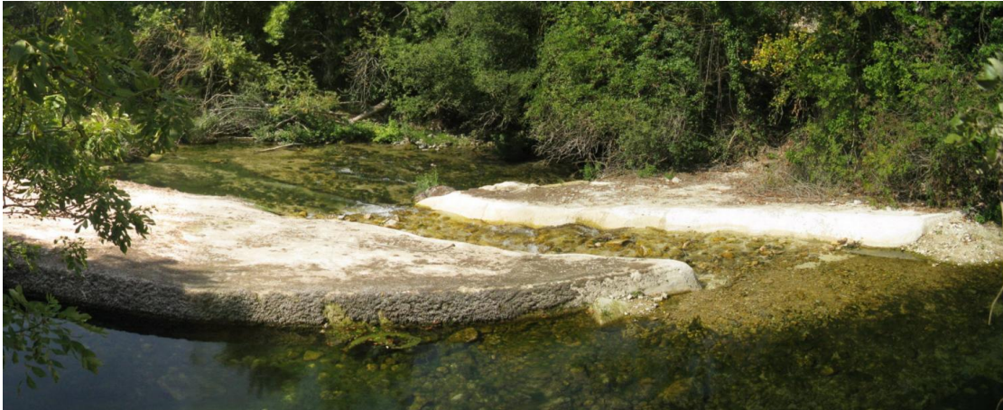
Figura 41. Rebaje practicado en el paramento del azud del Molino viejo de Barindano.
