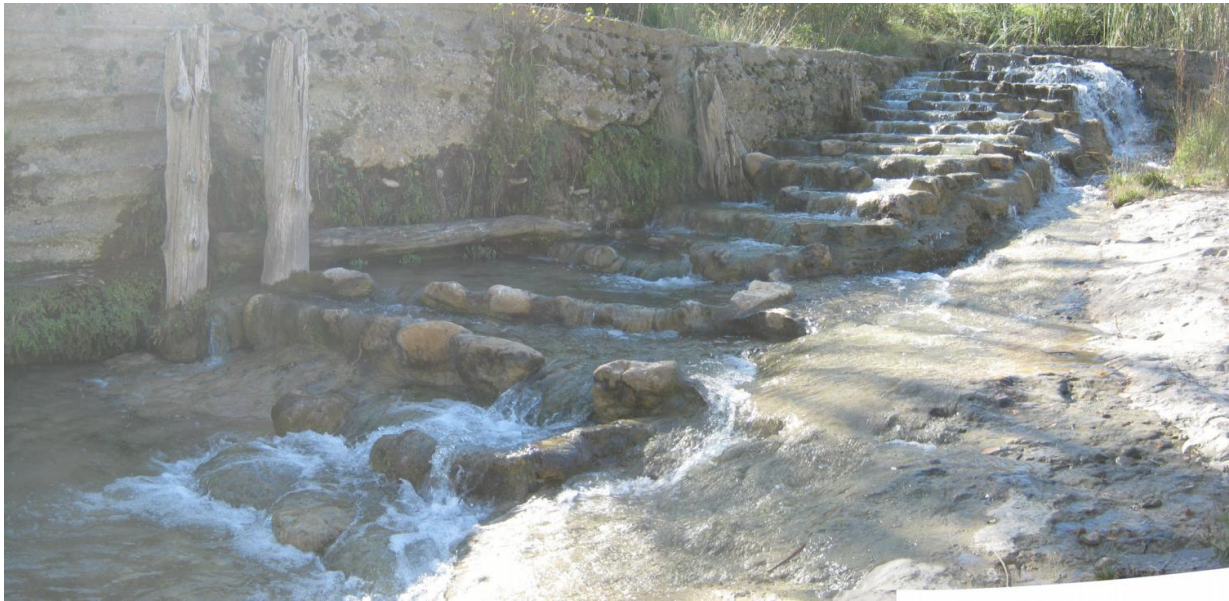
Figura 6. Panorámica del paso del azud del Molino Vilar desde aguas abajo. En esta fotografía se aprecia que algunas artesas se encuentran desbordadas
