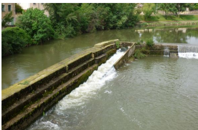
Figura 12. Vista frontal de la escala de peces del azud de la C.H. de la Arboleda donde se aprecian las turbulencias existentes en el paso.
