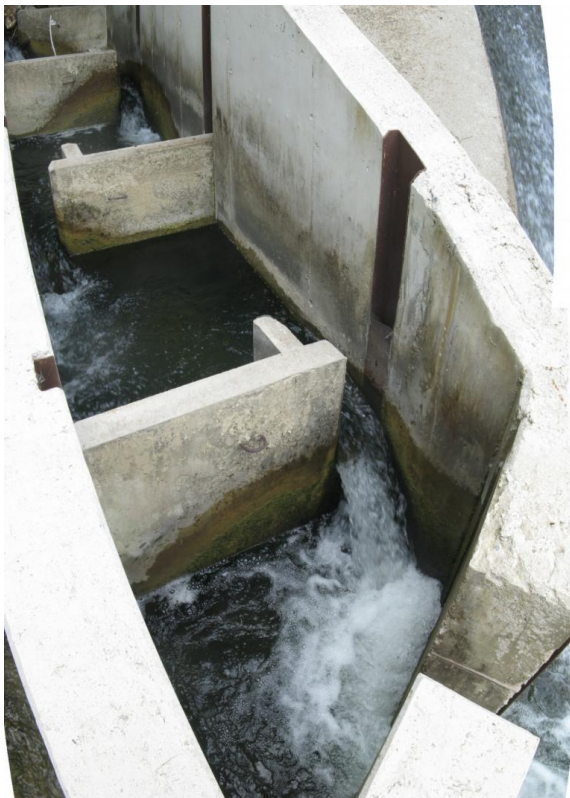
Figura 78. Paso de peces de la CH. de Ezcároz. Izquierda, elevado salto en el primer vertedero desde la entrada a la escala para los peces. Derecha, obstrucción de varios vertederos.
