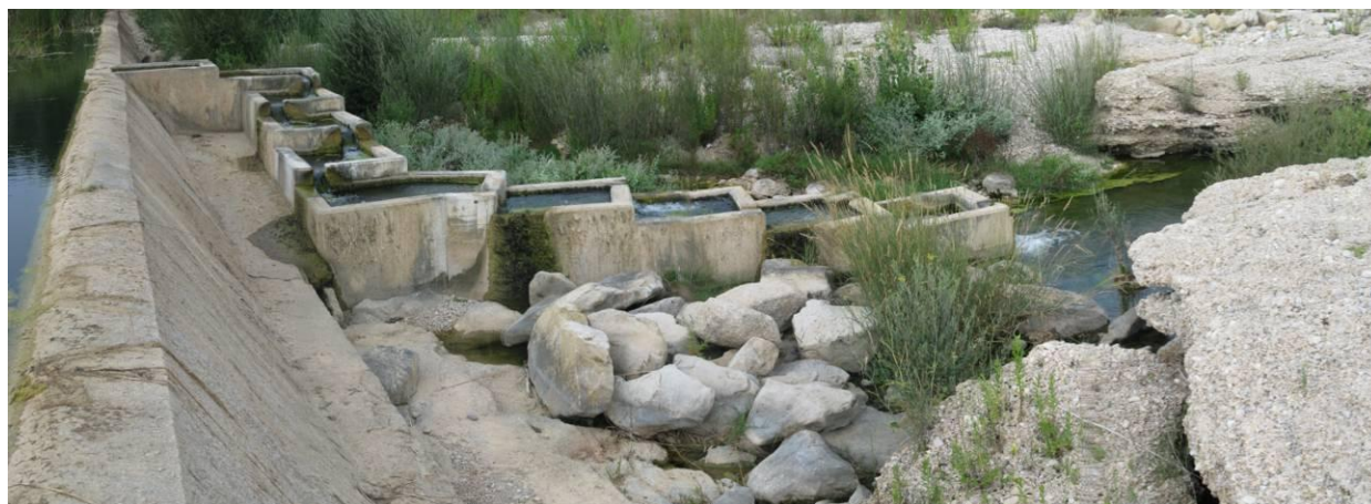
Figura 49. Vista de la escala de peces de artesas sucesivas del azud de la acequia de la comunidad de regantes de Vilanova. La escala se emplaza en el centro del azud y conecta aguas abajo con el brazo principal del río Matarraña.
