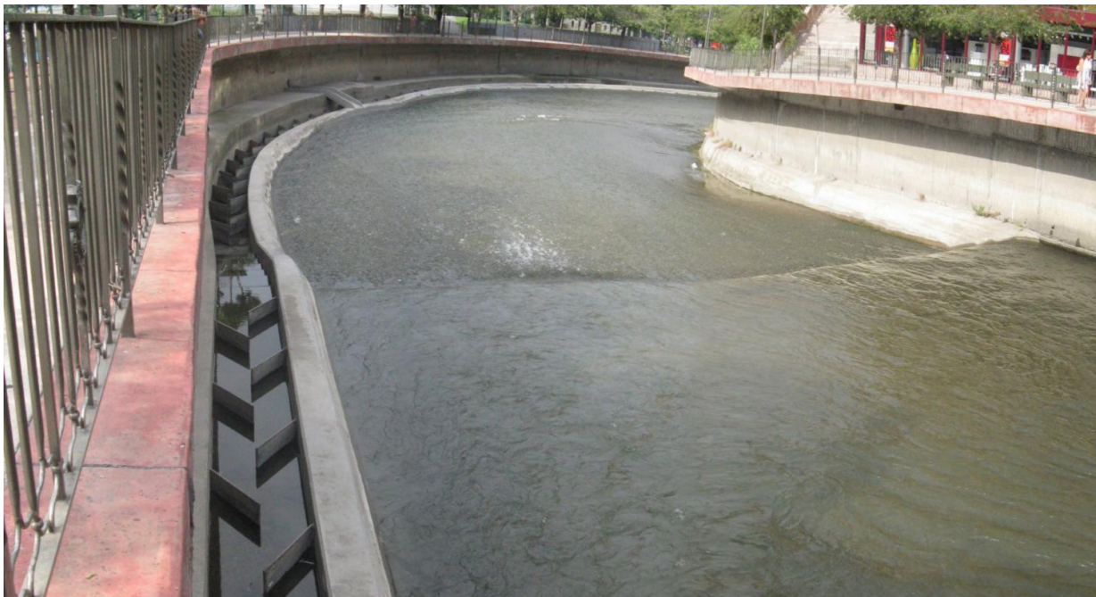
Figura 9. Vista de un tramo curvo del tercero de los pasos donde se aprecian los deflectores y los tabiques metálicos.
