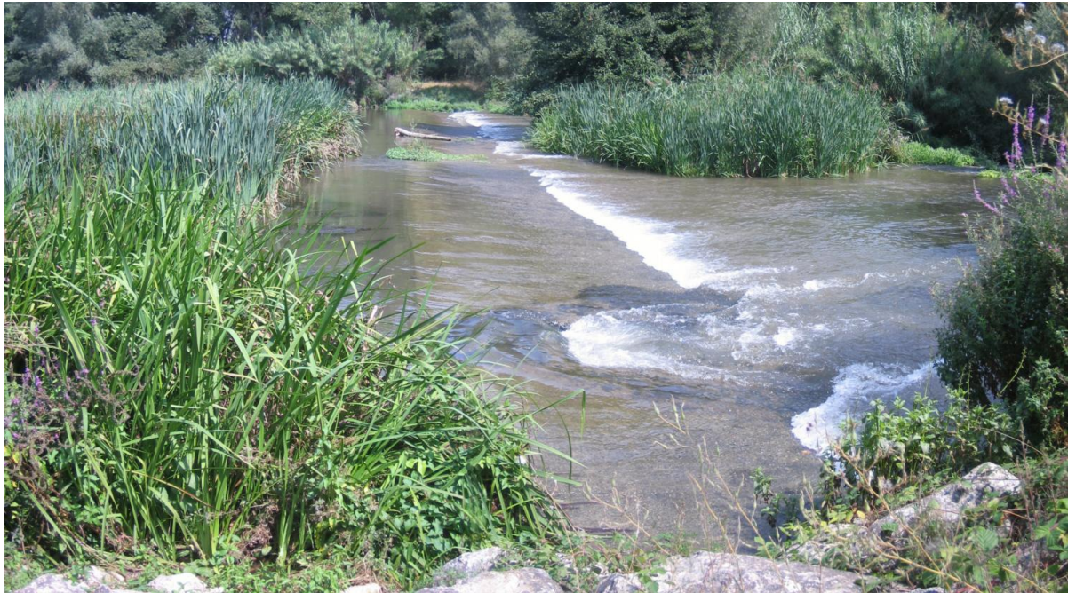
Figura 38. Vista del azud de Corbins y de las artesas excavadas en el paramento del azud en el costado de la margen derecha
