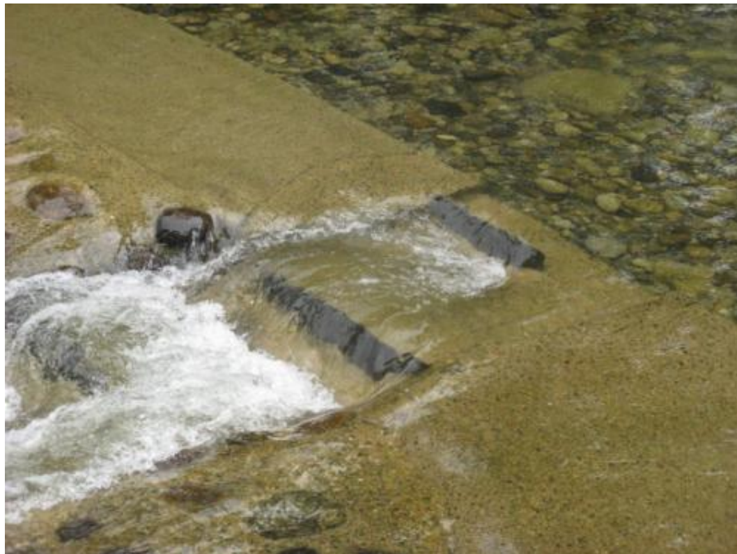
Figura 42. Detalle de la entrada de caudal al paso del azud de la Comunidad de Regantes de la acequia de Ventajola y de las planchas metálicas instaladas a modo de tabique. El funcionamiento del paso es muy variable a los caudales circulantes por el río.
