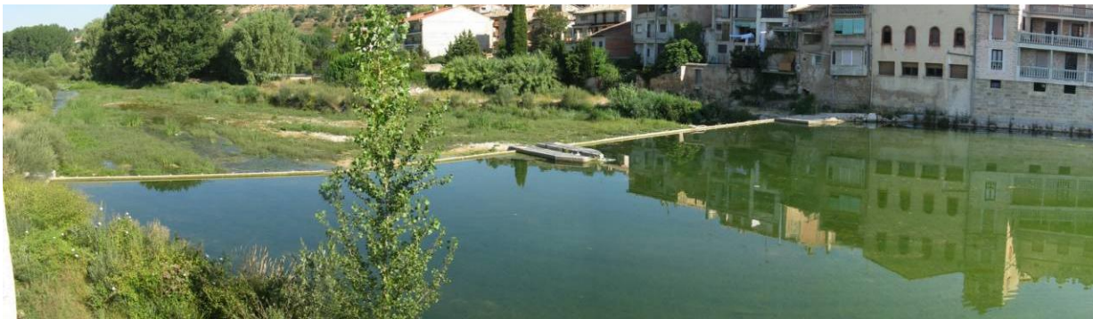
Figura 41. Vista del azud de la C.R de la acequia Mayor de Valderrobres y la escala de peces localizada en el centro y aguas arriba de la estructura transversal. Cabe indicar que este azud es abatible.
