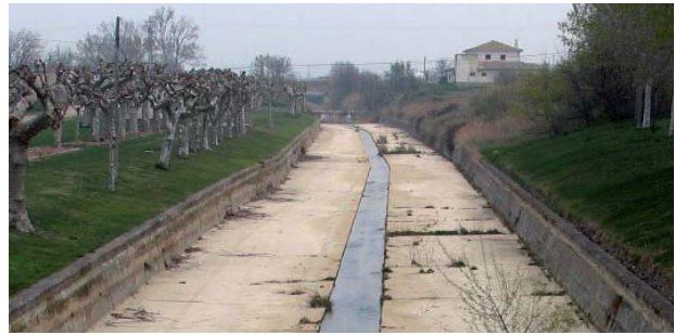
Canalización del río Riguel a su paso por Sádaba (Zaragoza).
