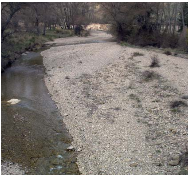
Abundancia de sedimentos de mediano calibre en el lecho del río Arba de Biel.
