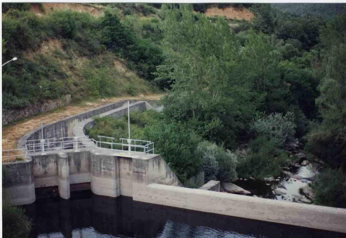
Foto nº 109 Azud de derivación canal alimentador del embalse de Ortigosa.
