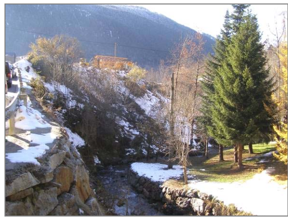
Aspecto del río Unhòla a su paso por Unha, recrecimiento del talud de la margen izquierda con material de relleno.
