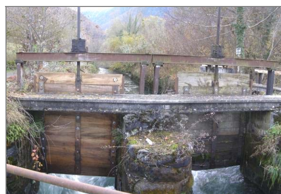
Compuertas del canal de la CH Molino Viejo.
