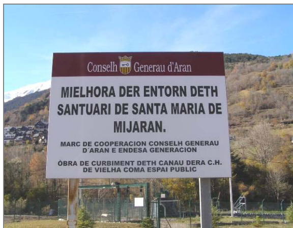
Panel informativo de la obras de cubrimiento del canal de la CH de Vielha como espacio publico
