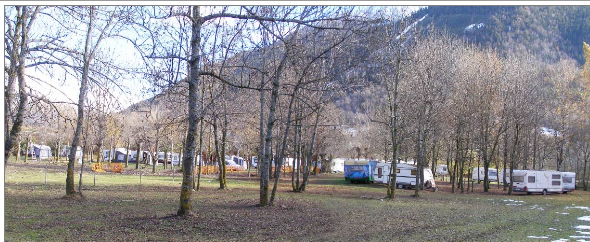
Camping Era Yerla d' Arties sobre la margen derecha del Garona, situado sobre terreno rellenado presenta problemas en épocas de avenida.
