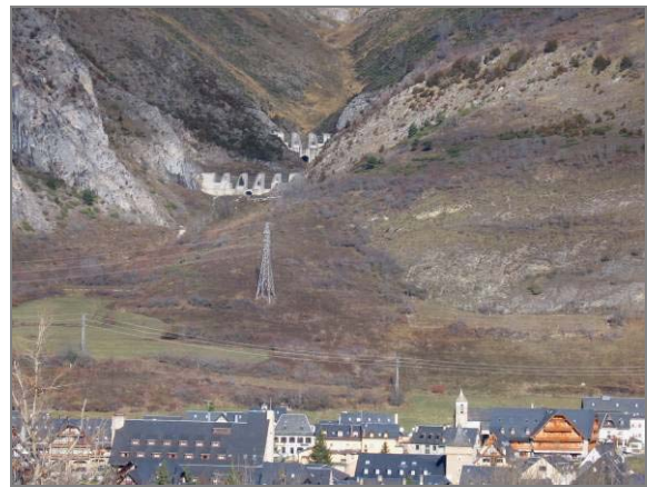
Presas para el control de avenidas sobre el barranco de Artigues en Arties
