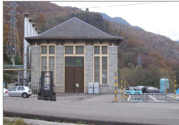
Piscifactoría Caviar Nacarii, las instalaciones aprovechan la infraestructura de la antigua CH de Clade para calentar el agua para la crianza del esturión.
