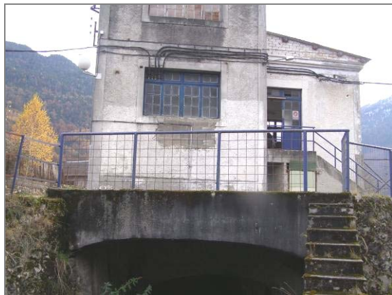
Central hidroeléctrica de Molino Viejo en el casco urbano de Bossòst
