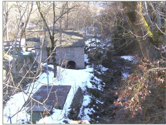
Fosa séptica sobre la margen derecha del río Unhòla a su paso por Unha
