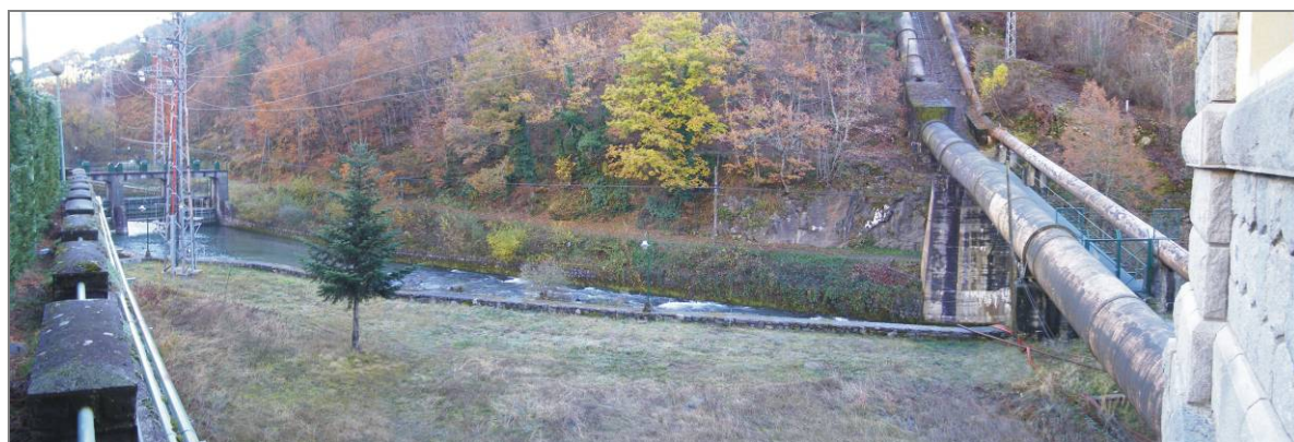
Presas de la CH Benós y tubería a presión de Benós y Joèu
