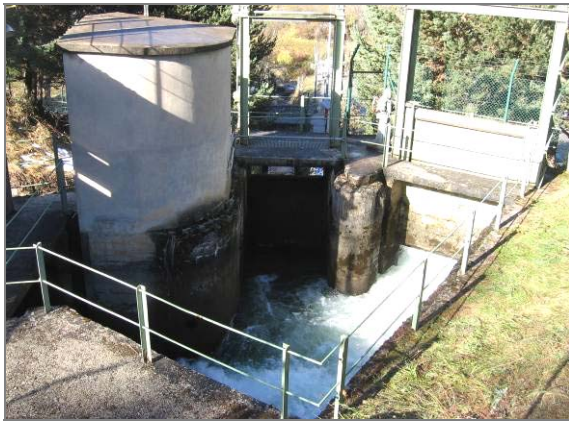
Canal de la central hidroeléctrica de Arties
