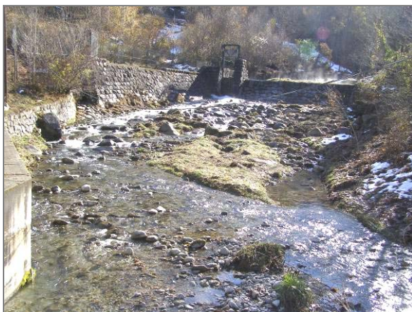
Azud del río Valarties en Arties, derivación para la CH de Vielha
