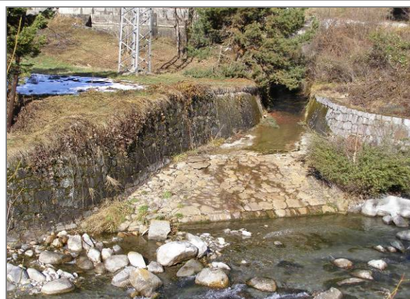
Aliviadero del canal de la central hidroeléctrica de Vielha en Arties
