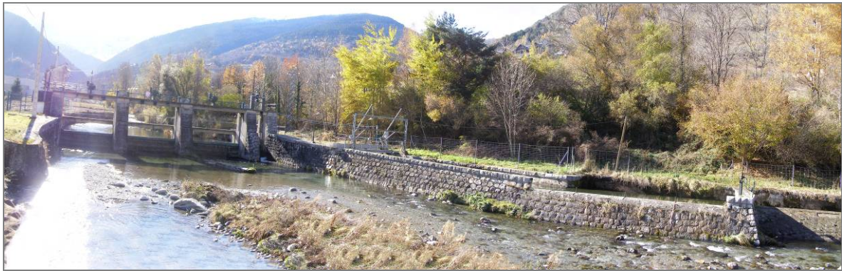
Azud de la CH de Benòs en Vielha, recibe la descarga de la CH de Vielha, no cuenta con escala de peces
