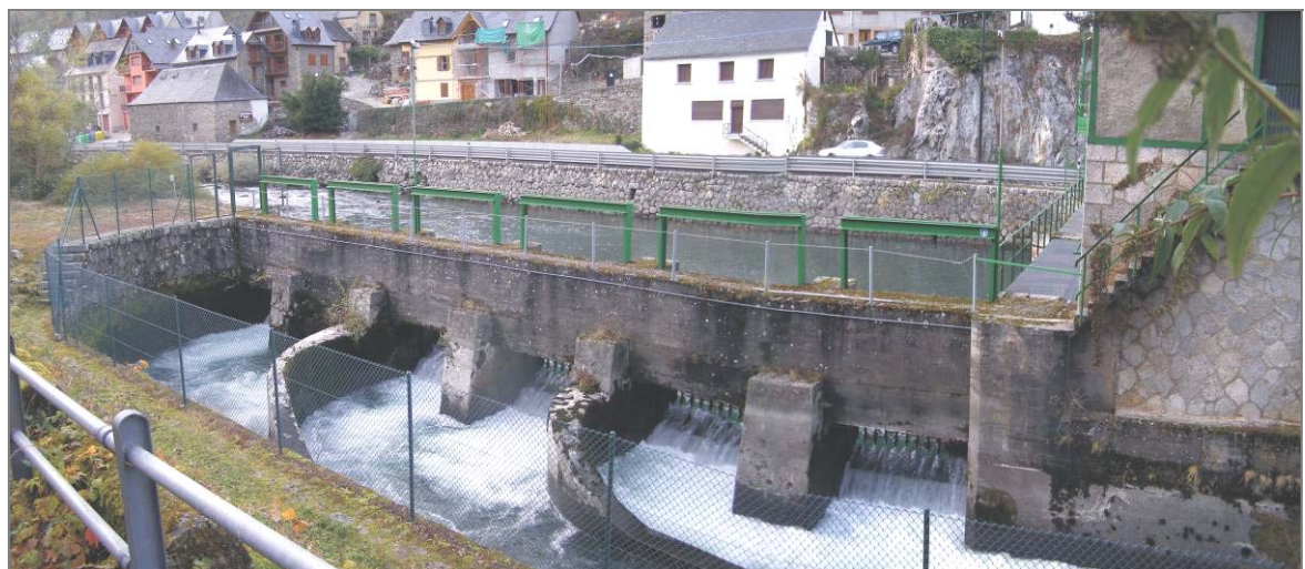
Canal de derivación de la CH de St. Joan de Toran
