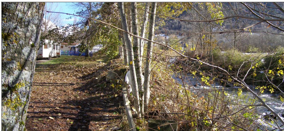
Camping Era Yerla d' Arties sobre la margen derecha del Garona, situado sobre terreno rellenado presenta problemas en épocas de avenida.
