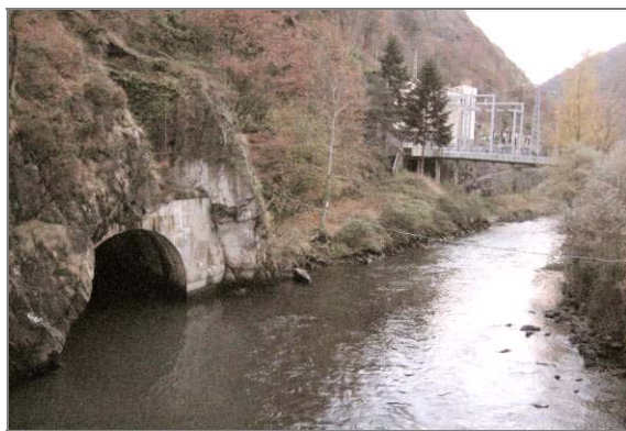
Central hidroeléctrica Pònt de Rei
