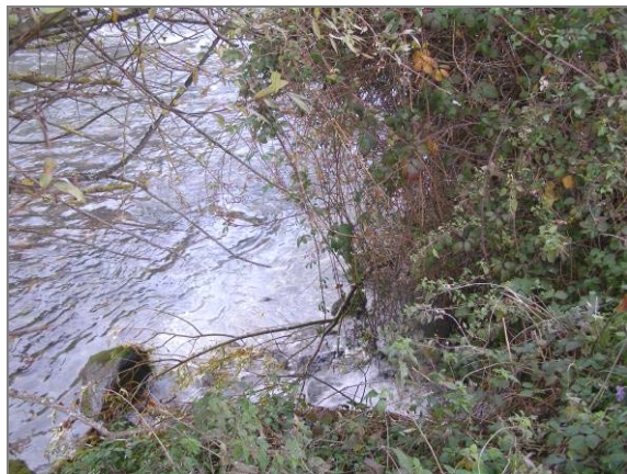
Punto de vertido de la EDAR de Bossòst
