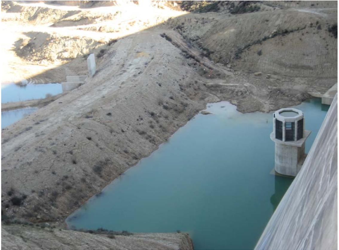
Ref. 19.- Embalse de Montearagón: detalle de la entrada de agua en el desagüe de fondo.
