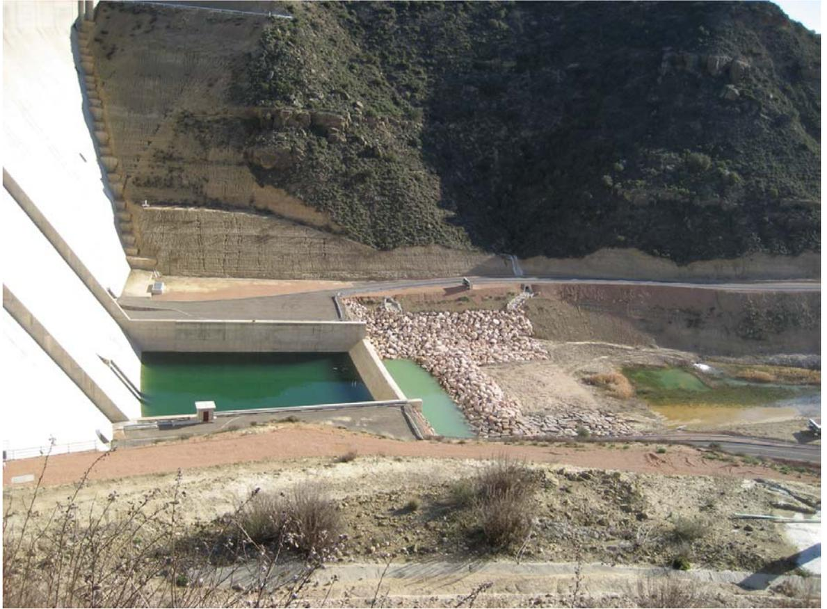
Ref. 15.- Embalse de Montearagón: detalle de la salida de agua por el desagüe de fondo.
