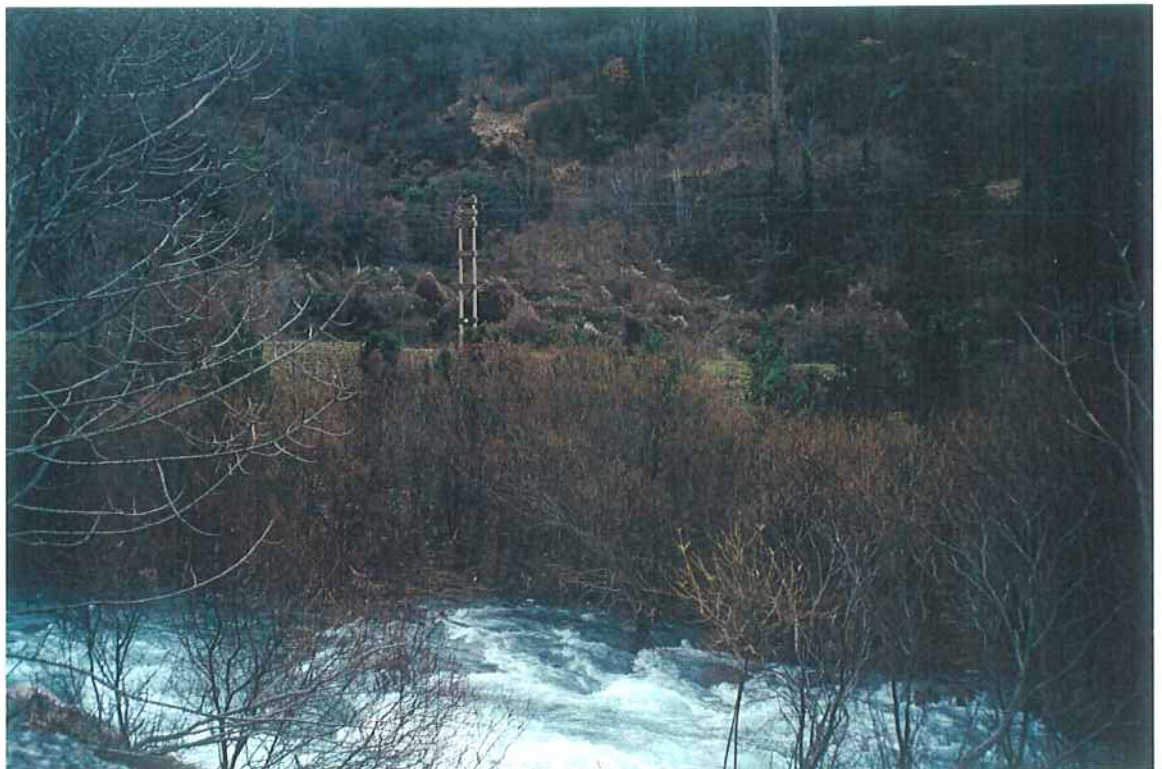
LINEA ELÉCTRICA EN MARGEN EZQUIERDA
