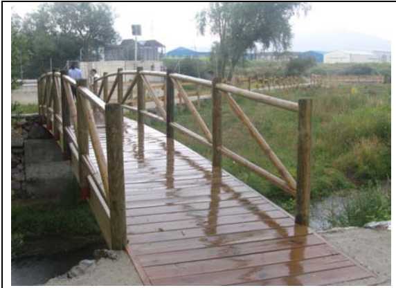
Pasarela y senda que se ha construido recientemente en el río Híjar dentro del casco urbano de Reinosa y que en alguna avenida podría provocar algún tipo de retención del agua
