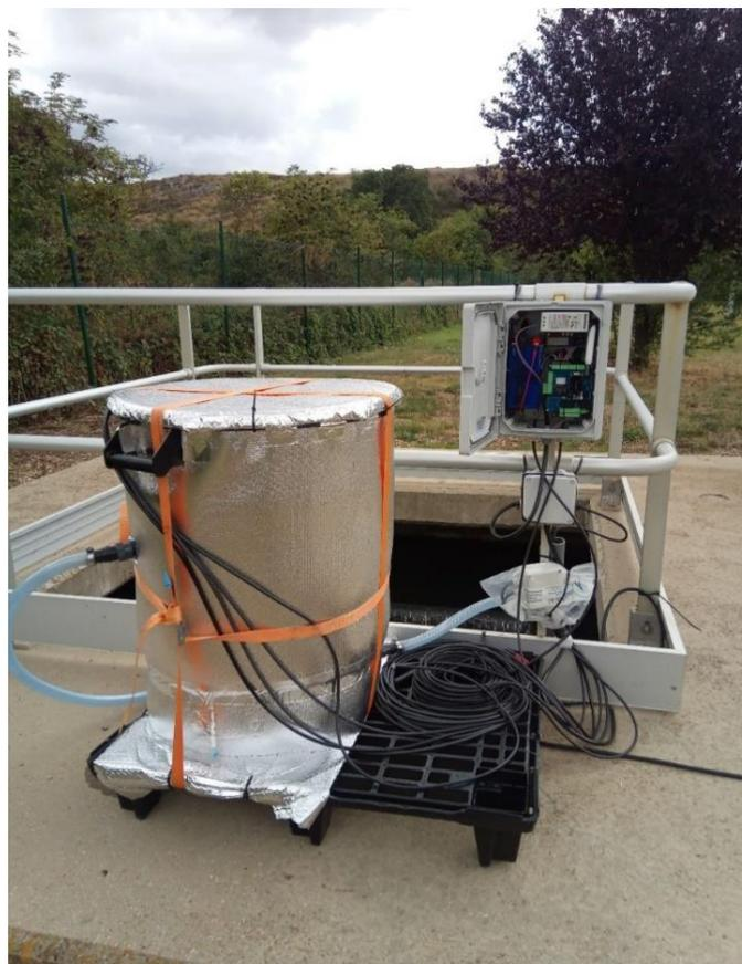
**Figura 18.** Tanque de mediciones y sistema de control en la arqueta de vertido de la EDAR de Ágreda-Ólvega (V1)
